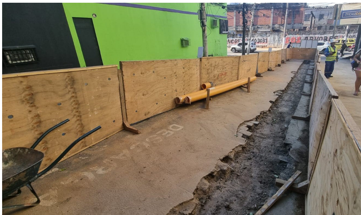
Foto 6: Assentamento de tubulação por método destrutivo – trecho que ainda precisa ser recomposto.
