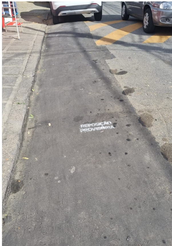
Foto 2: Trecho de recomposição provisória na via.
