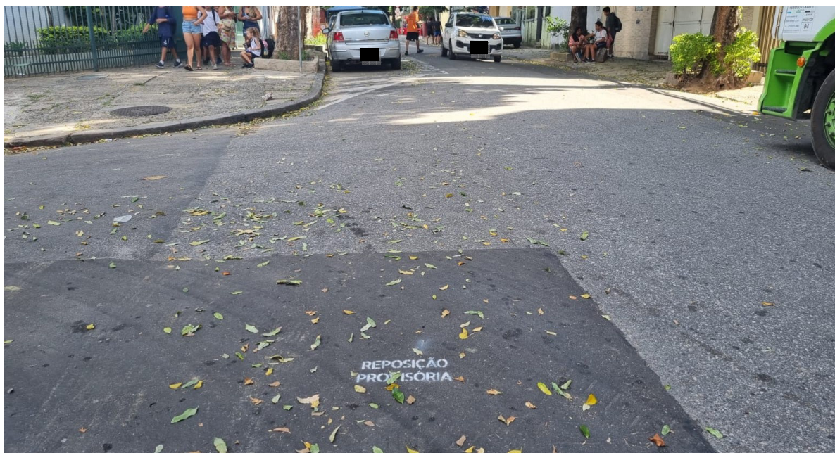
Foto 3: Trecho de recomposição provisória na via.
