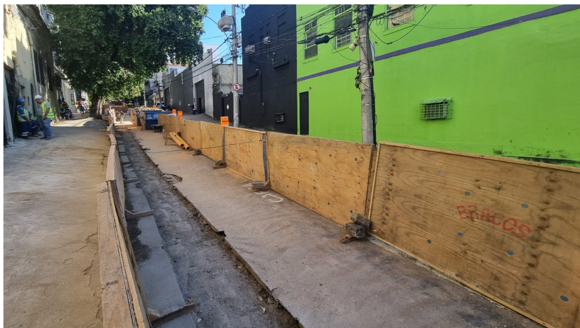
Foto 7: Assentamento de tubulação por método destrutivo – trecho que ainda precisa ser recomposto.
