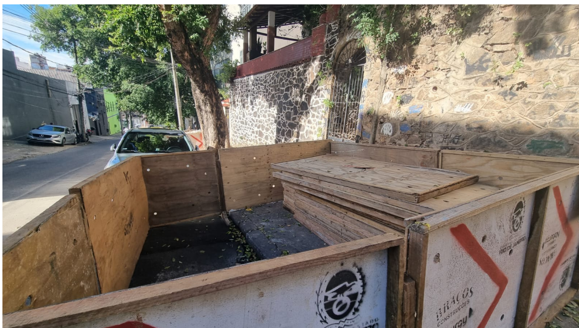
Foto 9: Área de armazenamento de material.
