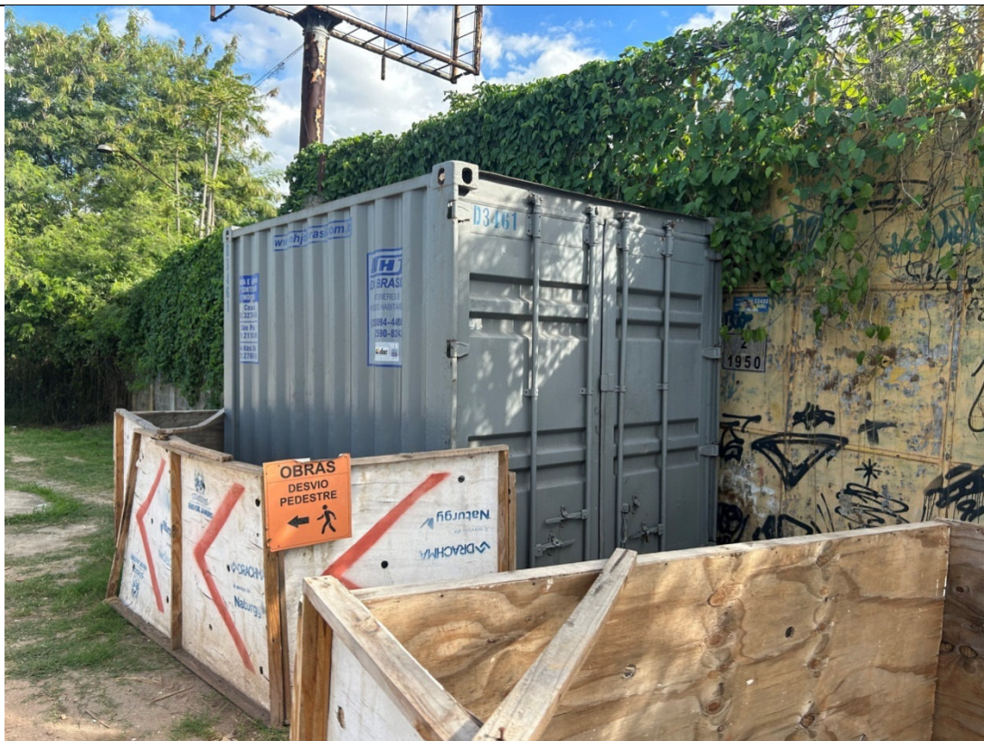
Foto 11: Container para armazenamento de material.
