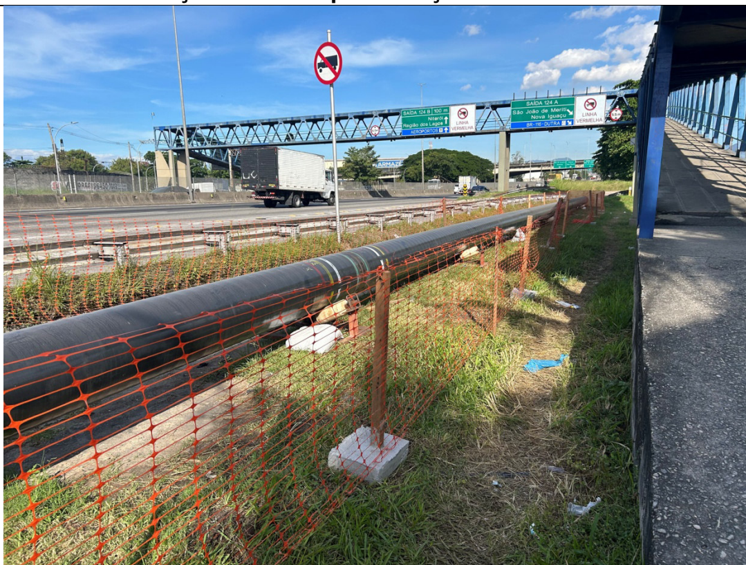
Foto 6: Ponto final do primeiro segmento de tubulação construído.
