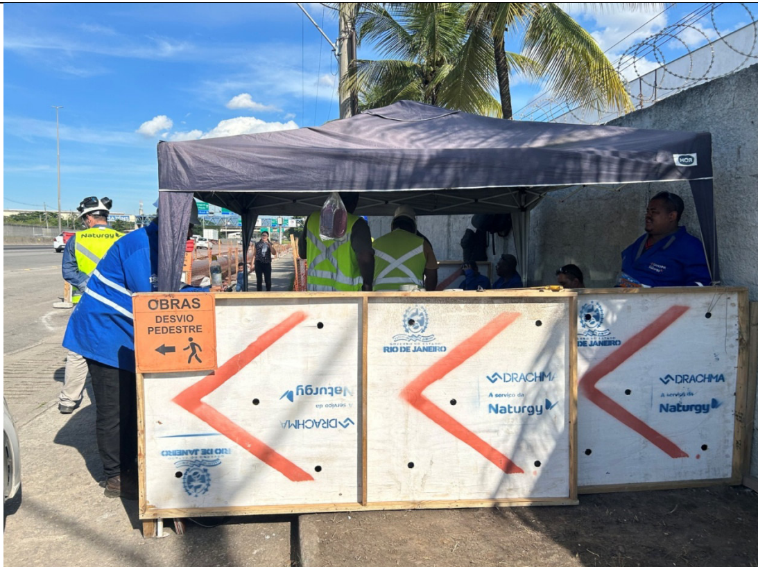
Foto 1: Área de vivência com isolamento e placa de desvio de pedestre.
