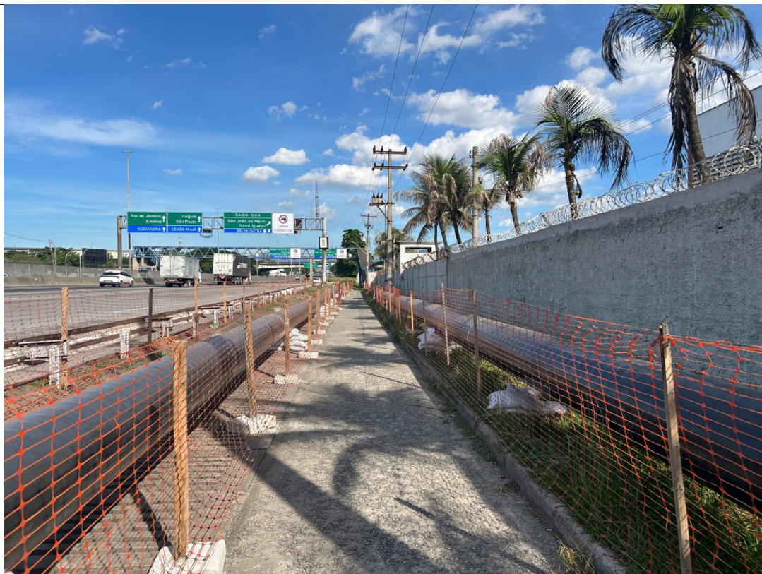
Foto 5: Tubulação construída para inserção no solo.
