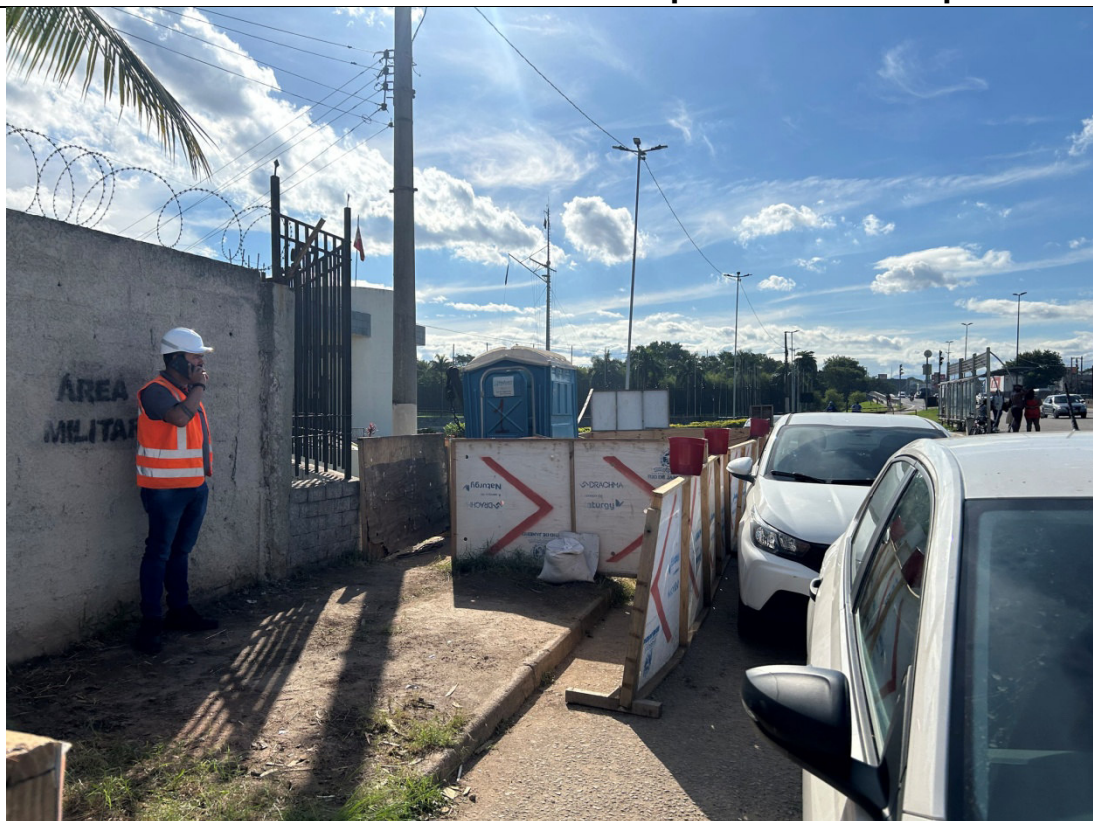
Foto 2: Local de inserção da tubulação no solo, com isolamento.
