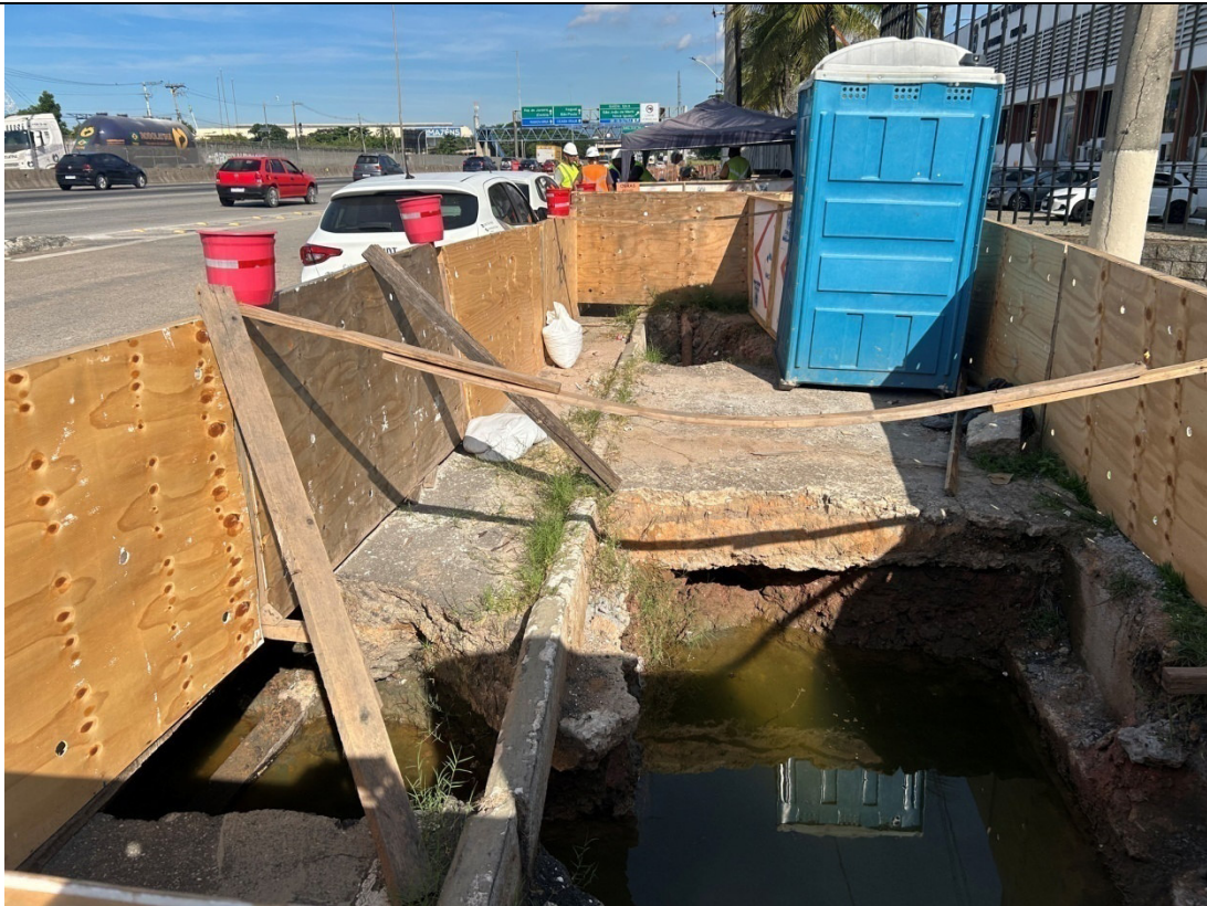
Foto 4: Ponto de escavação para inserção da tubulação.
