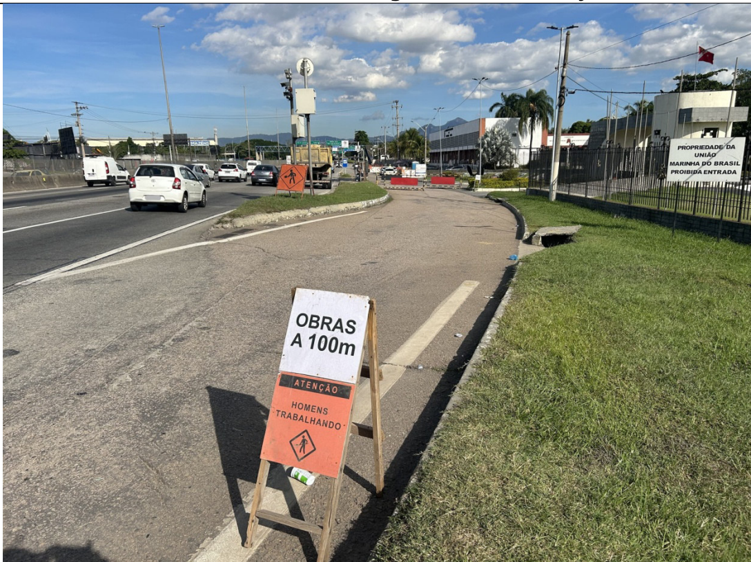
Foto 8: Placa de aviso de obra a 100 metros de distância.
