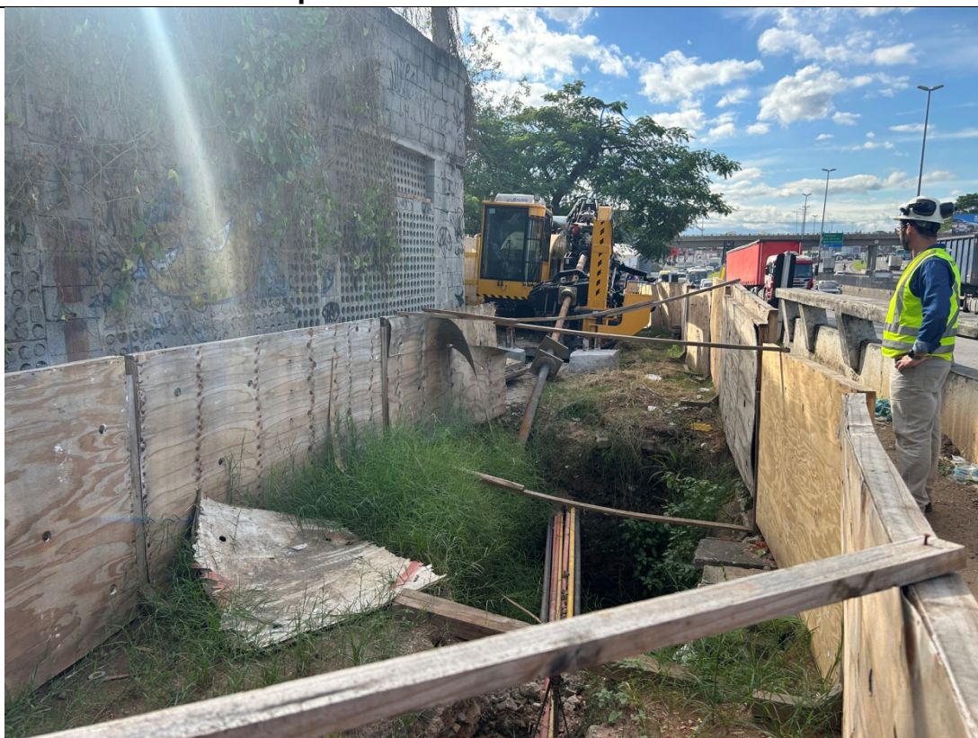
Foto 12: Abertura no solo por onde será iniciada a tração da tubulação.
