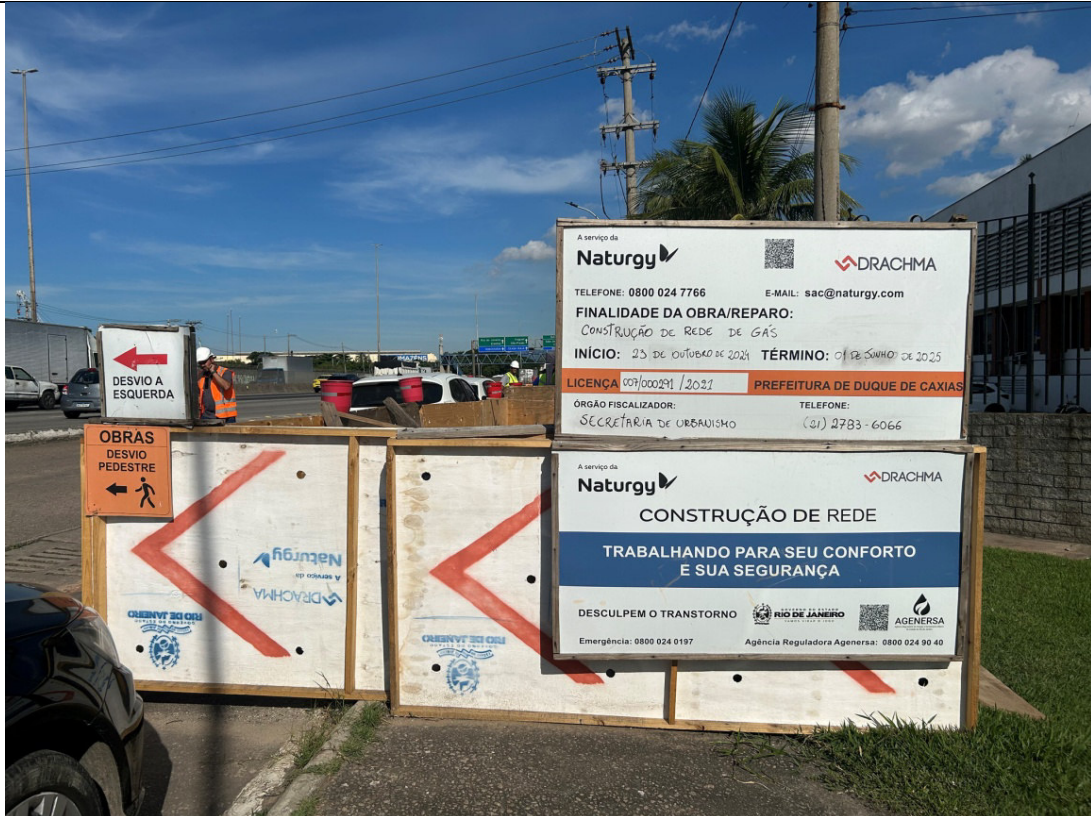
Foto 3: Identificação da obra e placas de desvio de trânsito e pedestre.
