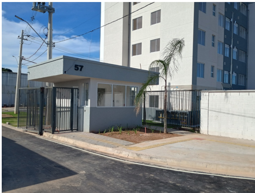
Foto 1: condomínio residencial a ser abastecido com gás natural.
