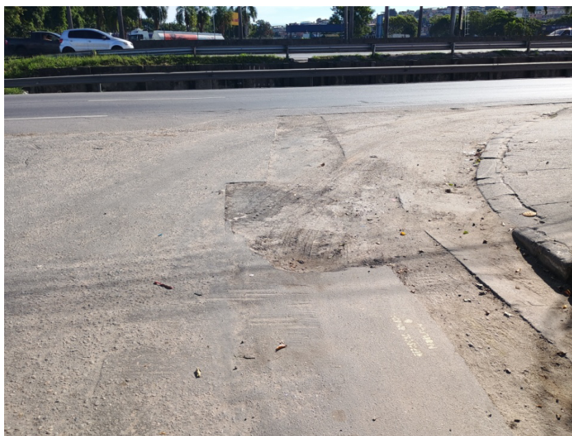
Foto 3: trecho de assentamento final da Rua Salutaris, próximo a Rodovia Washington Luiz.
