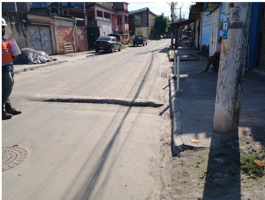
Foto 5: trecho de assentamento por método não destrutivo e identificado com marcos planos.
