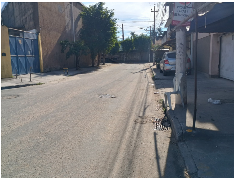
Foto 6: trecho de assentamento por método não destrutivo e identificado com marcos planos.
