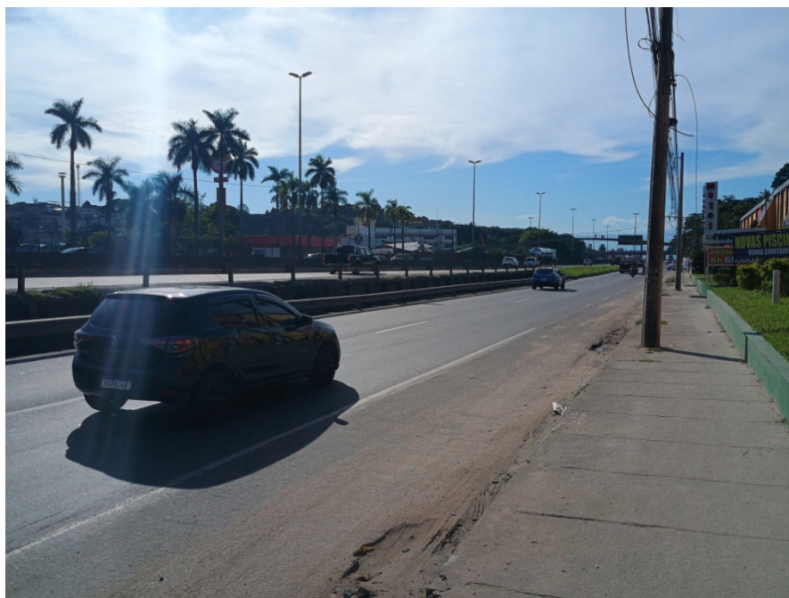
Foto 2: trecho da Rodovia Washington Luiz, próximo ao ponto de interligação.
