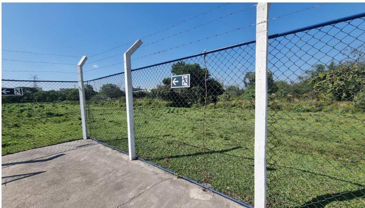
Foto 8: Cerca de delimitação da estação e sinalização de rota de fuga.
