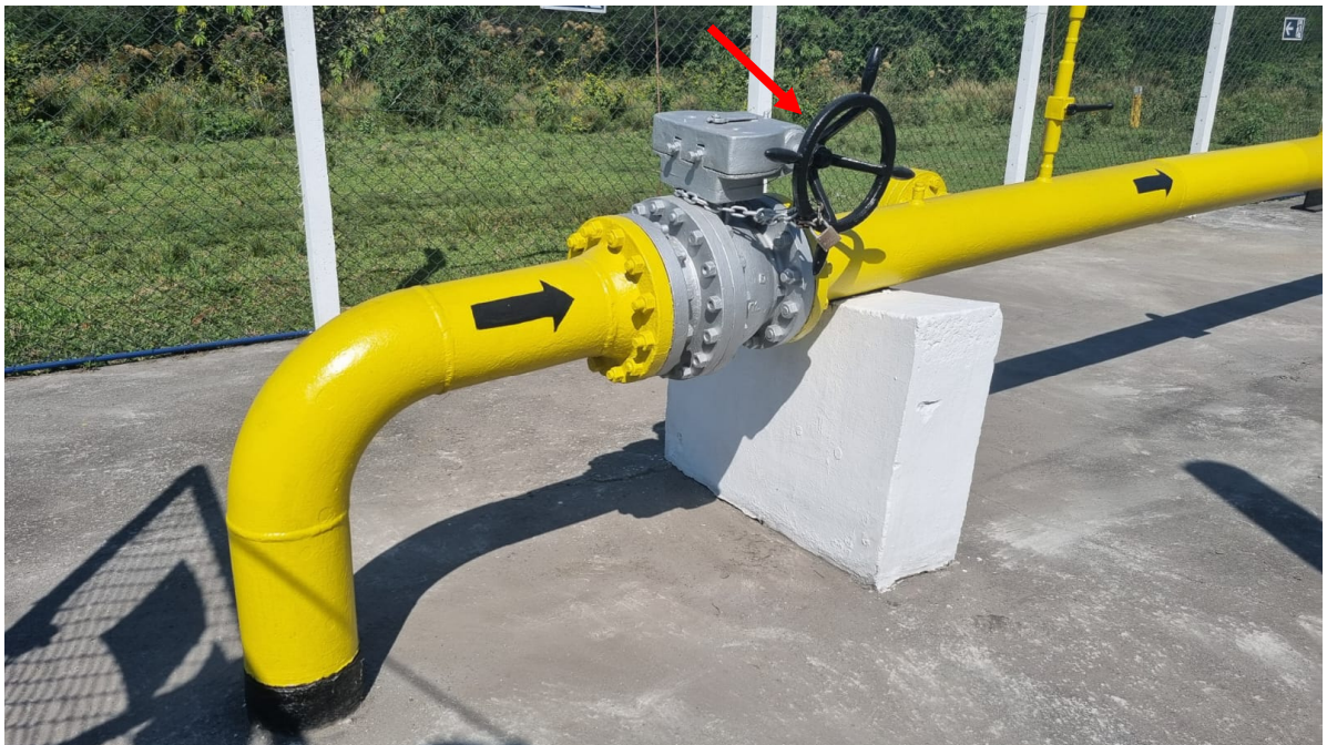
Foto 4: Válvula de linha da derivação para a GERDAU COSIGUA em destaque.
