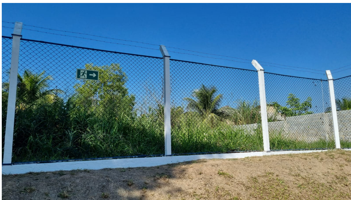
Foto 6: Sinalização de rota de fuga na cerca de delimitação da estação.
