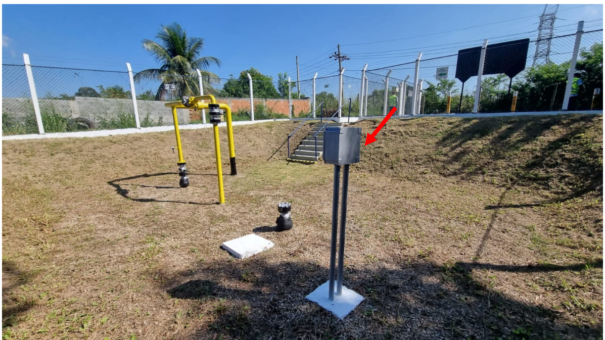
Foto 4: Estação vista por trás, com destaque para o sistema de proteção catódica.
