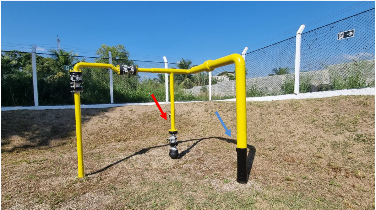
Foto 3: Linha de derivação para a FCC (seta vermelha) e linha de saída (seta azul).
