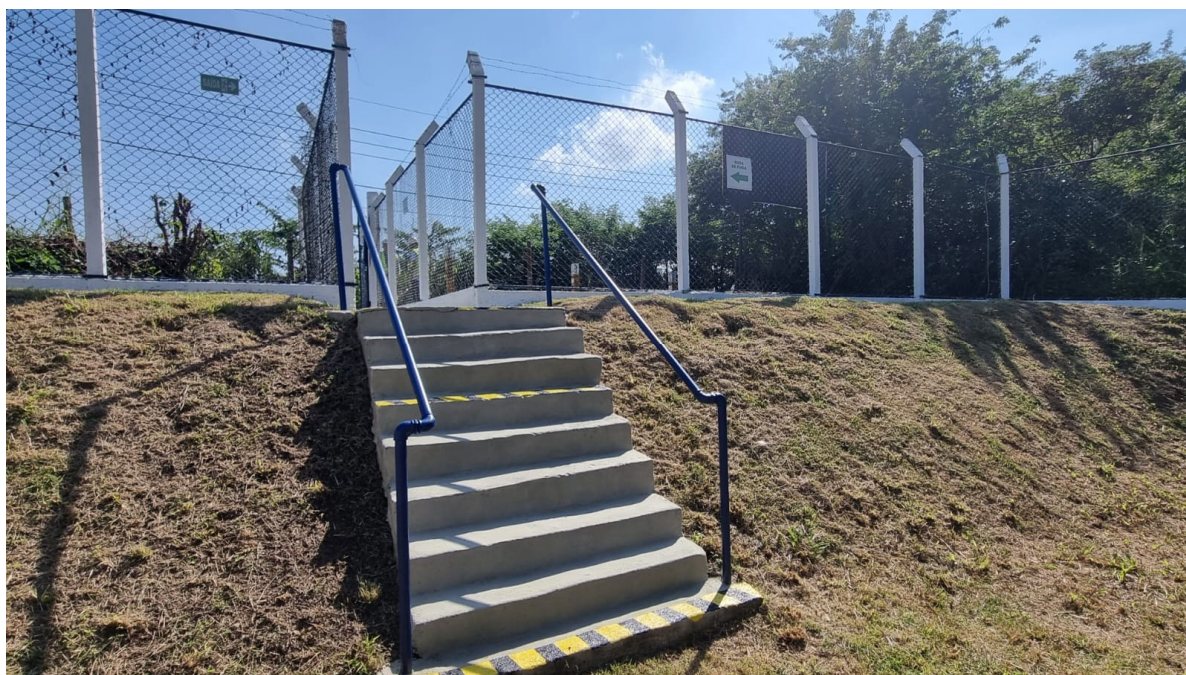
Foto 5: Escada de acesso ao duto dentro da estação – o duto se encontra em nível abaixo da entrada da estação.
