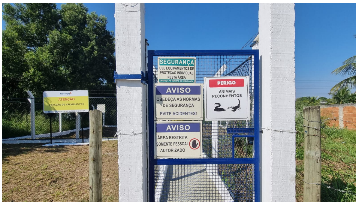
Foto 2: Placas de sinalização de segurança da estação e, ao fundo, a placa de identificação da mesma.
