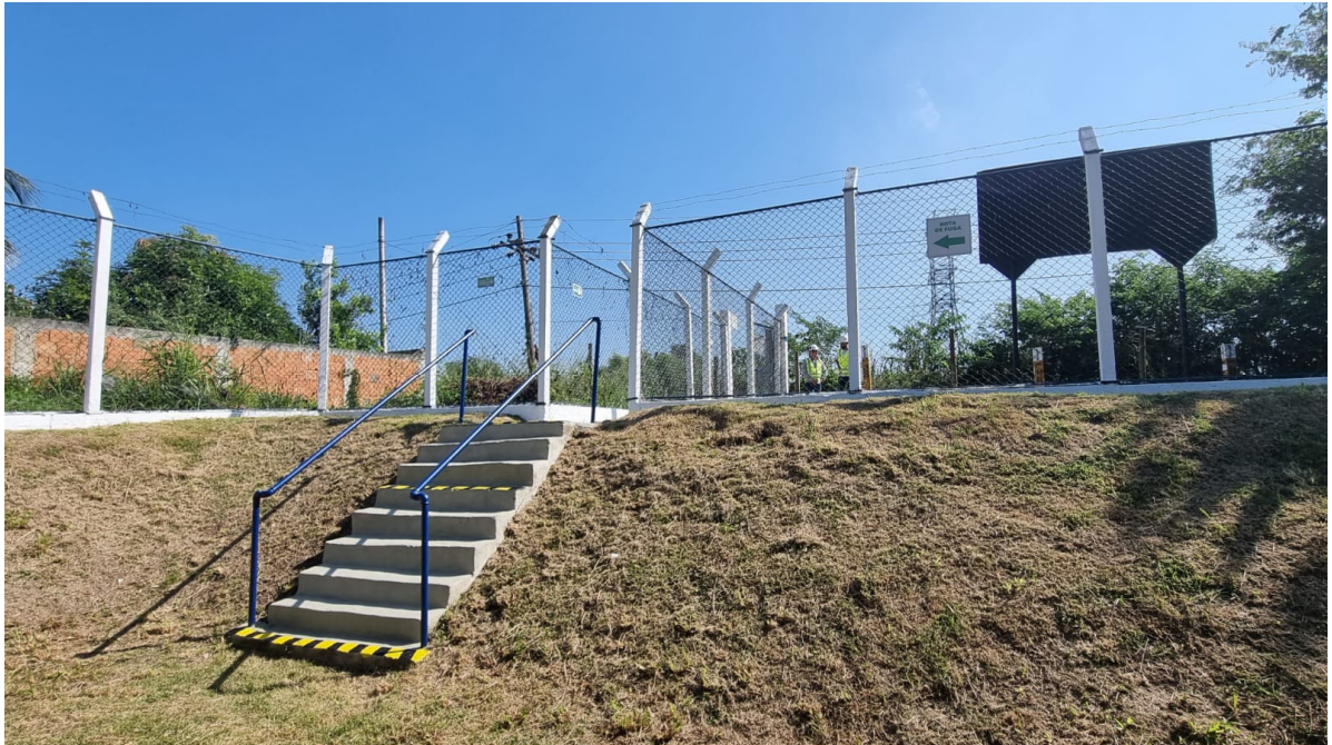
Foto 7: Cerca de delimitação, placas de rota de fuga e acesso ao portão da estação.
