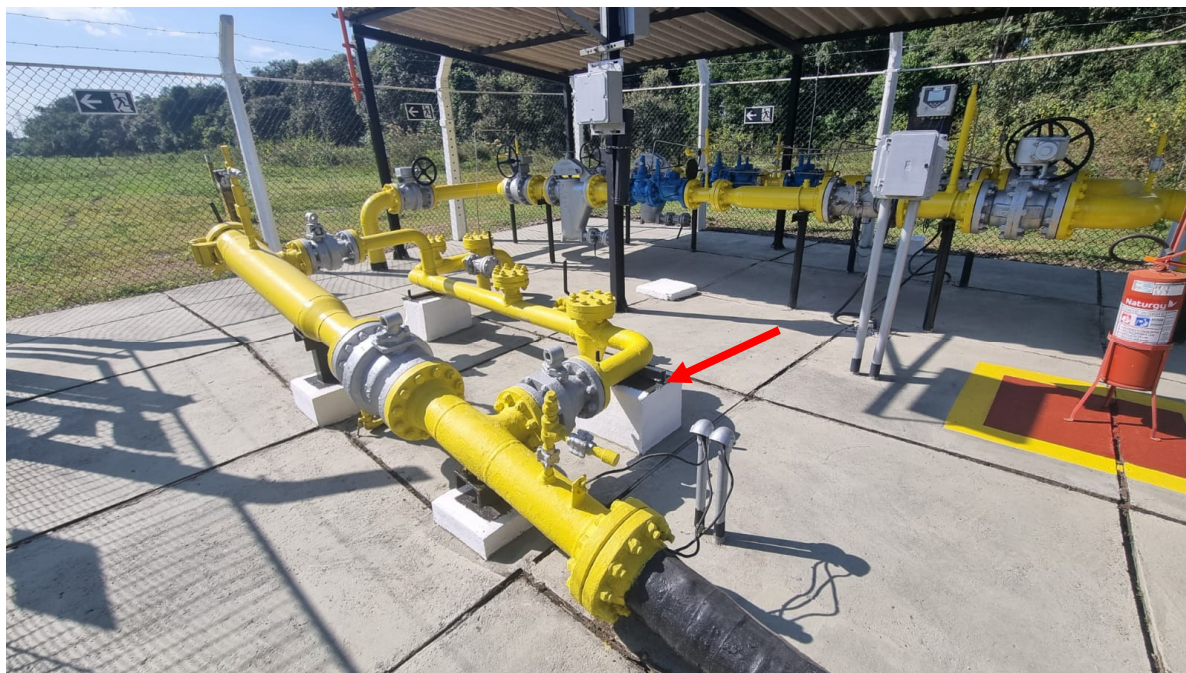
Foto 9: Canhão Lançador - duto especial para a passagem de pig na rede.
