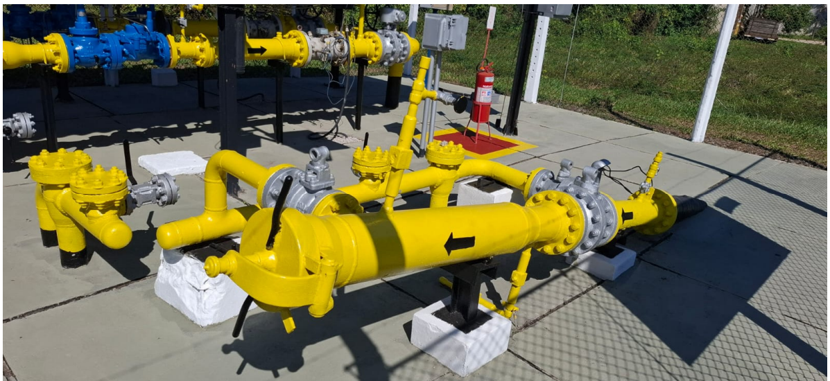
Foto 16: Setas de direção de fluxo de gás na tubulação pintadas após solicitação (comprovação fotográfica).
