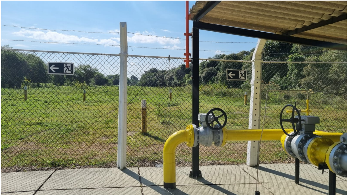
Foto 11: Sinalização de rota de fuga.
