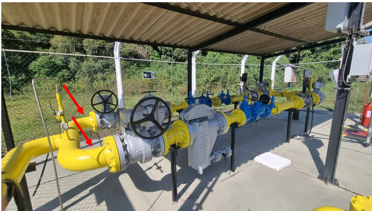
Foto 5: Estação de Regulação e Medição, com destaque para as duas linhas do sistema.
