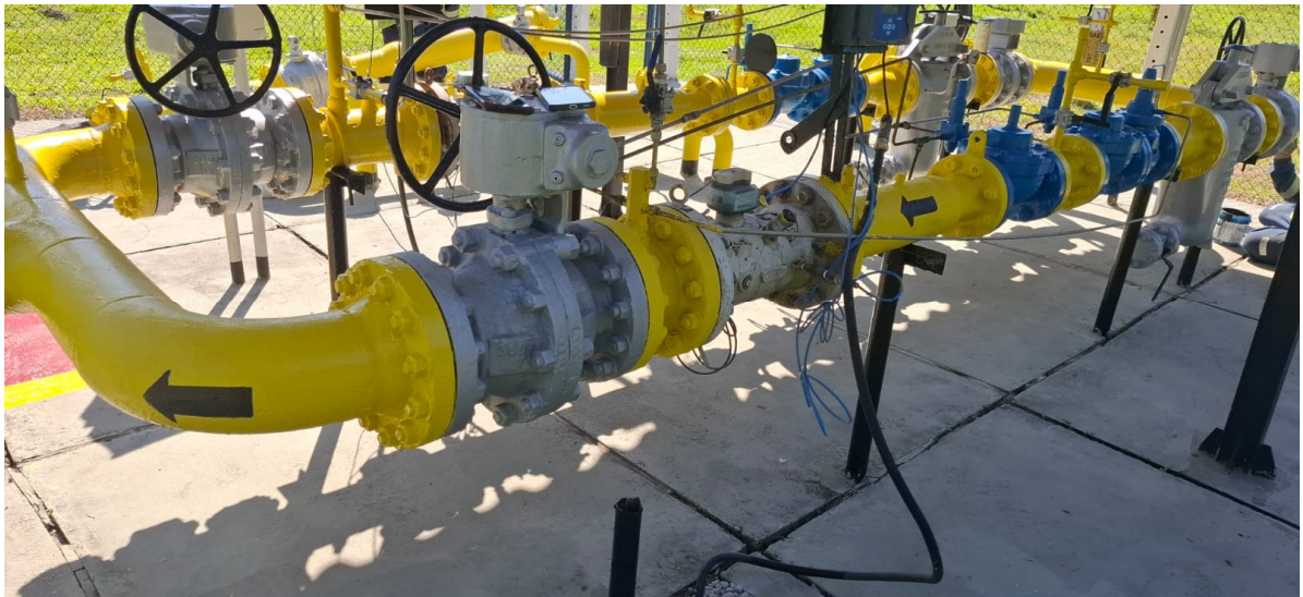
Foto 14: Setas de direção de fluxo de gás na tubulação pintadas após solicitação (comprovação fotográfica).
