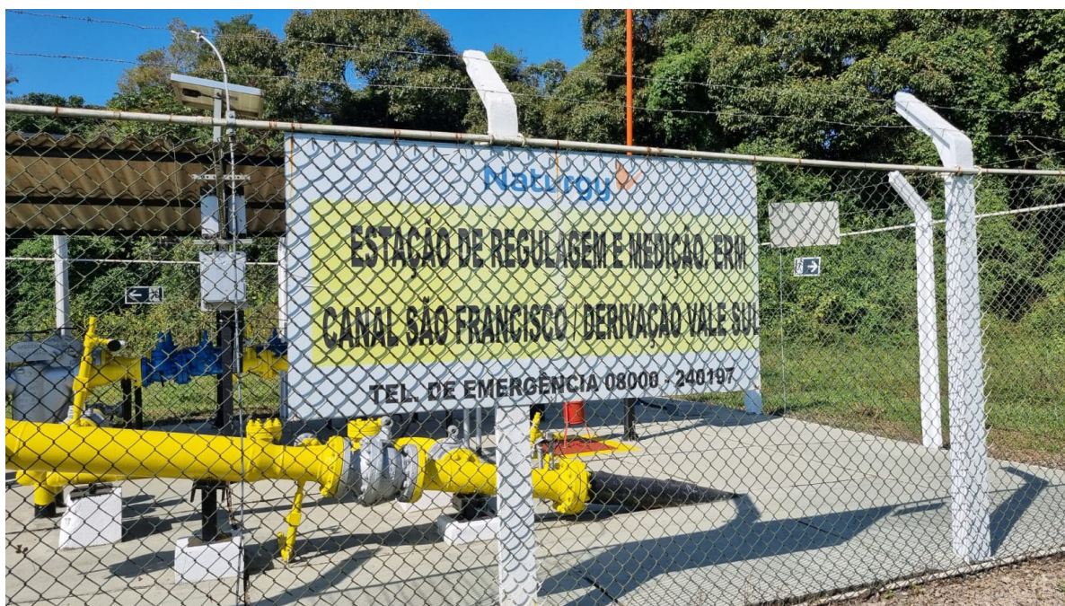
Foto 2: Placa de identificação da estação.
