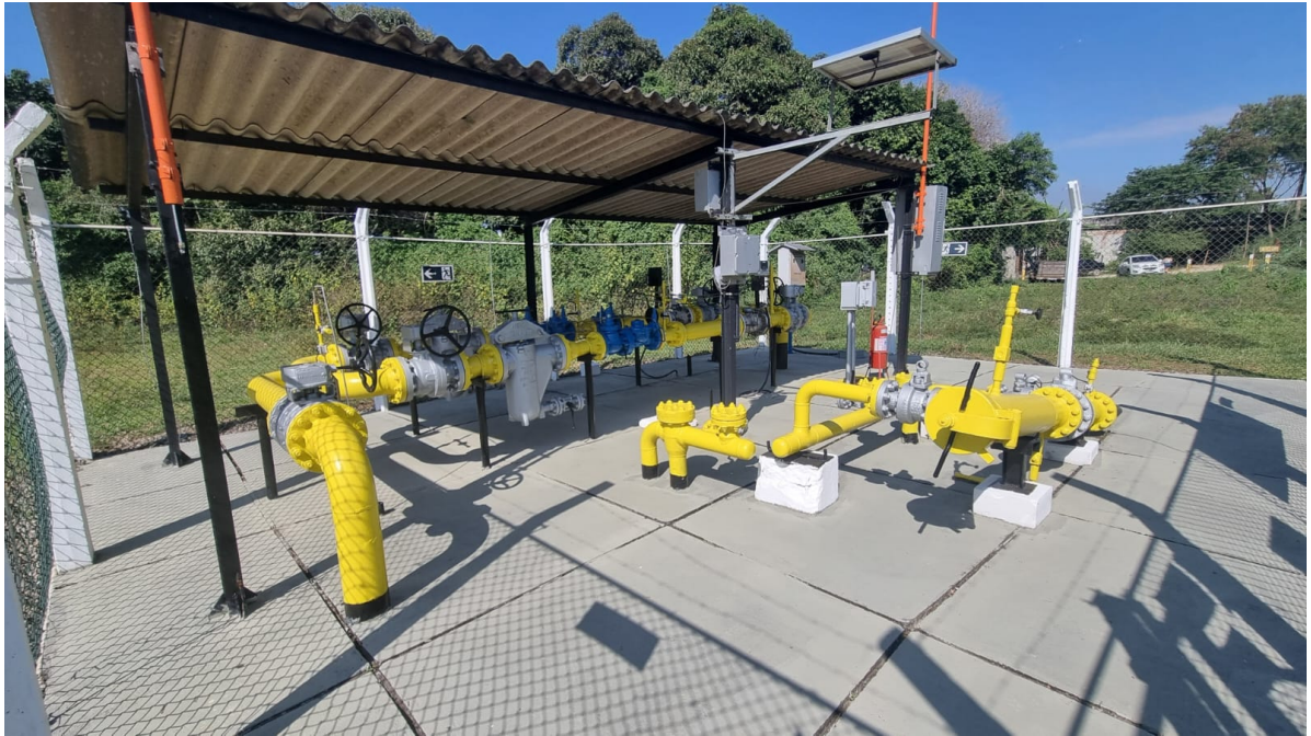
Foto 3: Vista frontal da estação.
