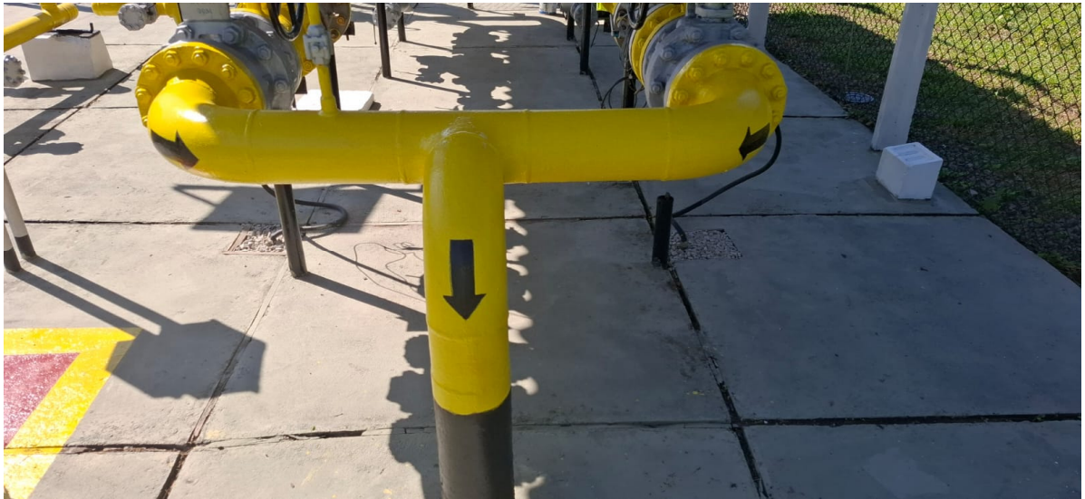
Foto 15: Setas de direção de fluxo de gás na tubulação pintadas após solicitação (comprovação fotográfica).
