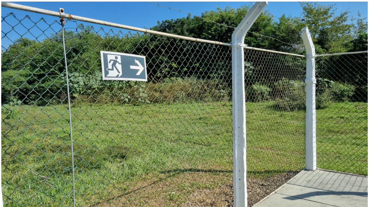
Foto 12: Sinalização de rota de fuga.
