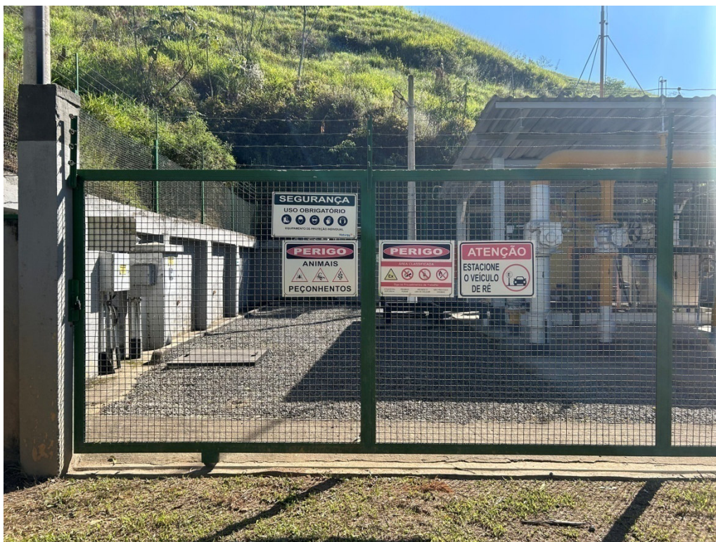
Foto 3: Entrada da estação com placas de sinalização de segurança.
