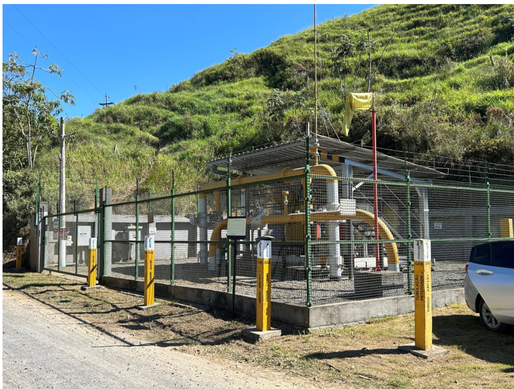
Foto 1: Visão externa da estação.
