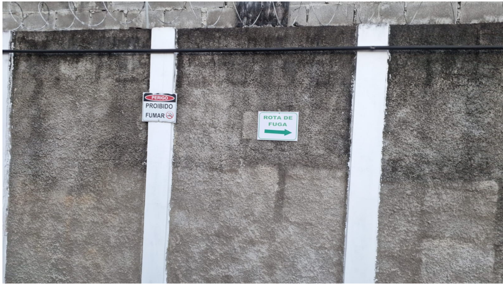
Foto 11: Placa de rota de fuga recolocada.
