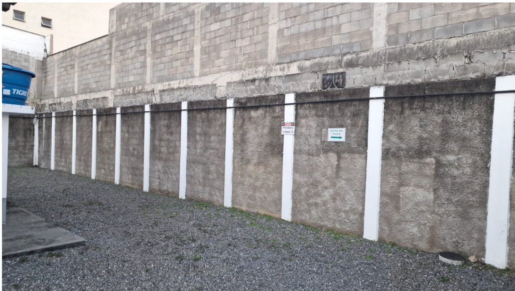
Foto 12: Placa de rota de fuga recolocada.
