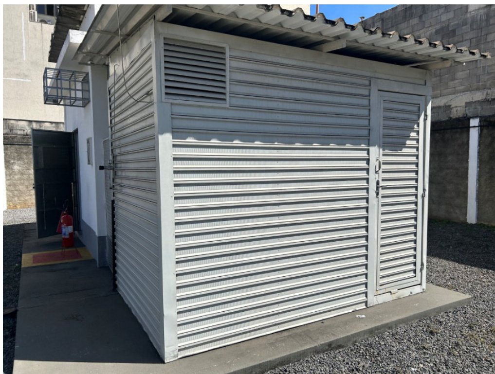
Foto 8: Sala de cromatografia (à frente) e sala de comando (atrás).
