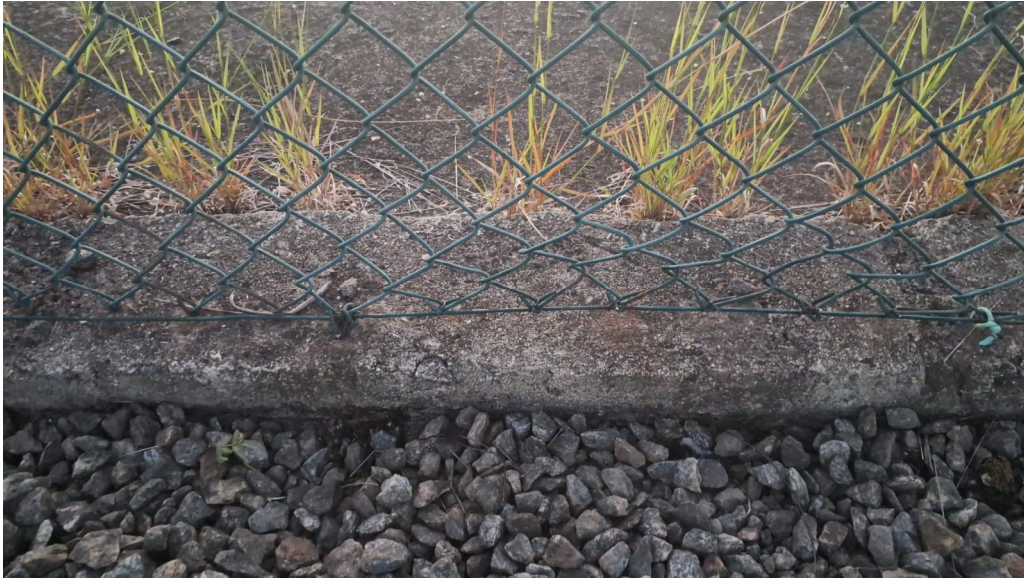
Foto 13: Ponto de abertura na cerca reparado.
