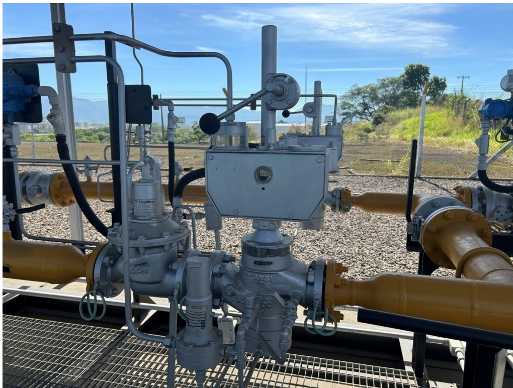
Foto 5: Regulador monitor com bloqueio incorporado da ERM Itatiaia.
