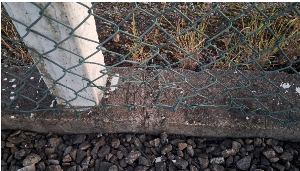
Foto 11: Ponto de abertura na cerca reparado.
