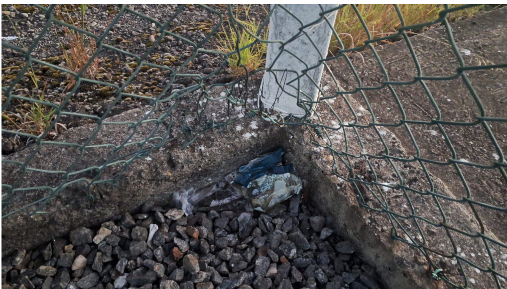
Foto 12: Ponto de abertura na cerca reparado.
