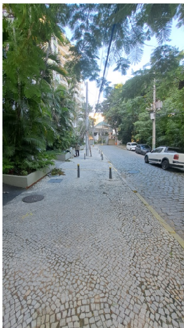
Foto 11: Trecho com 5 renovações de ramais finalizado com recomposição finalizada
