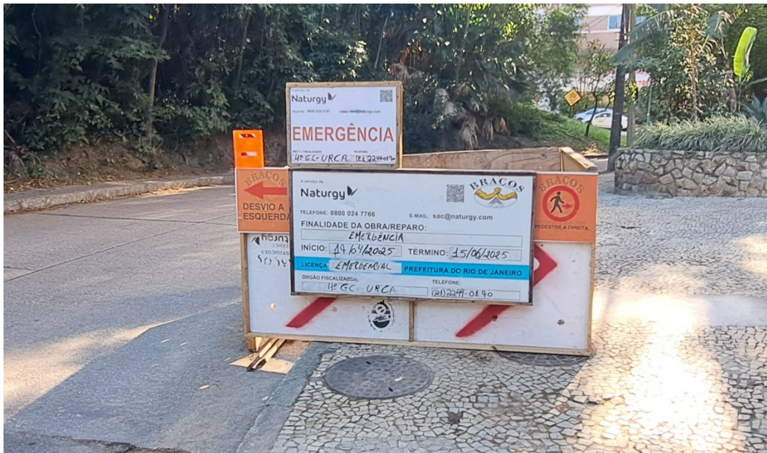
Foto 1: Placa de obra, com sinalização de desvio e noturna
