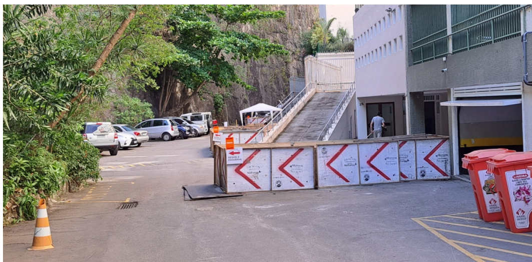
Foto 12: Últimas renovações de ramais em execução
