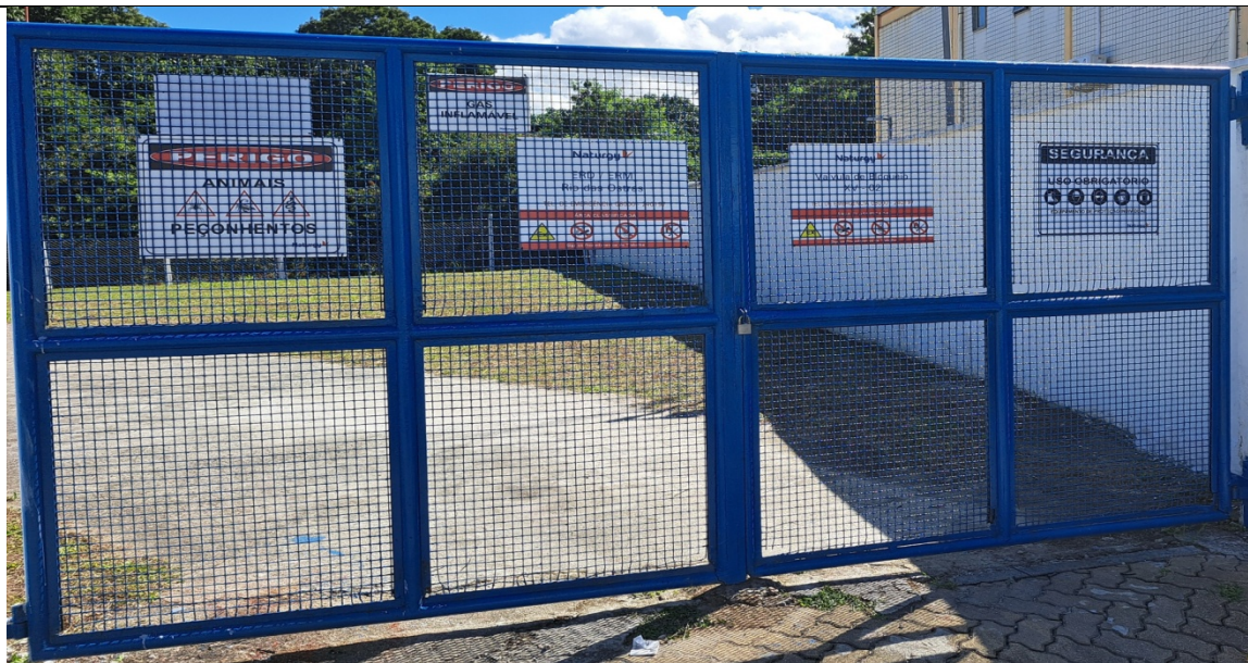
Foto 1: Sinalização de Segurança –entrada da estação
