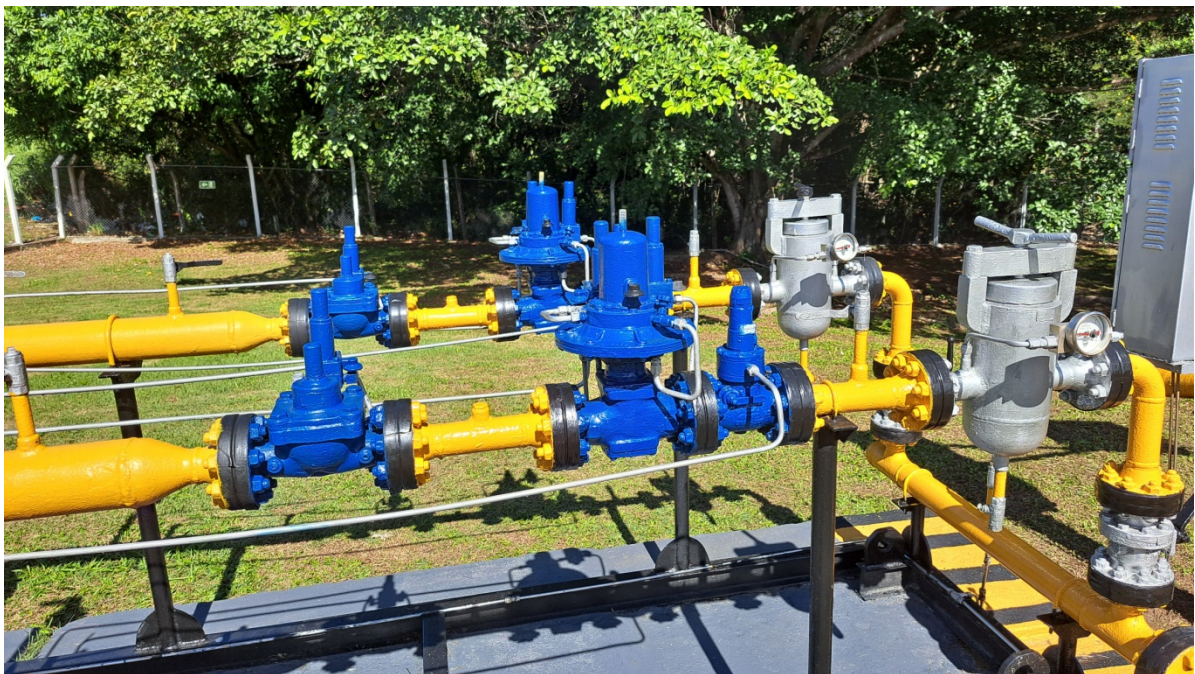
Foto 6: Tubulações paralelas para Rio das Ostras - backup
