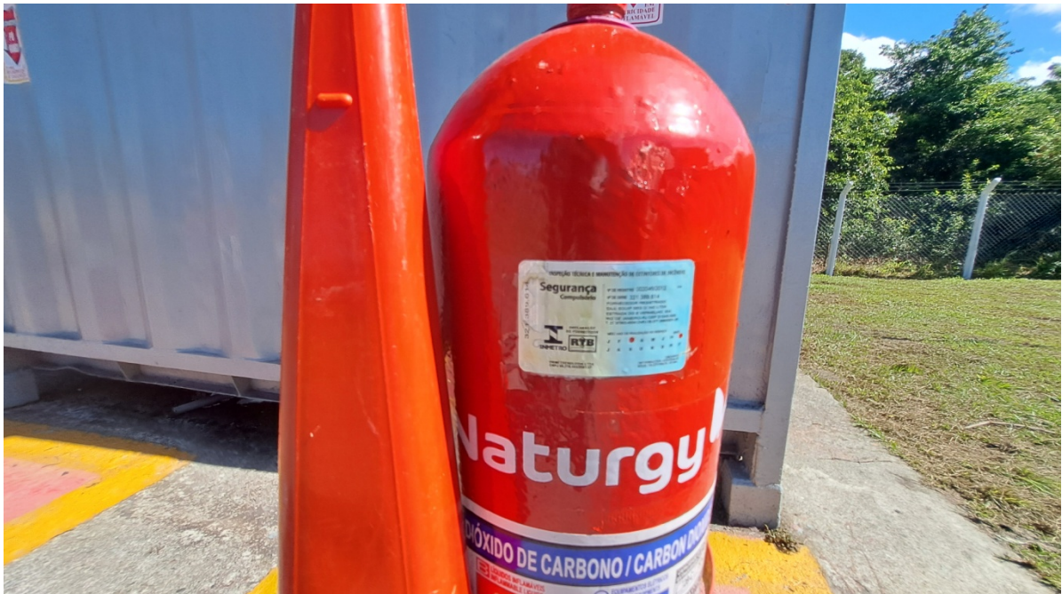
Foto 12: Validade dos extintores verificadas.
