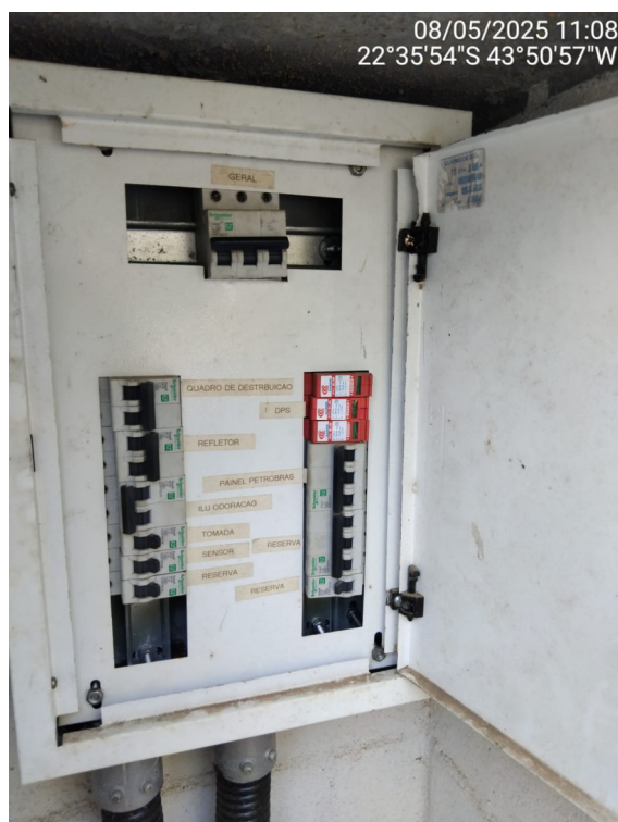
Foto 8: Porta do quadro elétrico após reparo .
