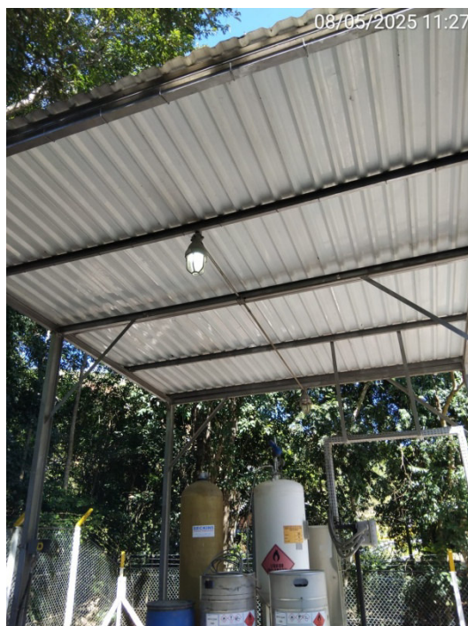
Foto 7: Lâmpada em funcionamento após troca.
