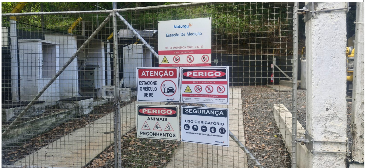
Foto 4: Portão de Entrada da Estação.
