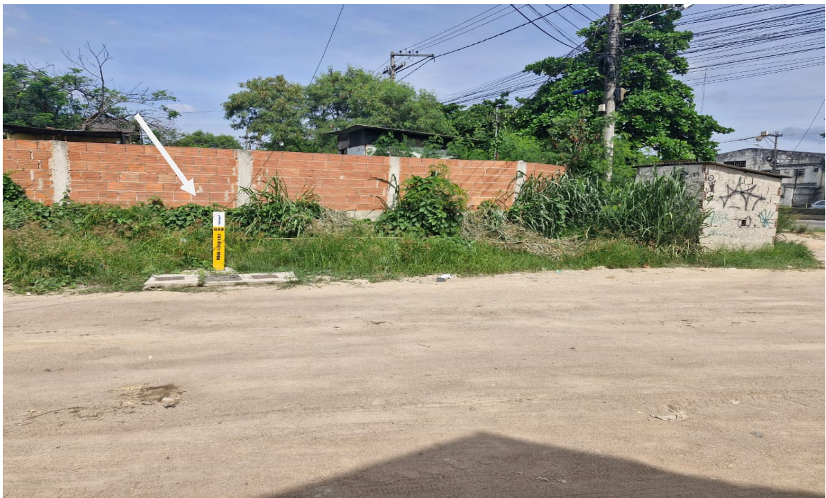
Foto 2: Vista do local da obra – Pista sentido Itaboraí.
