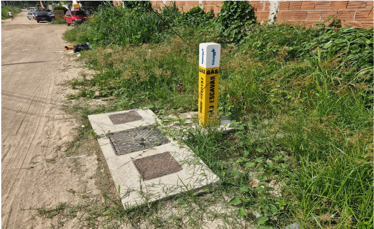
Foto 1: Marco que localiza a extremidade do tubo camisa – Pista sentido Itaboraí.
