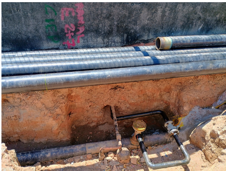
Foto 5: ponto de interligação de rede.
