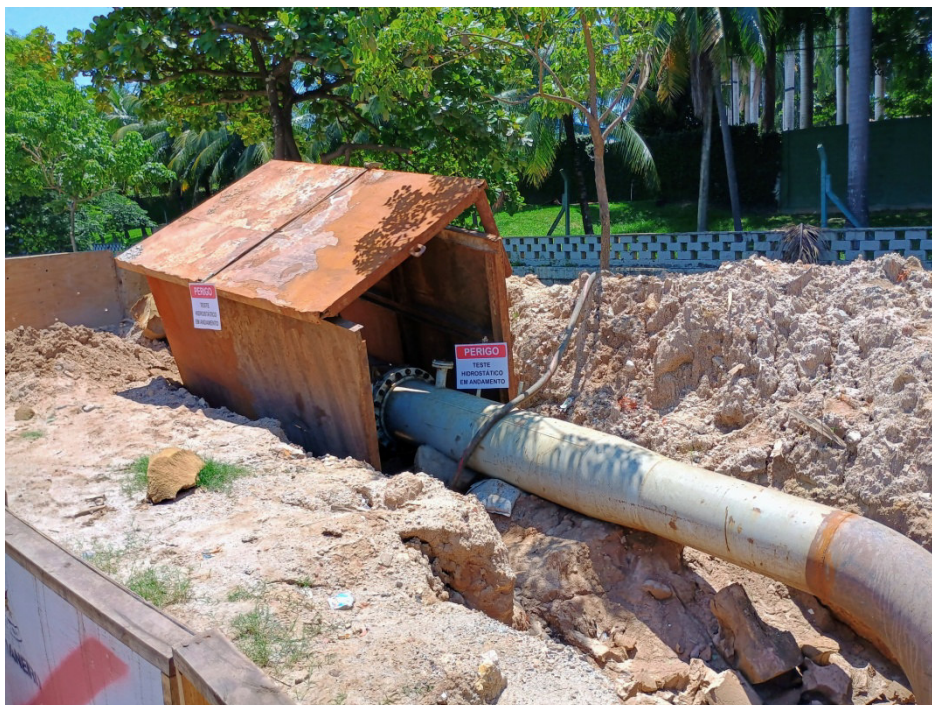
Foto 3: tubulação em teste.
