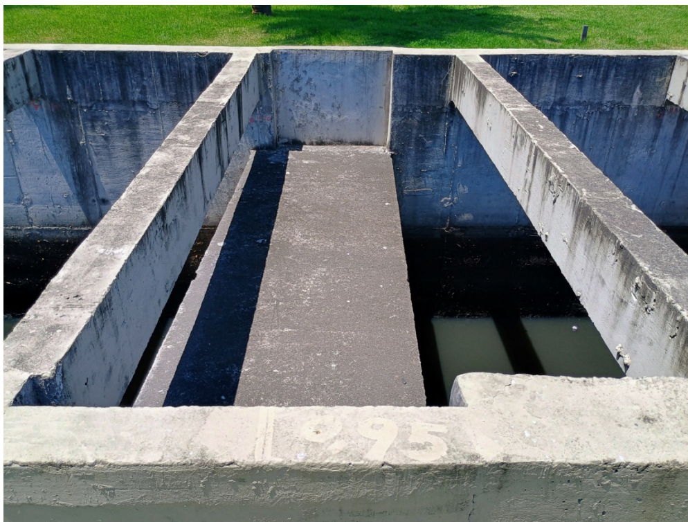
Foto 11: tubulação antiga cruzando o canal e revestida com concreto.
