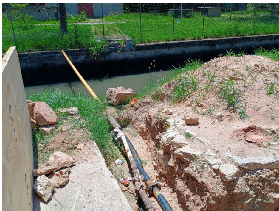
Foto 6: ponto de interligação de rede.
