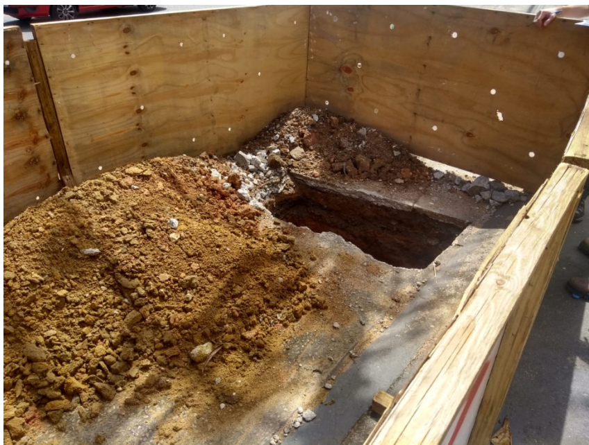
Foto 3: trecho em sondagem próximo a rua Observador.
