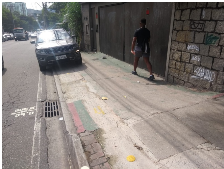
Foto 1: trecho inicial na Estrada Rodrigues Caldas.
