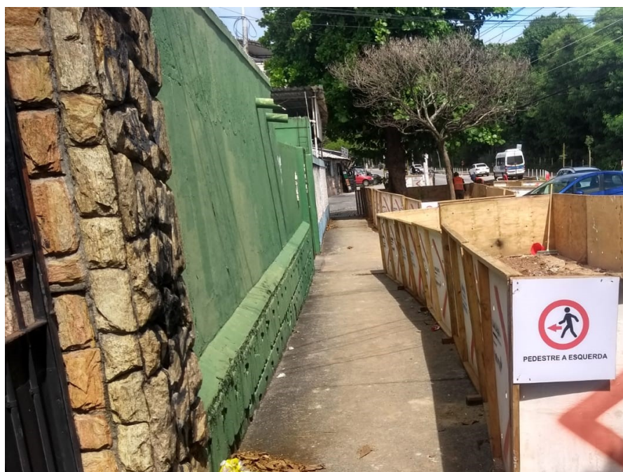
Foto 2: trecho na altura da rua Observador.
