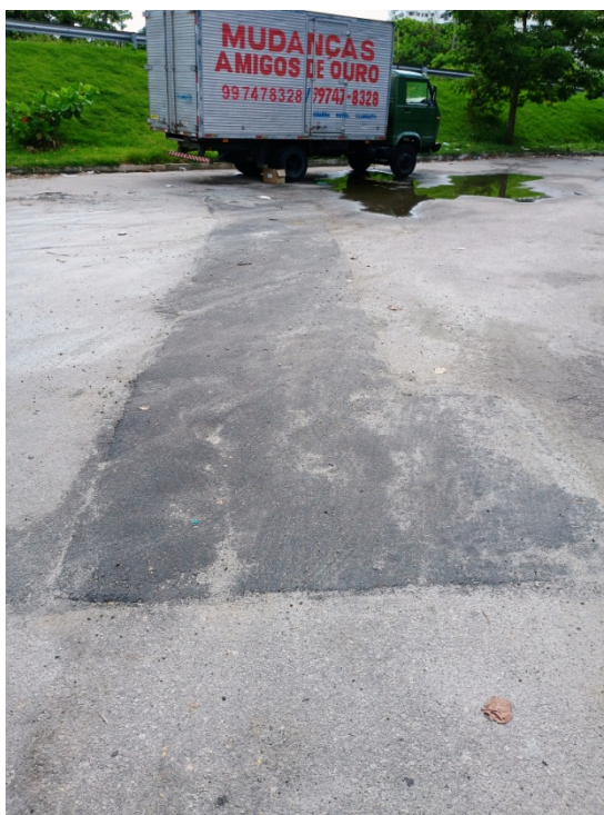
Foto 5: recomposição provisória sem identificação.
