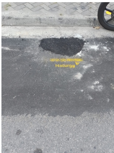
Foto 9: recomposição após correção e identificação enviada pelo gestor da obra.
