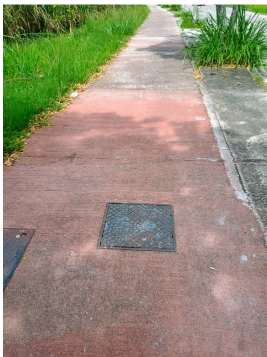
Foto 1: extremidade da rede na Avenida das Américas.
