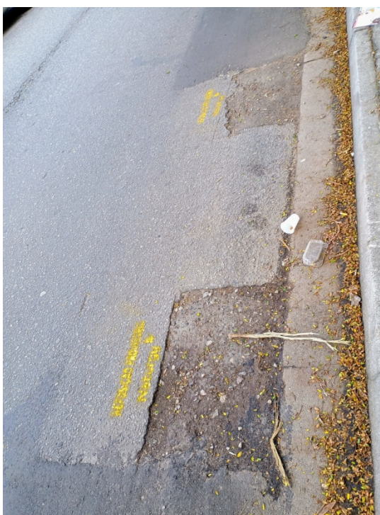
Foto 4: recomposição provisória identificada.
