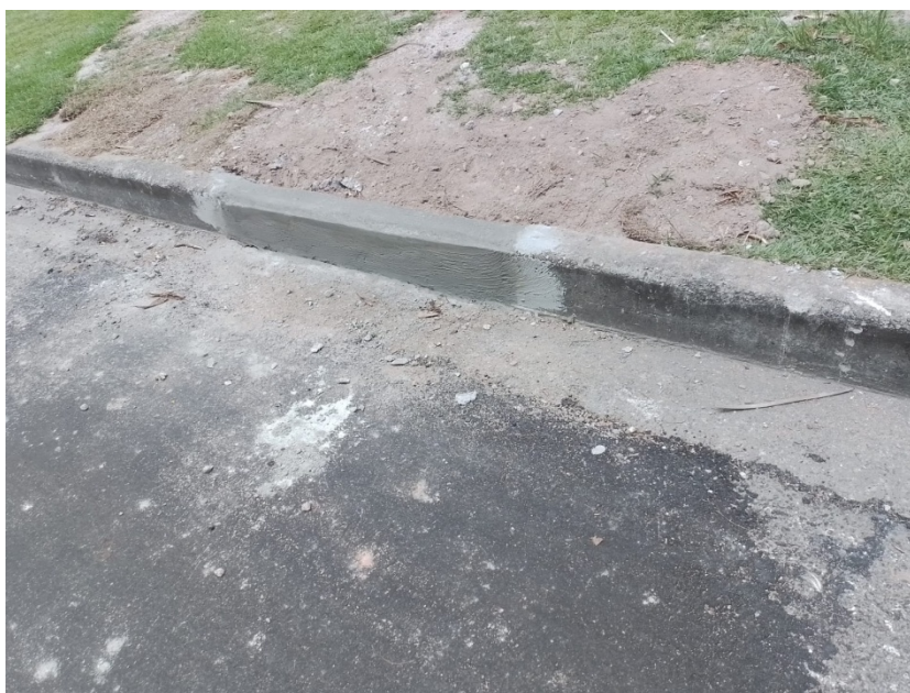
Foto 10: recomposição no meio-fio após correção enviada pelo gestor da obra.
