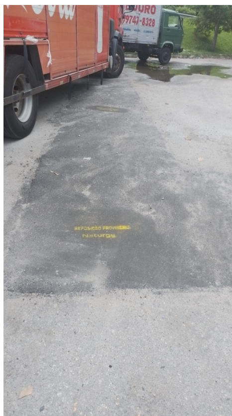
Foto 8: recomposição provisória após identificação enviada pelo gestor da obra.
