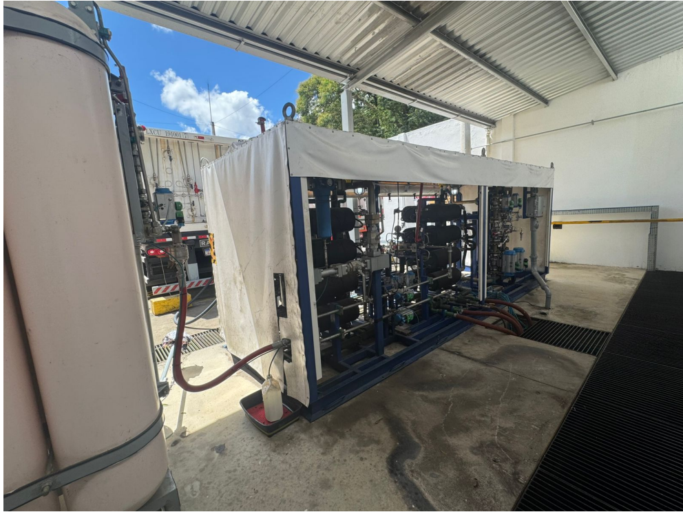
Foto 4: sistema de aquecimento em dois estágios.
