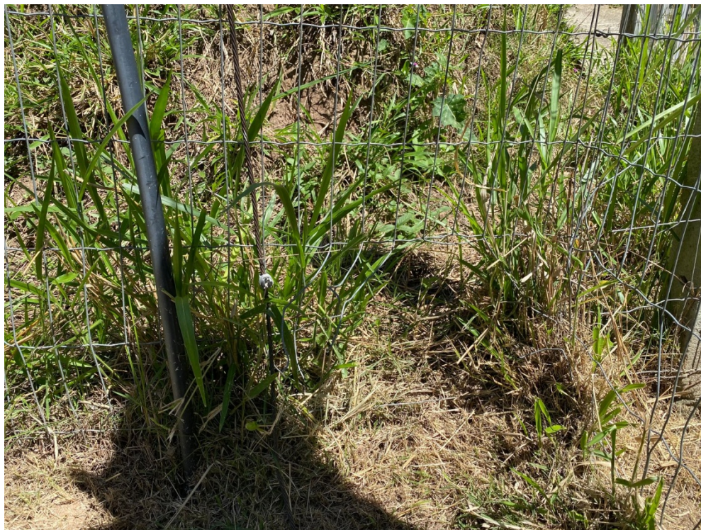
Foto 11: trecho da cerca com abertura.
