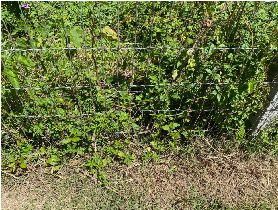
Foto 12: Comprovação fotográfica enviada de reparo da cerca.
