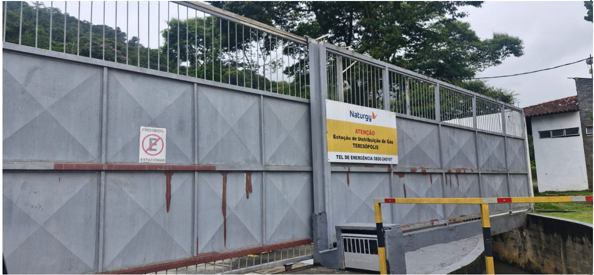
Foto 1: Entrada da estação de descompressão de Teresópolis.
