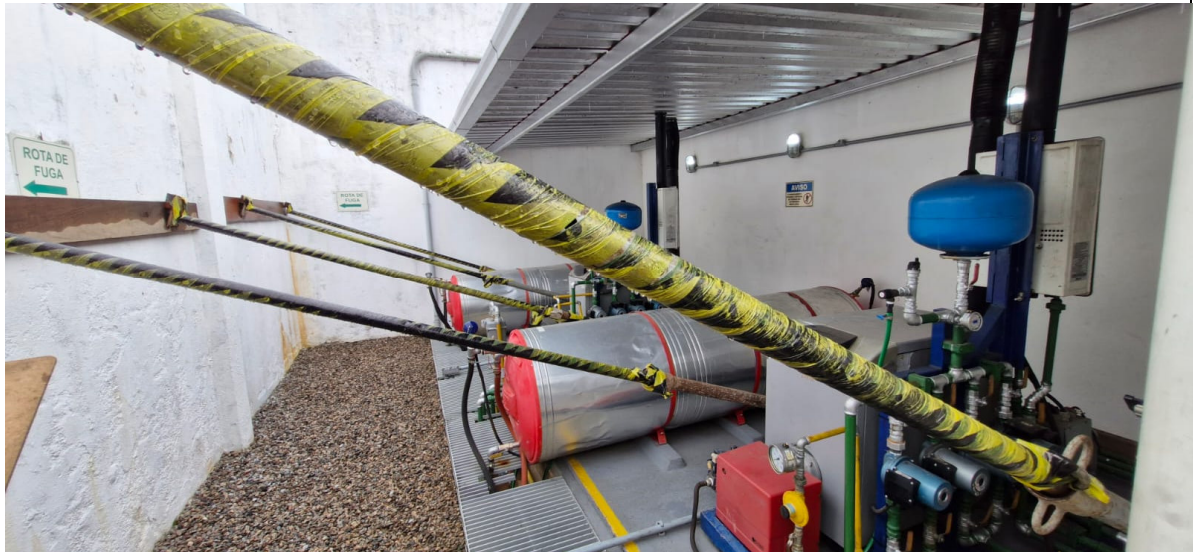
Foto 5: Muro dos fundos da estação.
