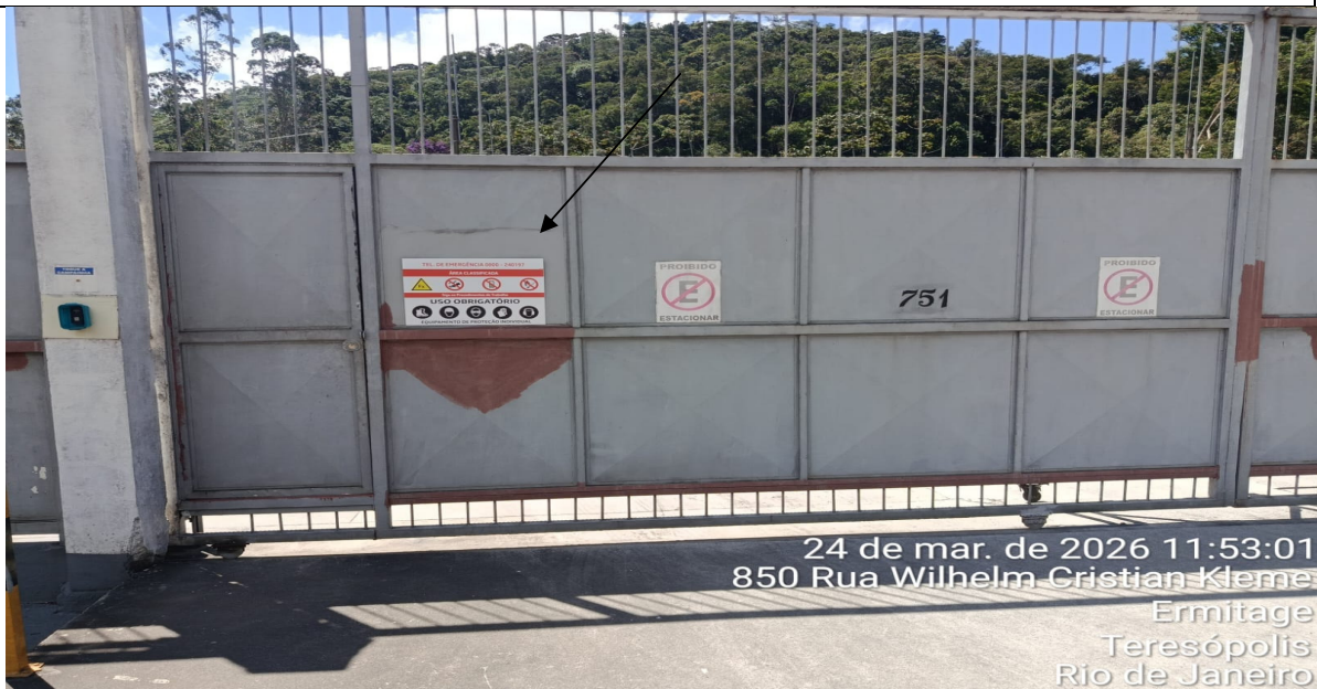
Foto 6: Placa de sinalização de segurança no portão de acesso da estação.
