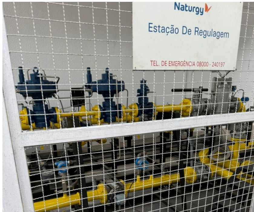
Foto 3: Estação de regulagem da concessionária.
