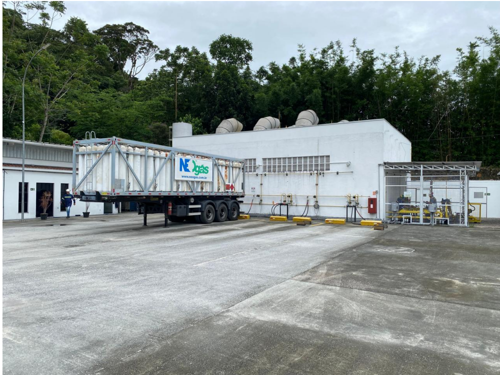
Foto 2: Carreta com cilindros de GNC.
