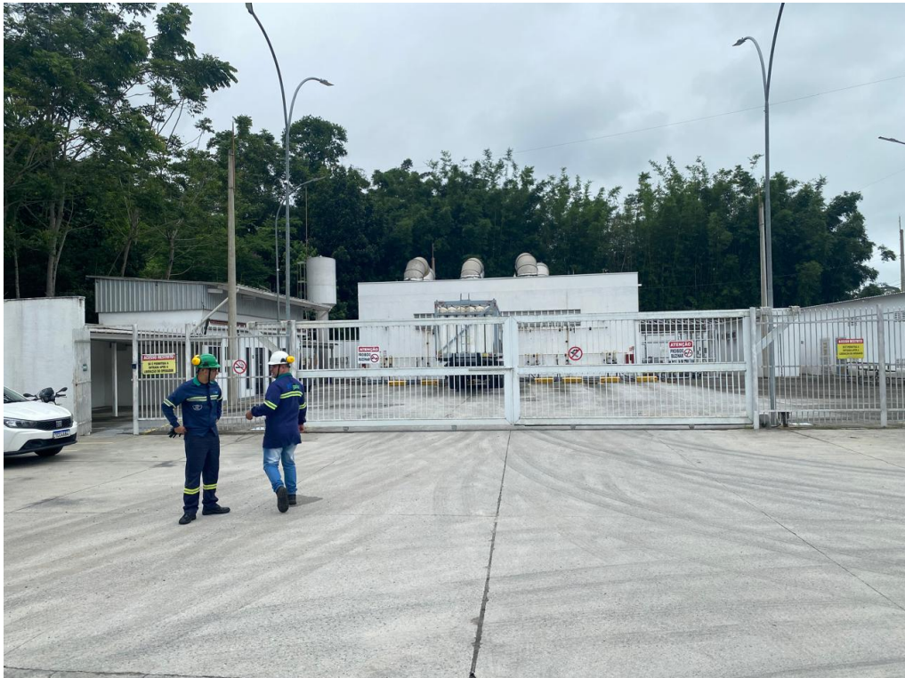
Foto 1: Entrada da estação de compressão de Guapimirim.
