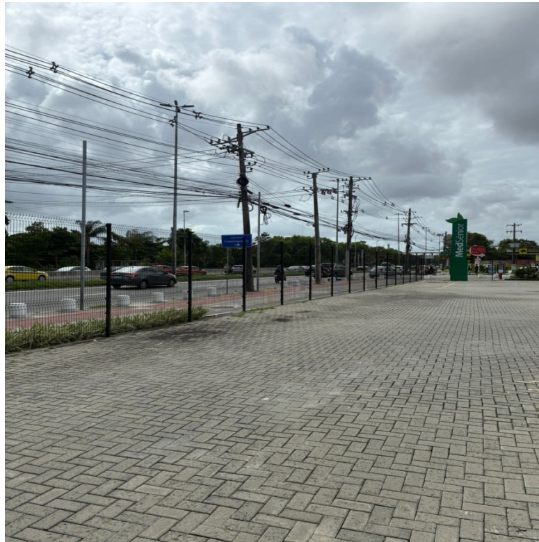
Foto 6: Local da rede externa existente, após o gradil.
