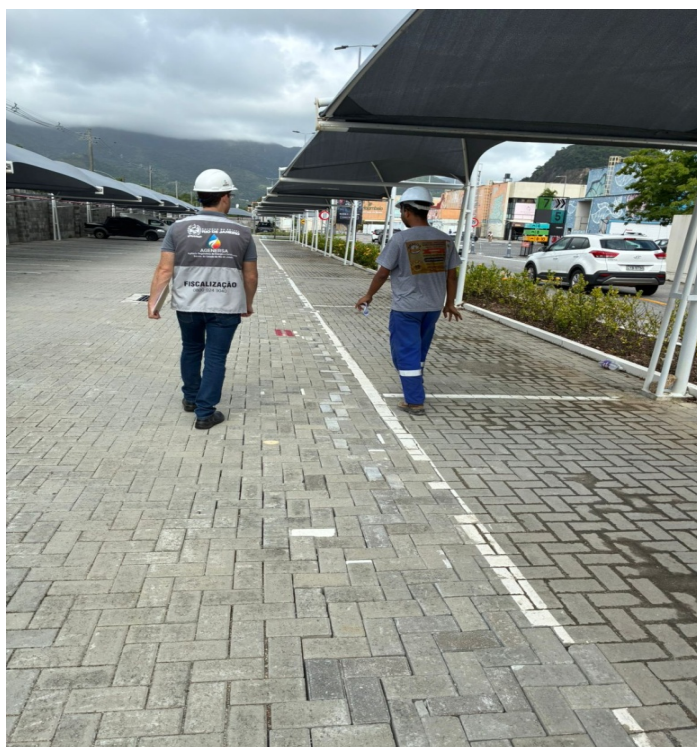
Foto 4: Trecho de assentamento de tubulação.
