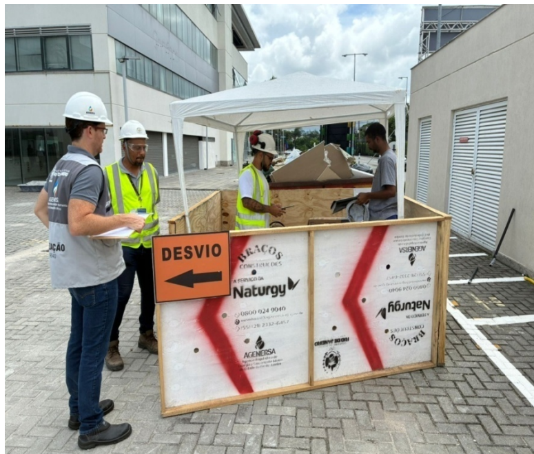
Foto 2: Área de vivência provisória da obra.
