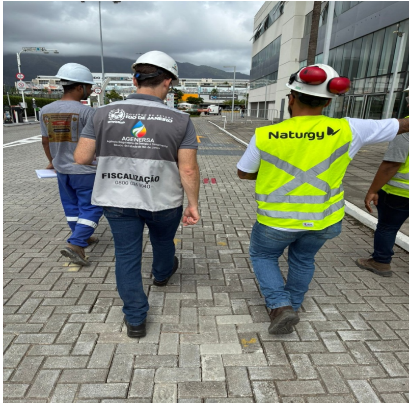
Foto 5: Trecho de assentamento de tubulação.
