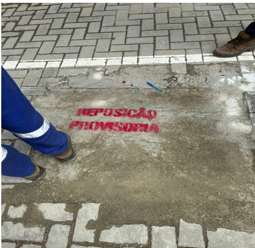
Foto 7: Recomposição provisória da obra.
