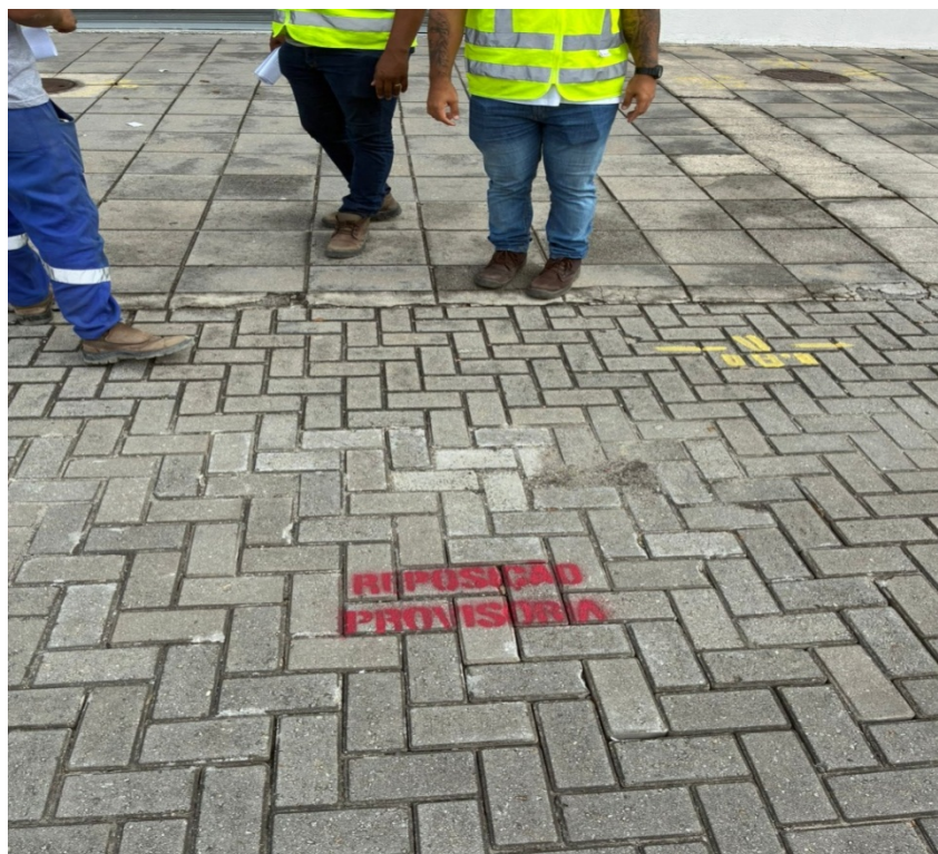
Foto 8: Recomposição provisória da obra.
