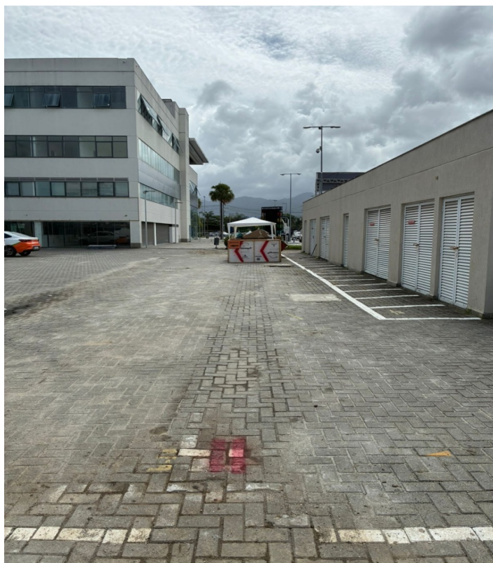
Foto 3: Trecho de assentamento de tubulação.
