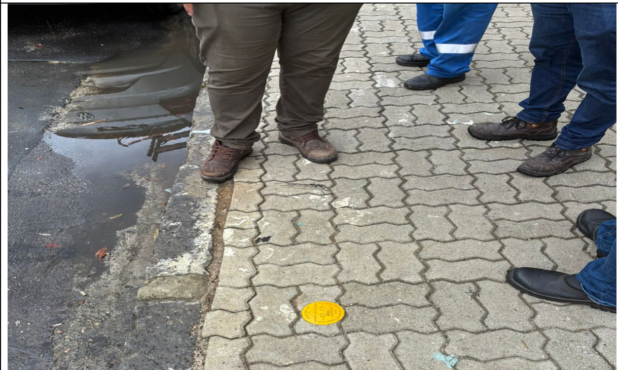
Foto 4: Marco Plano instalado.
