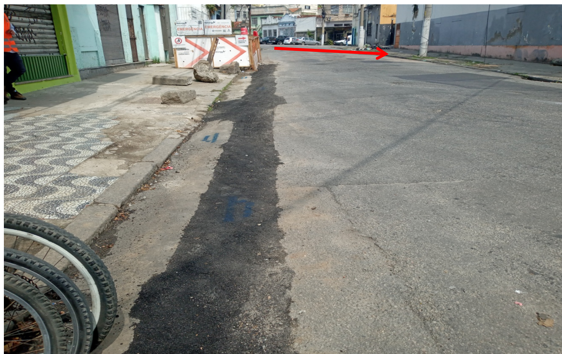
Foto 8: Recomposição provisória (local onde haverá uma travessia para interligação)
