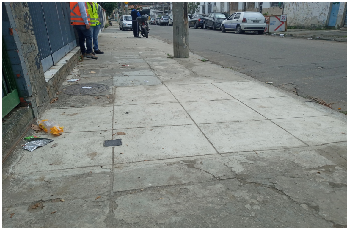
Foto 5: Recomposição em ponto de construção de ramal
