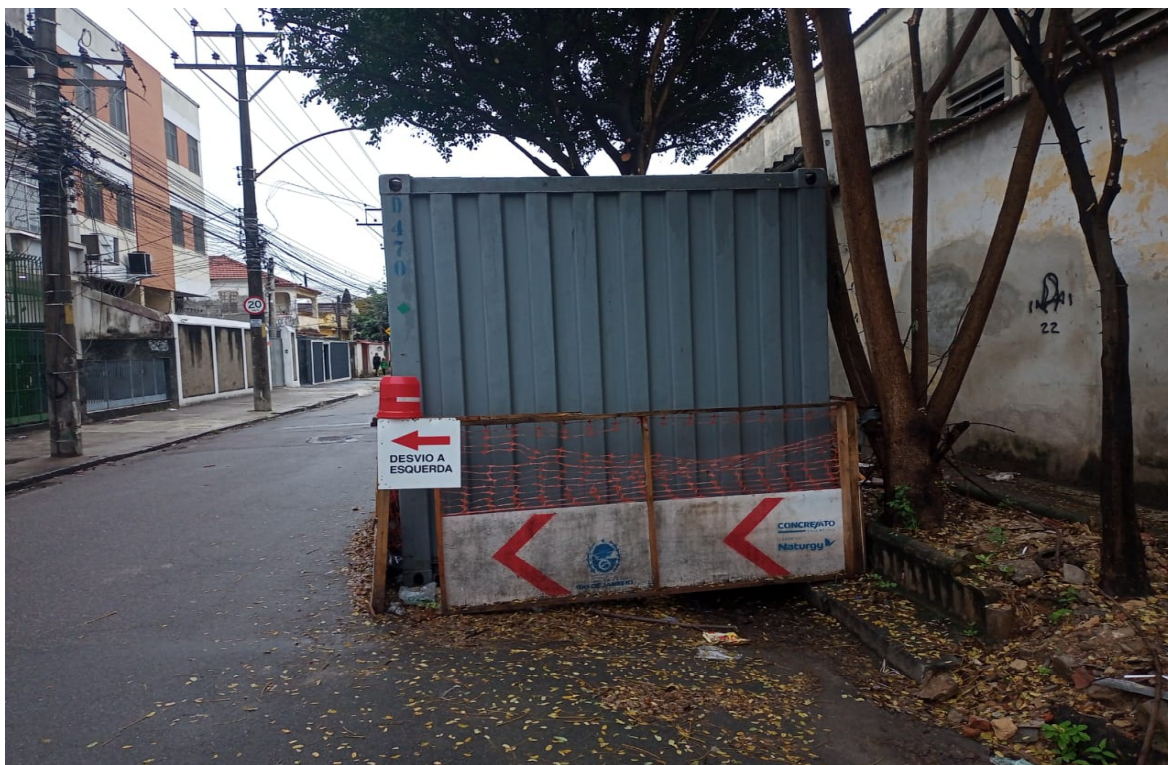
Foto 13: Foi instalada a placa de desvio de trânsito
