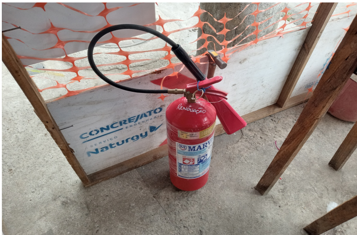
Foto 11: Extintor de CO2
