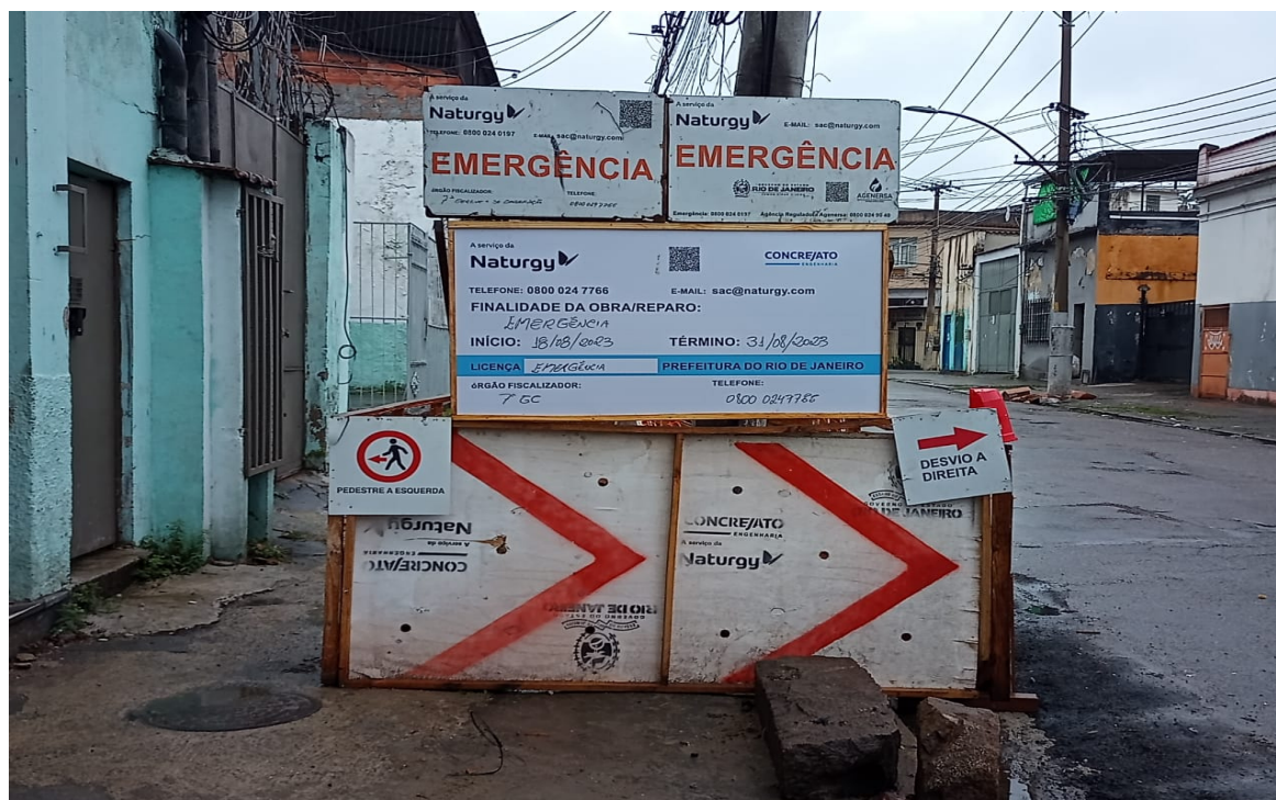
Foto 12: Foi instalada a placa de Identificação da obra
