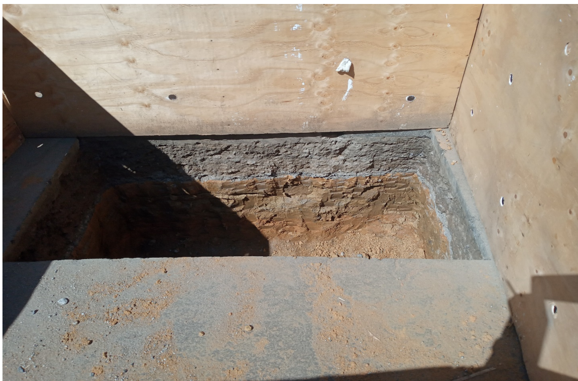
Foto 5: Tie-in em isolamento
