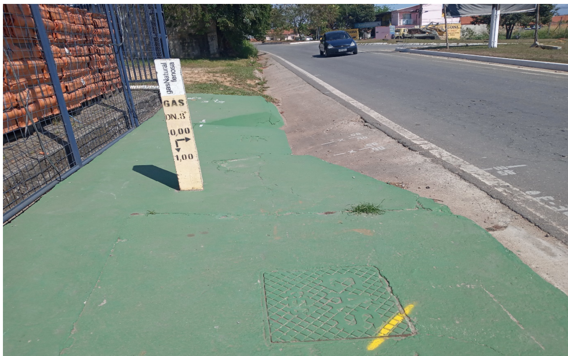
Foto 8: Local onde será realizada a interligação em rede existente
