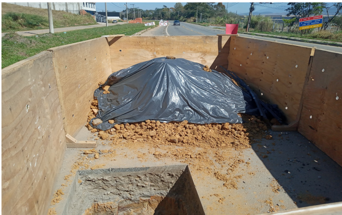
Foto 6: Tie-in para proceder furo direcional
