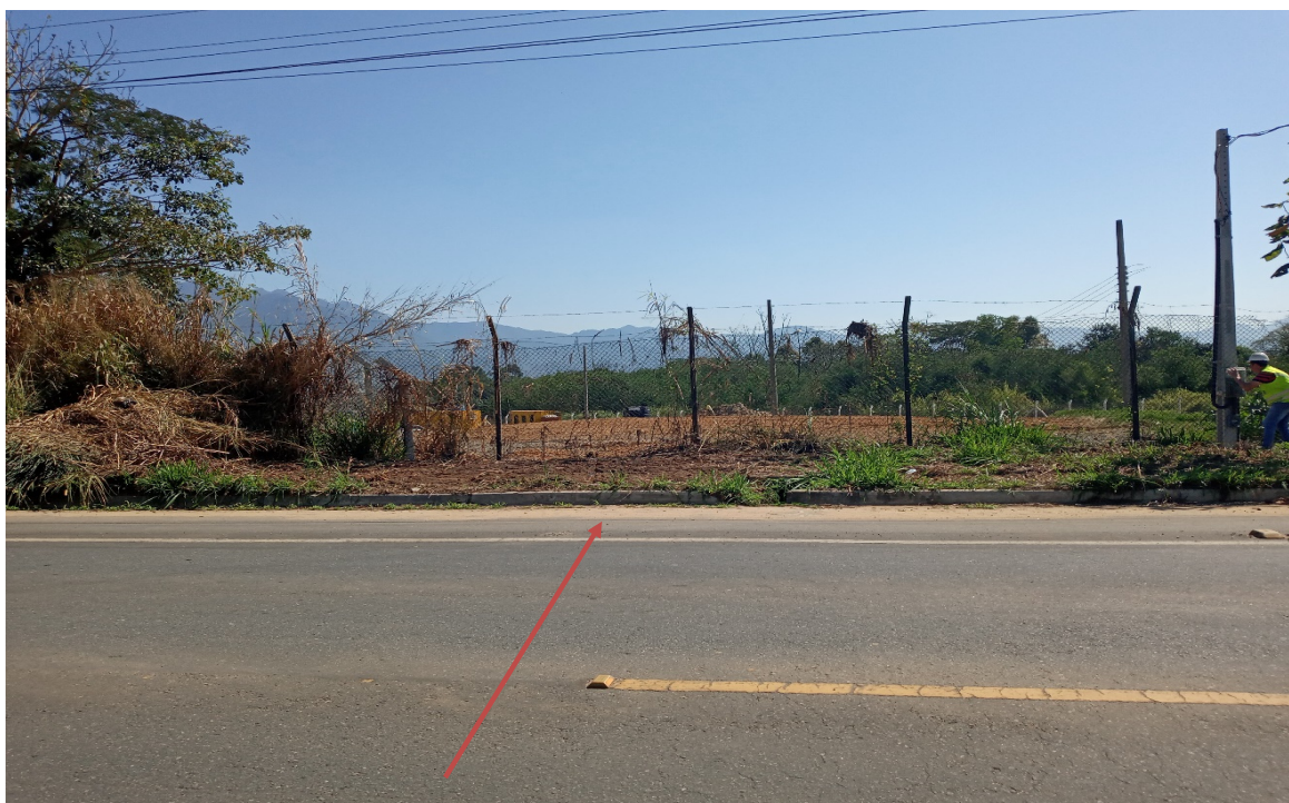
Foto 4: Ponto onde será realizada travessia de rede para construção do ramal
