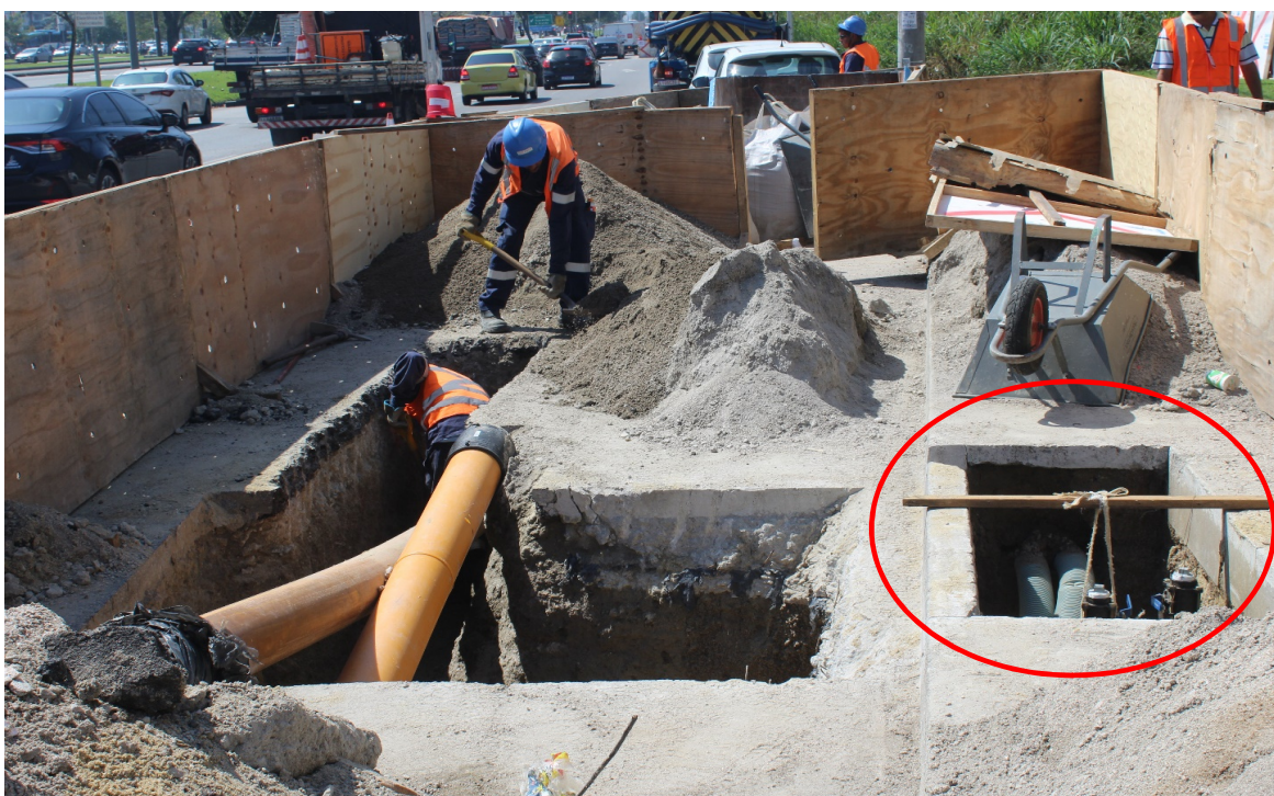
Foto 2: Desvio para instalar válvula de bloqueio com vent
