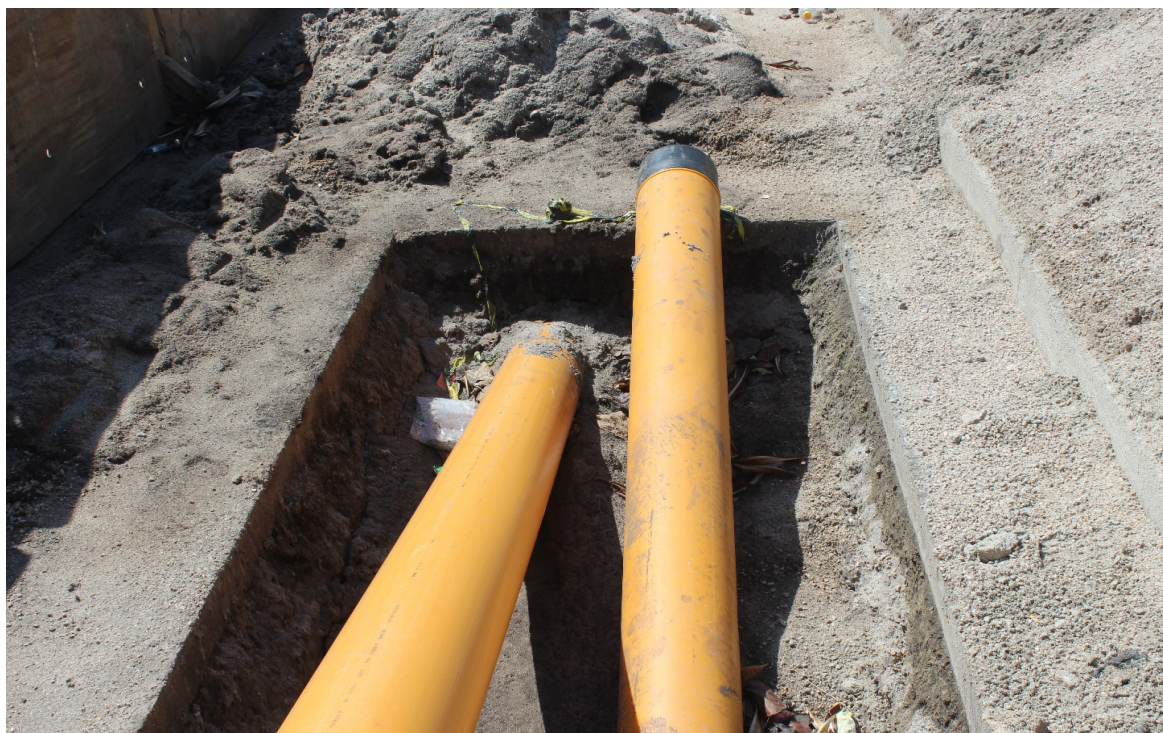
Foto 4: Tubulação a ser conectada por luva (eletrofusão)
