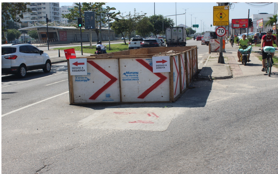
Foto 6: Recomposição provisória e isolamento
