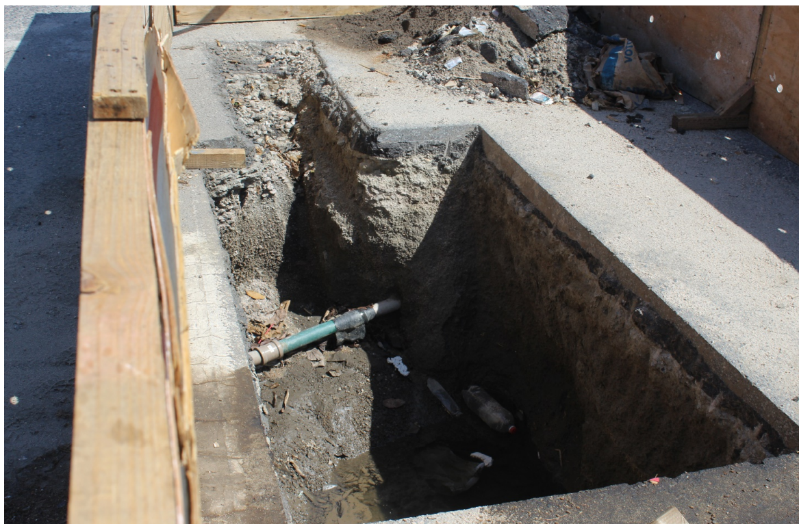
Foto 5: Abertura de Tie-in e isolamento
