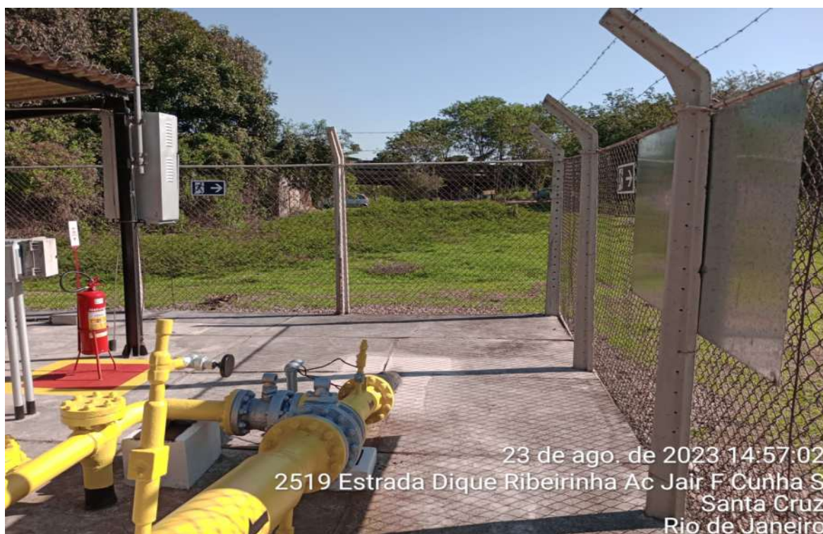
Foto 18: Placas de rota de fuga
