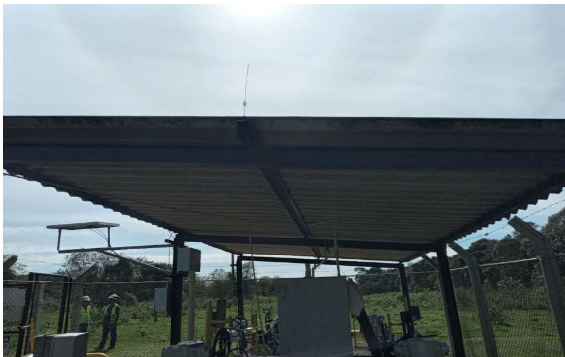
Foto 9: Cobertura da estação
