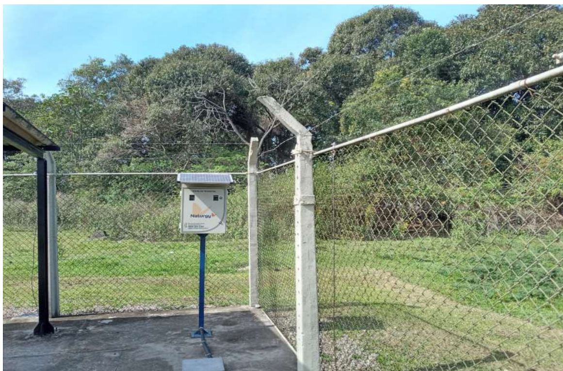
Foto 12: Ausência de placa de rota de fuga
