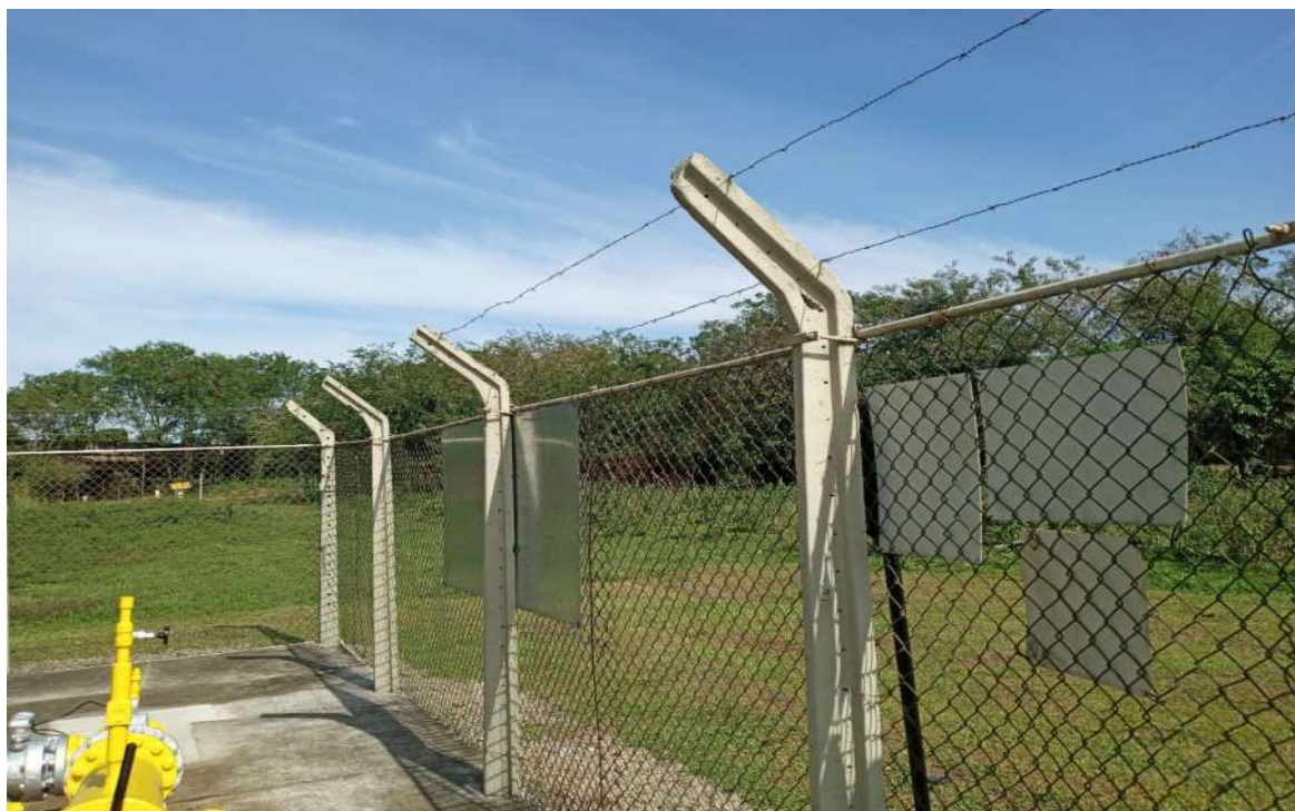
Foto 13: Ausência de placa de rota de fuga
