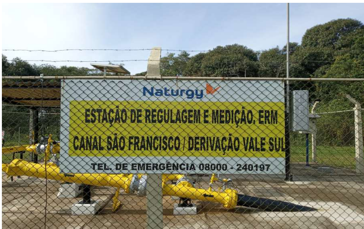
Foto 1: Placa de identificação da estação
