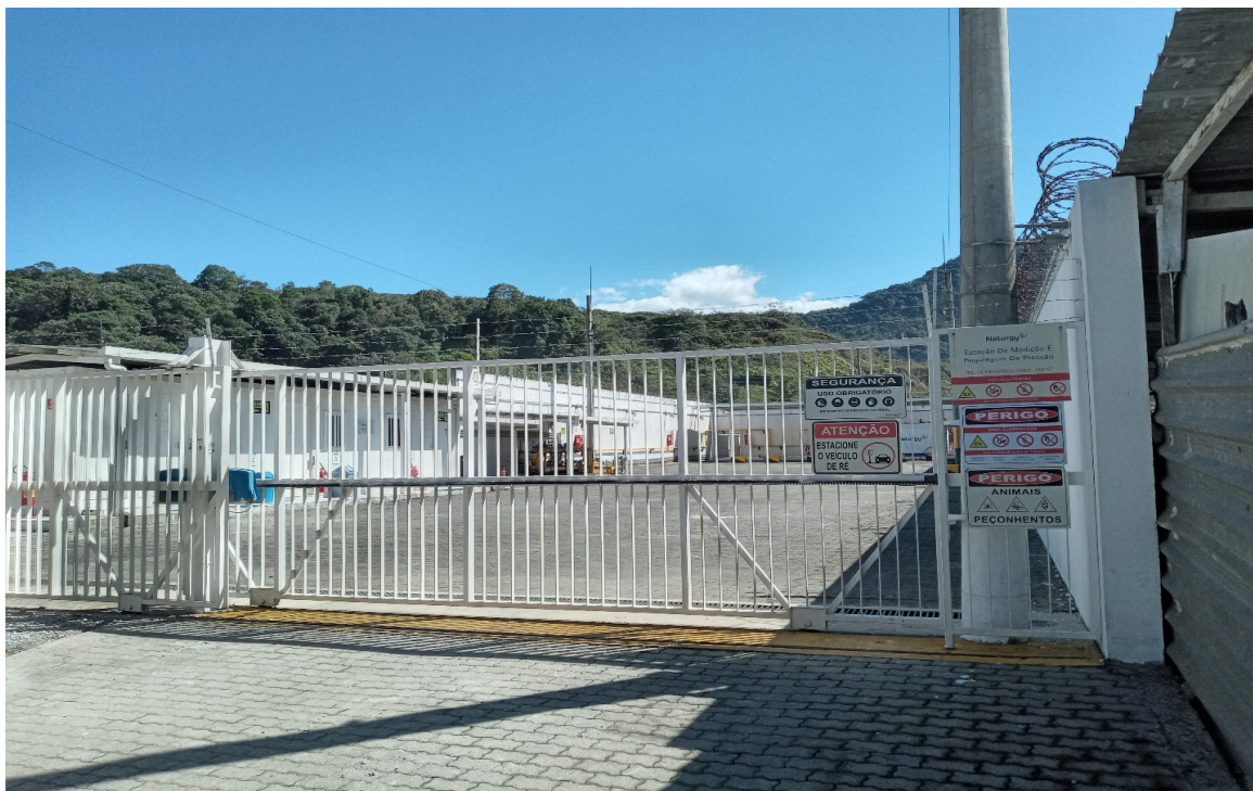
Foto 15: Nova estação de descompressão (em fase de finalização de montagem)
