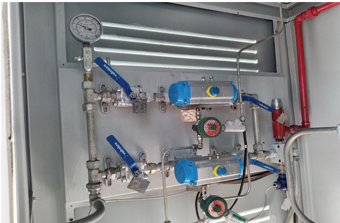
Foto 6: Regulagem de pressão - 220 / 8 bar
