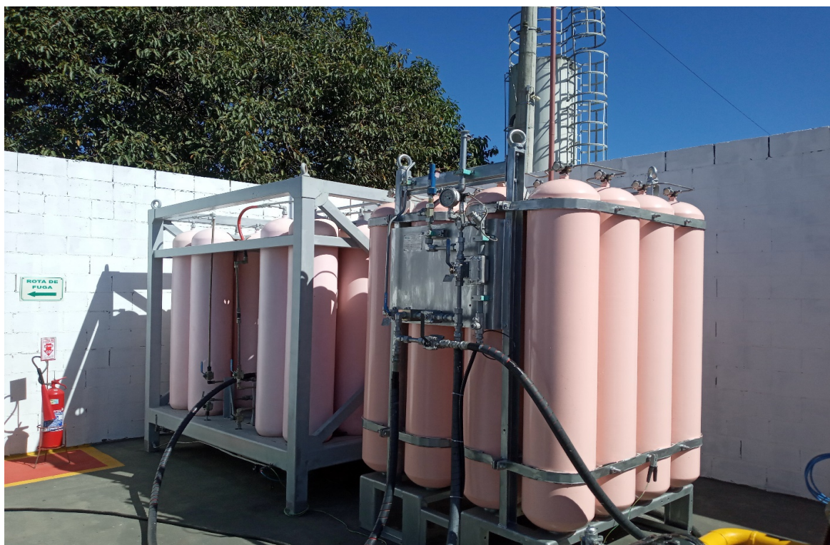
Foto 4: Estocagem (32 e 16 cilindros)
