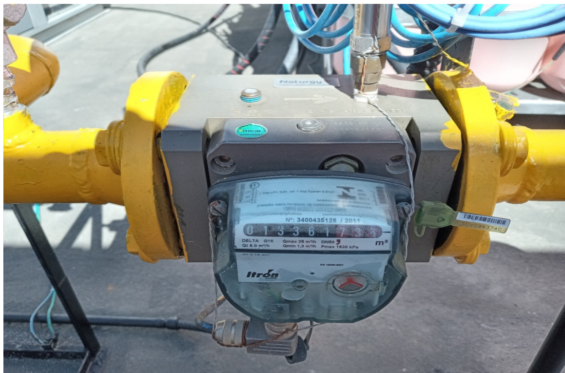
Foto 10: Medidor de vazão (rotivo)
