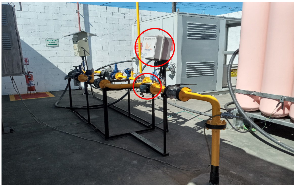
Foto 7: Medidor e conversor de volume
