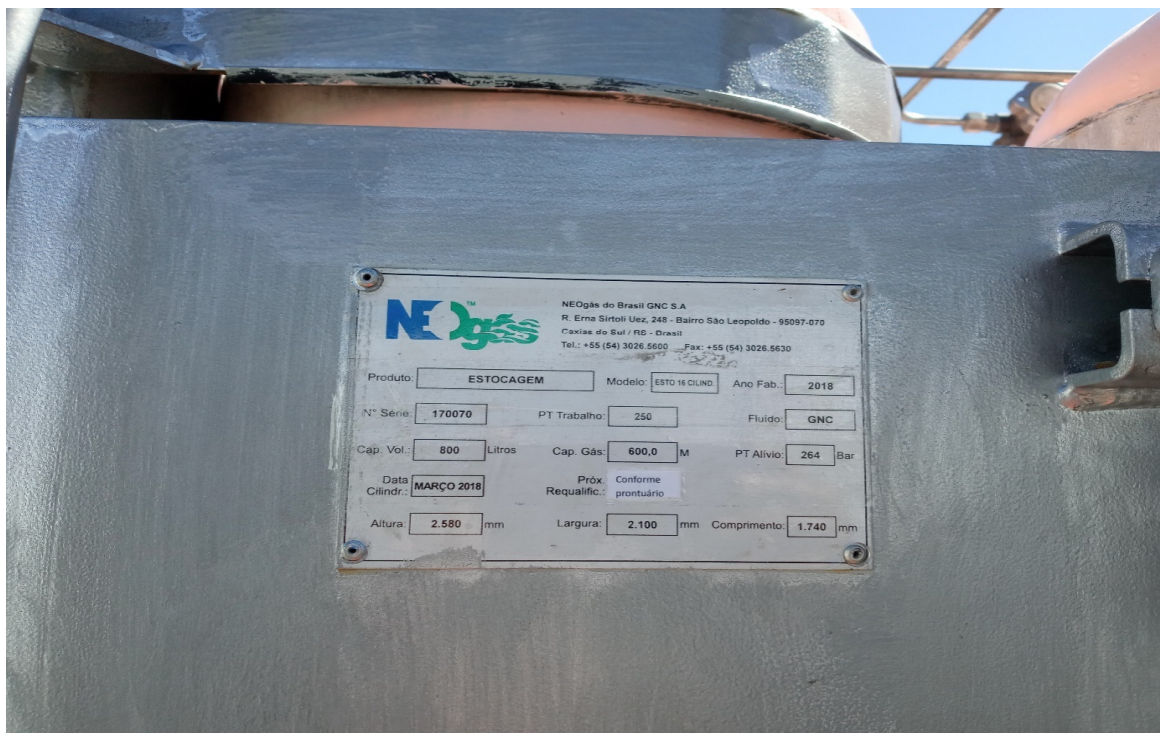
Foto 5: Informações técnicas (cilindros)
