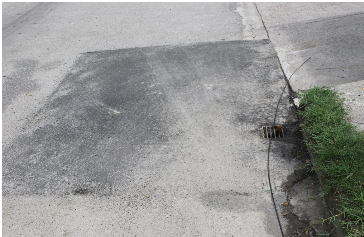
Foto 5: Recomposição da via em abertura de tie-in
