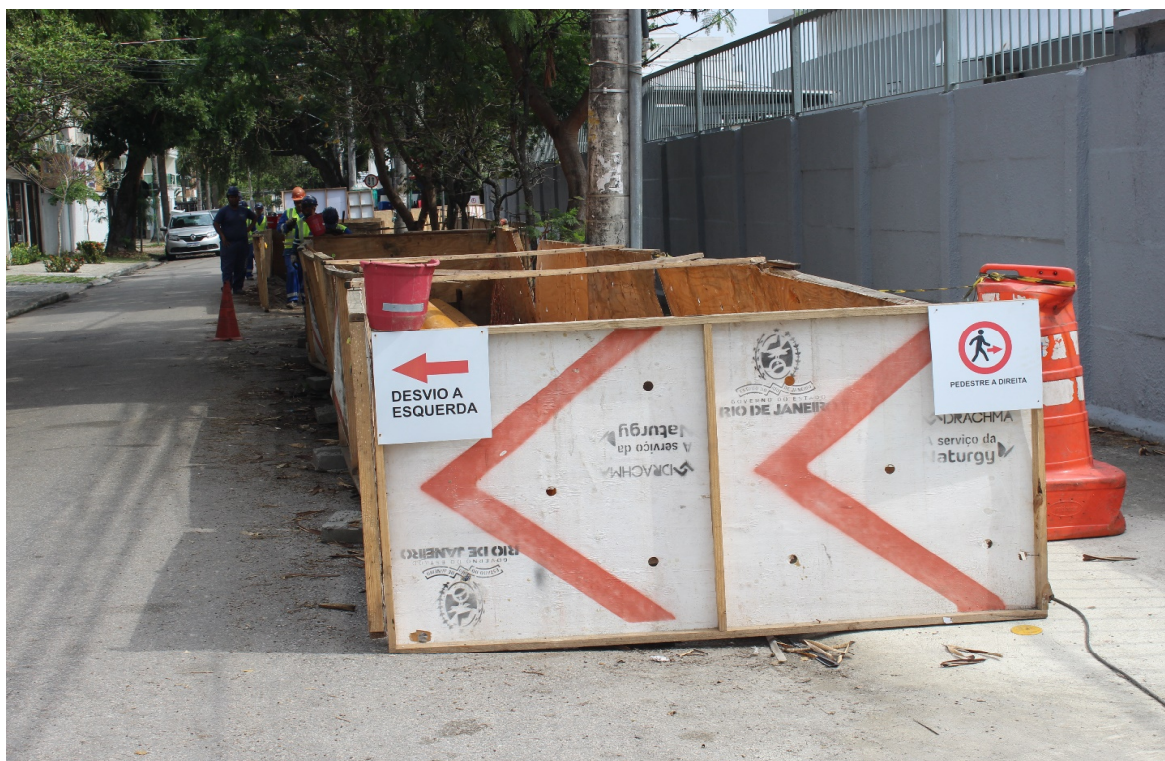
Foto 7: Armazenamento de tubos
