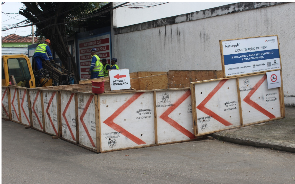
Foto 11: Máquina perfuratriz em processo de alargamento de furação
