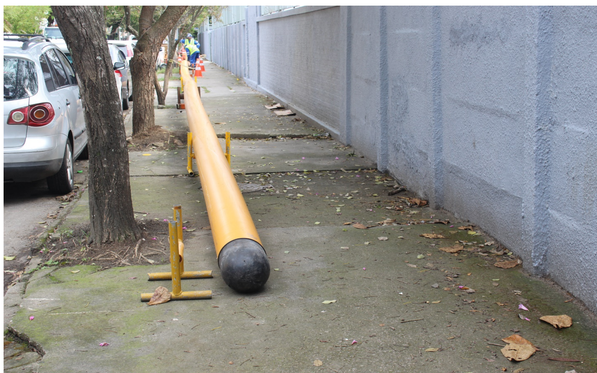
Foto 6: Tubulação sendo preparada para inserção
