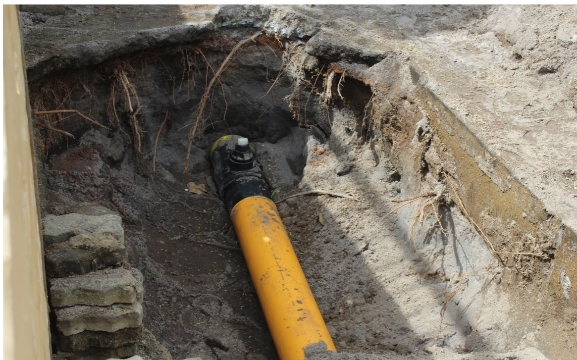
Foto 8: Ponto de instalação de caixa de válvula de bloqueio
