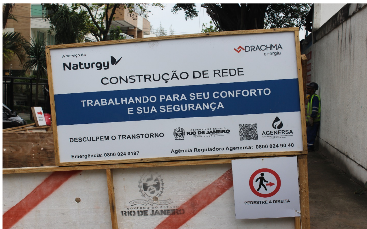
Foto 2: Isolamento e sinalização
