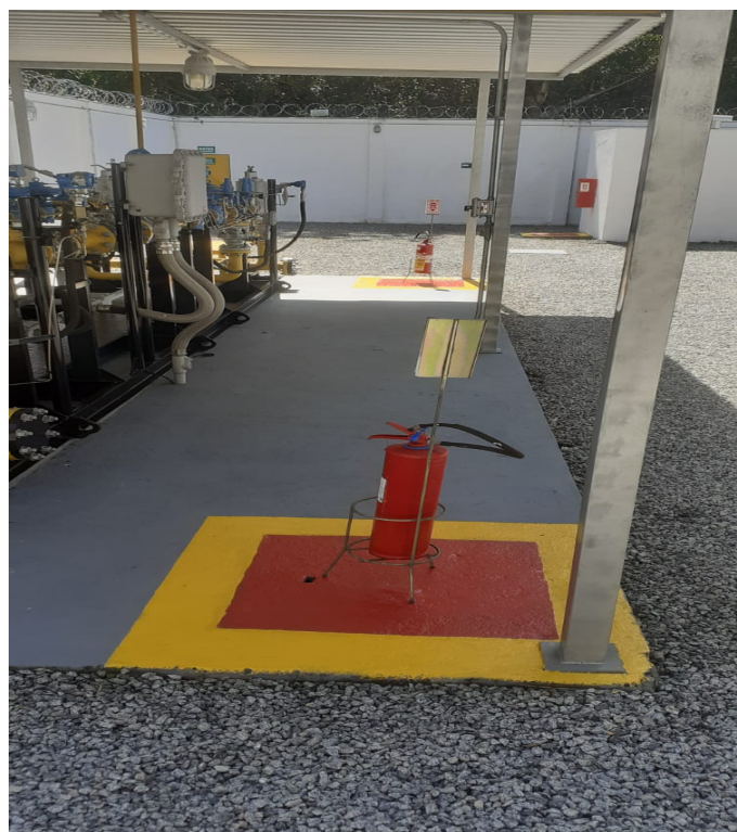
Foto 20: Demarcação da área do piso (Extintores)
