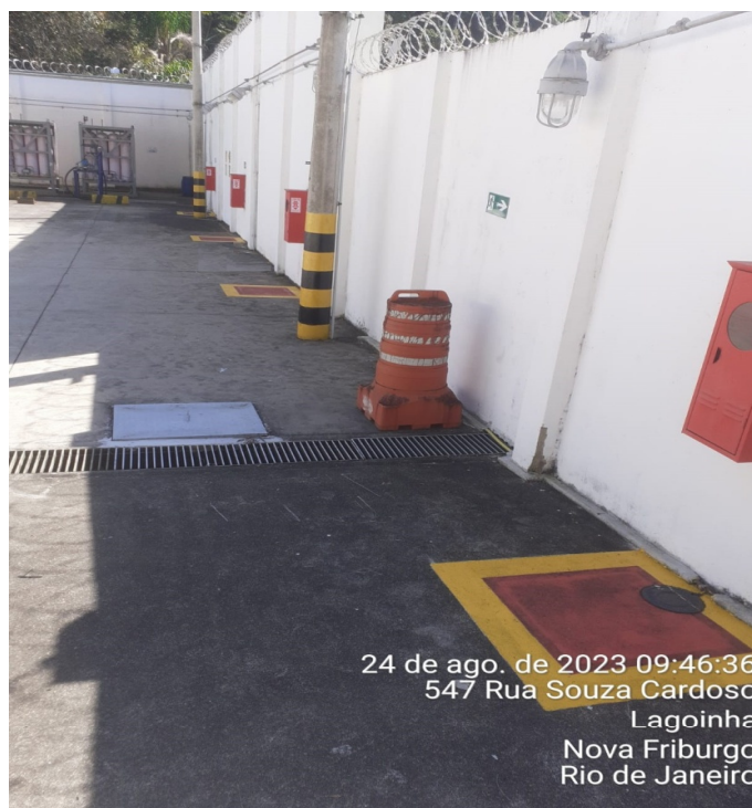
Foto 19: Demarcação da área do piso (Extintores)
