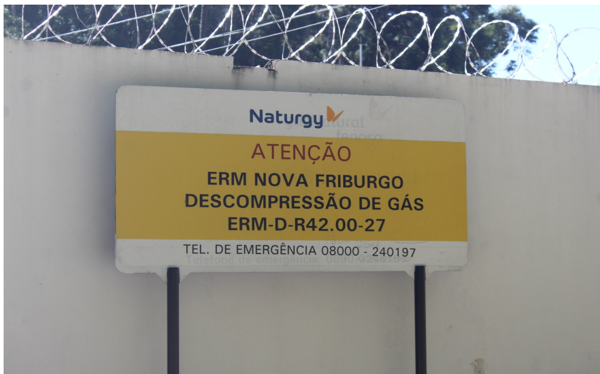
Foto 1: Placa de identificação da estação
