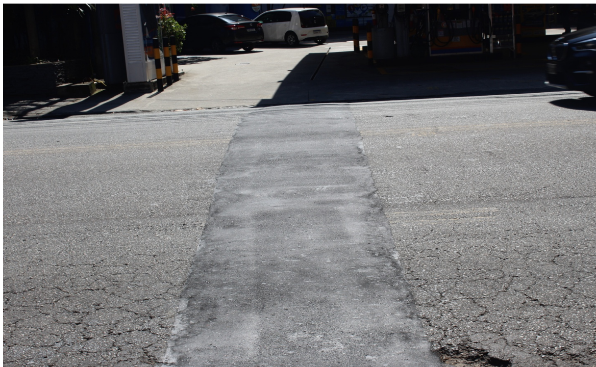
Foto 6: Recomposição da via em local de travessia de rede
