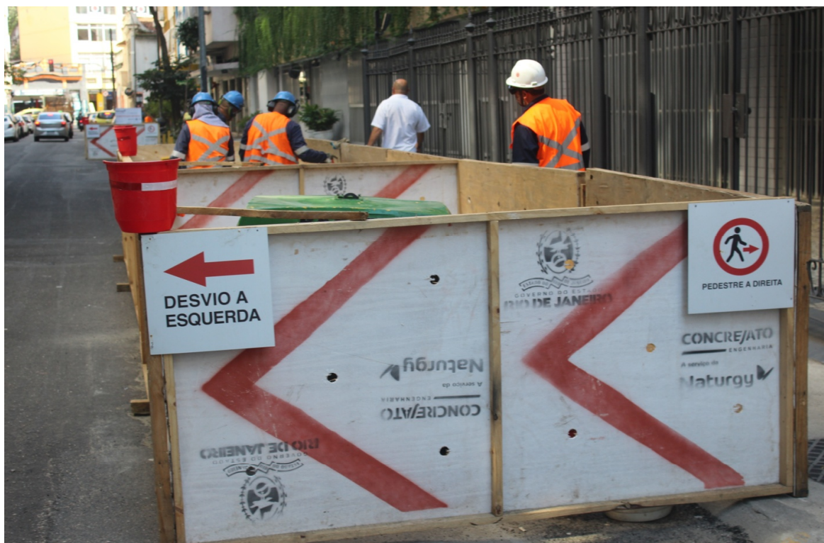
Foto 3: Equipe executando recorte no asfalto para realizar abertura de vala
