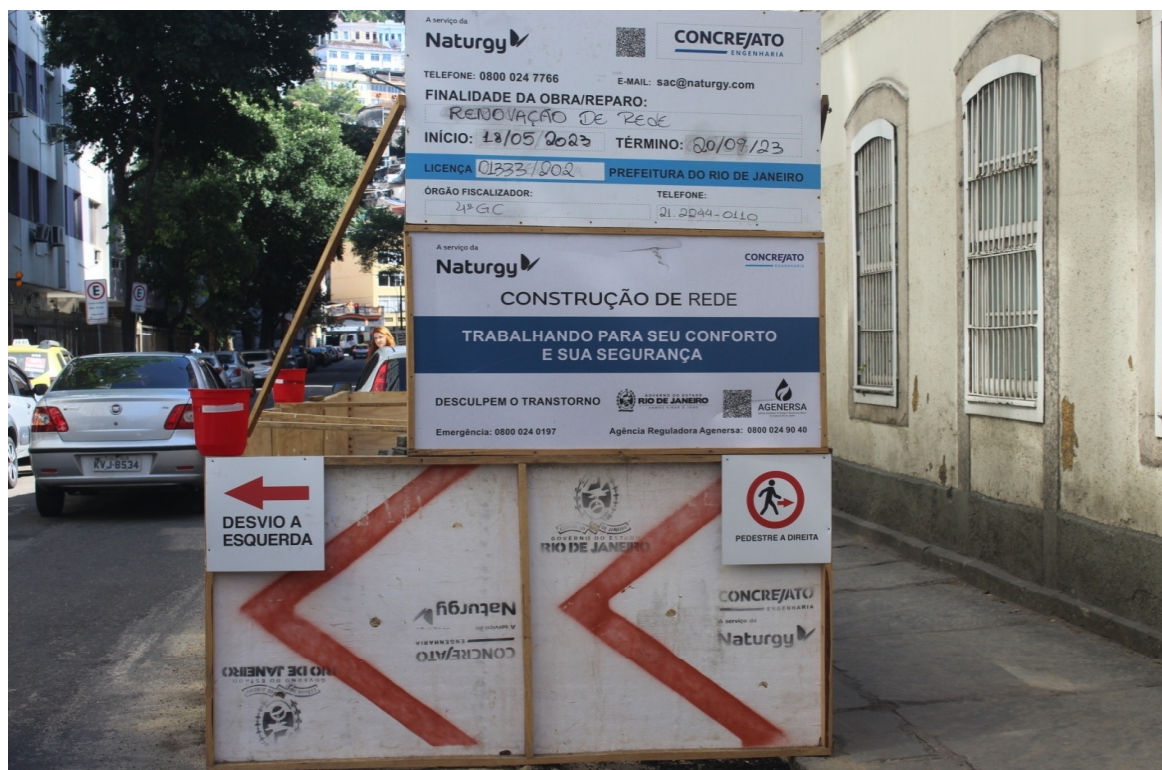
Foto 1: Ponto de início da obra
