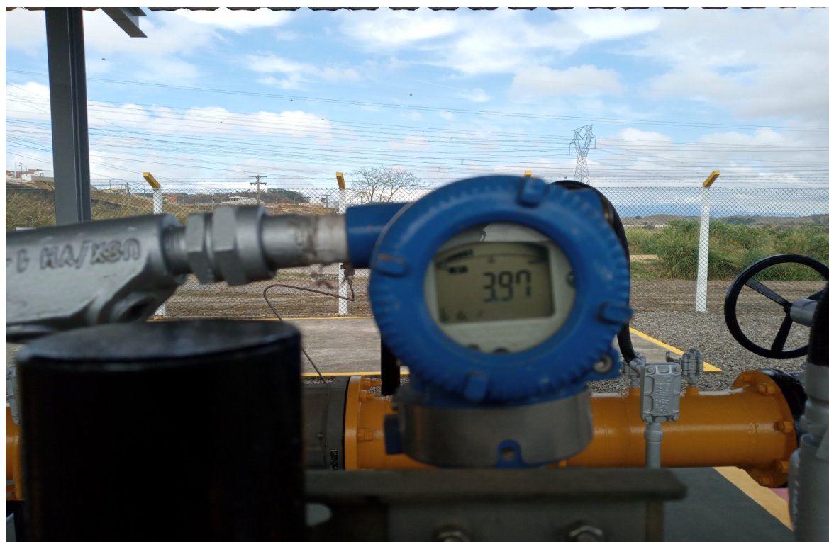
Foto 14: Medidor de pressão (ERM Votorantim)
