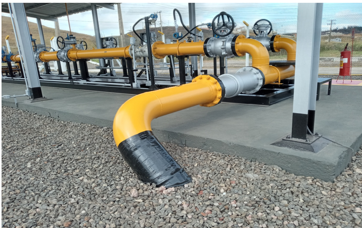
Foto 15: Saída de gás com pressão reduzida de 16 / 4 bar para Votorantin
