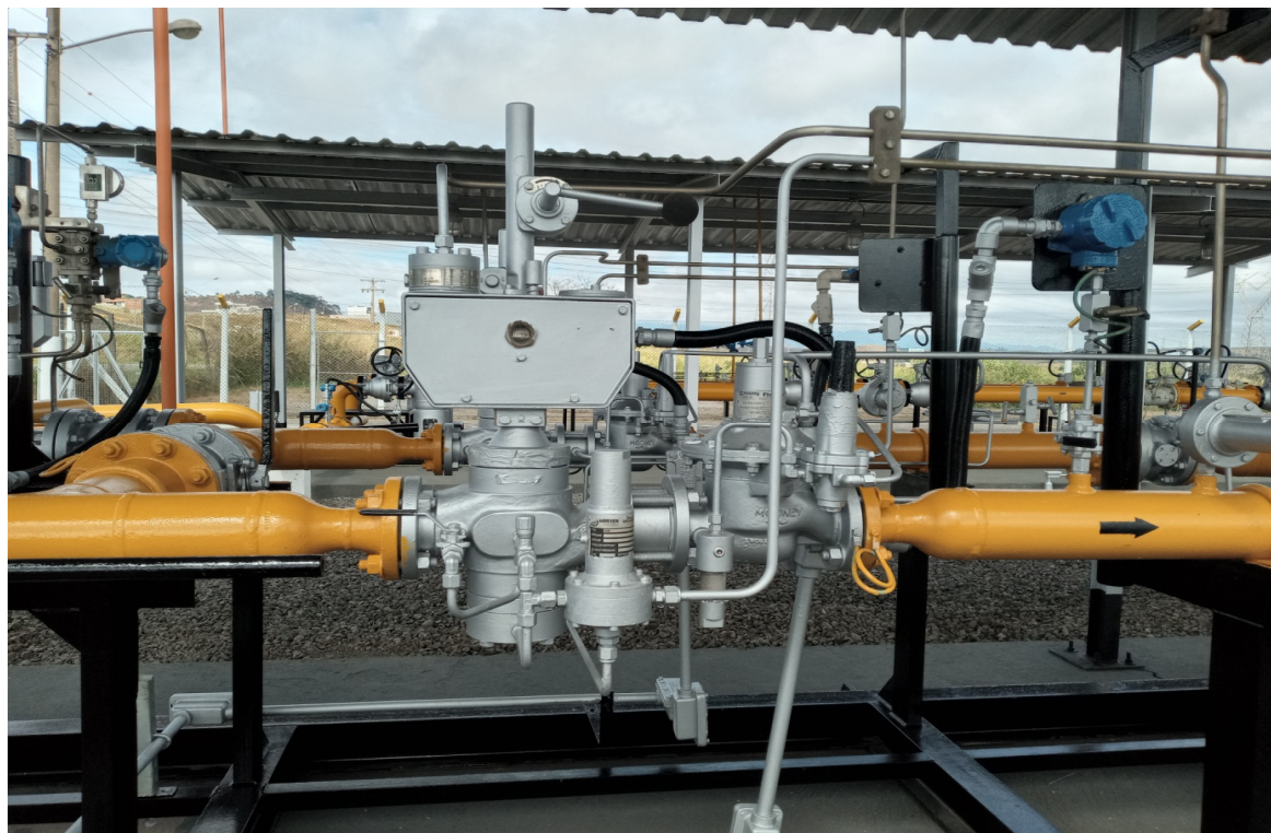
Foto 6: Regulagem de pressão - 16 / 7 bar (ERM Itatiaia)
