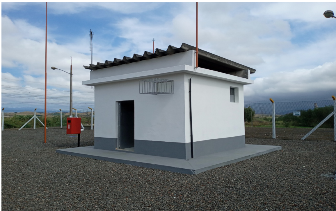
Foto 9: Sala de controle
