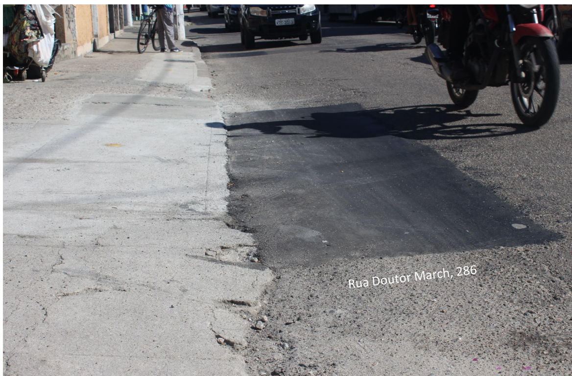
Foto 1: Ponto de início da obra (interlgação)
