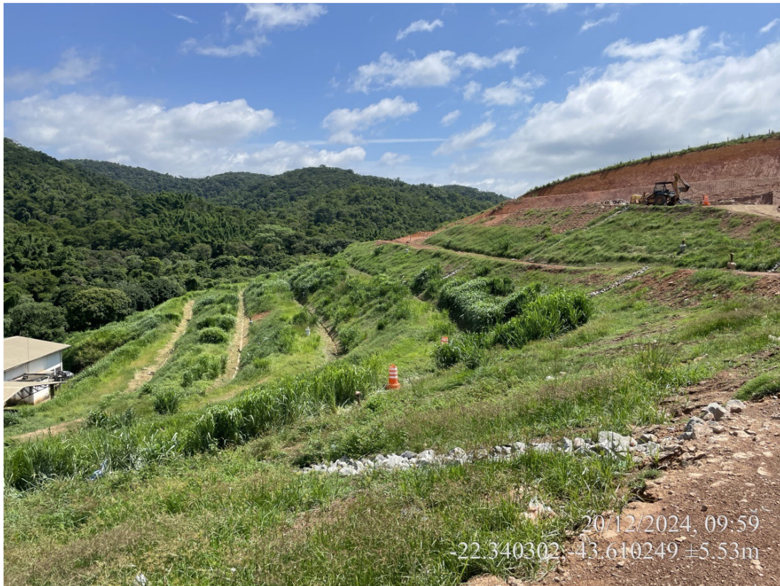
Figura 7: Cobertura vegetal do talude
