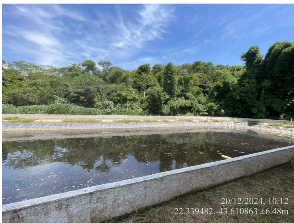
Figura 9: Lagoa de armazenamento de chorume
