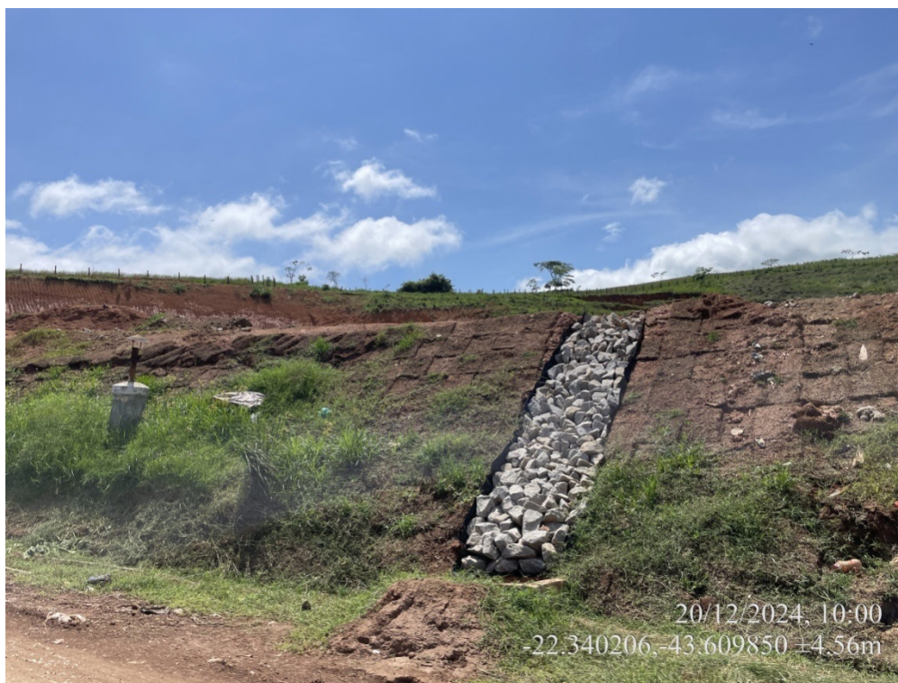
Figura 6: Sistema de drenagem e cobertura vegetal do talude
