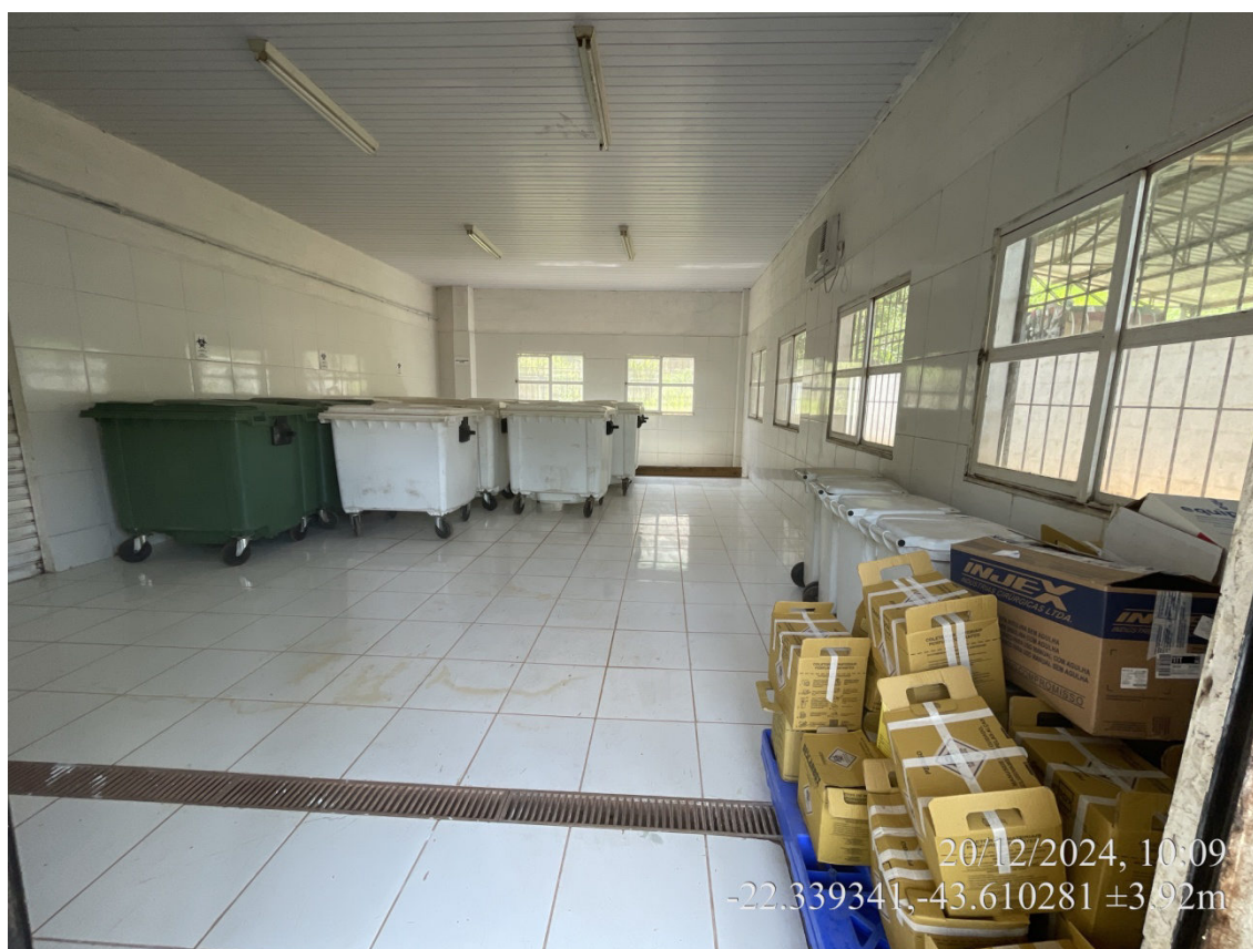
Figura 10: Abrigo temporário de RSS. Onde os resíduos são estocados até serem direcionados a empresa contratada para realizar a autoclavagem
