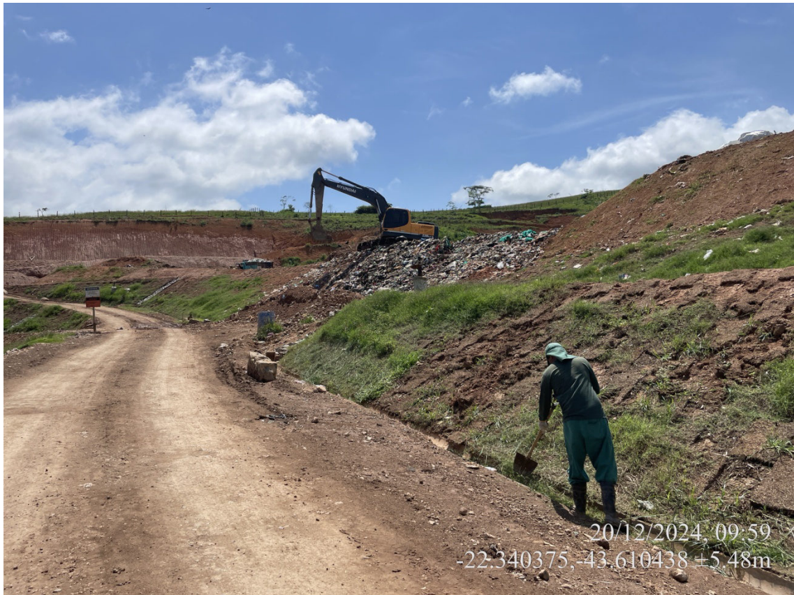
Figura 4: Acesso a Frente de trabalho
