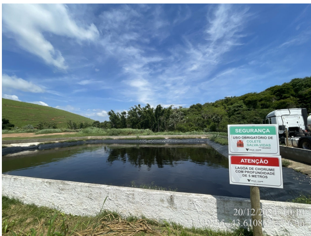
Figura 8: Lagoa de armazenamento de chorume
