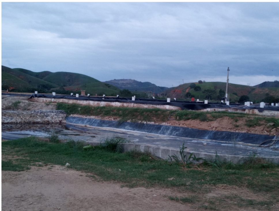
Figura 9: Leito de secagem do lodo
