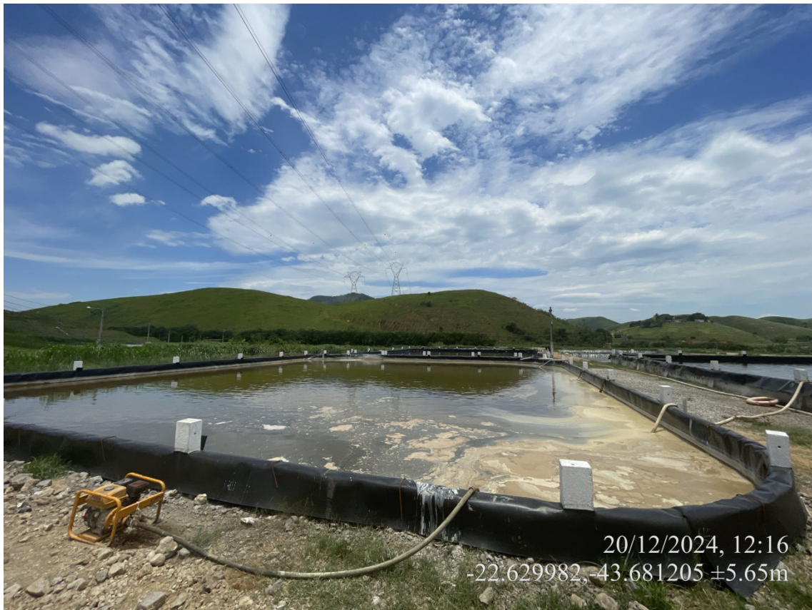
Figura 7: Lagoa de recebimento de chorume
