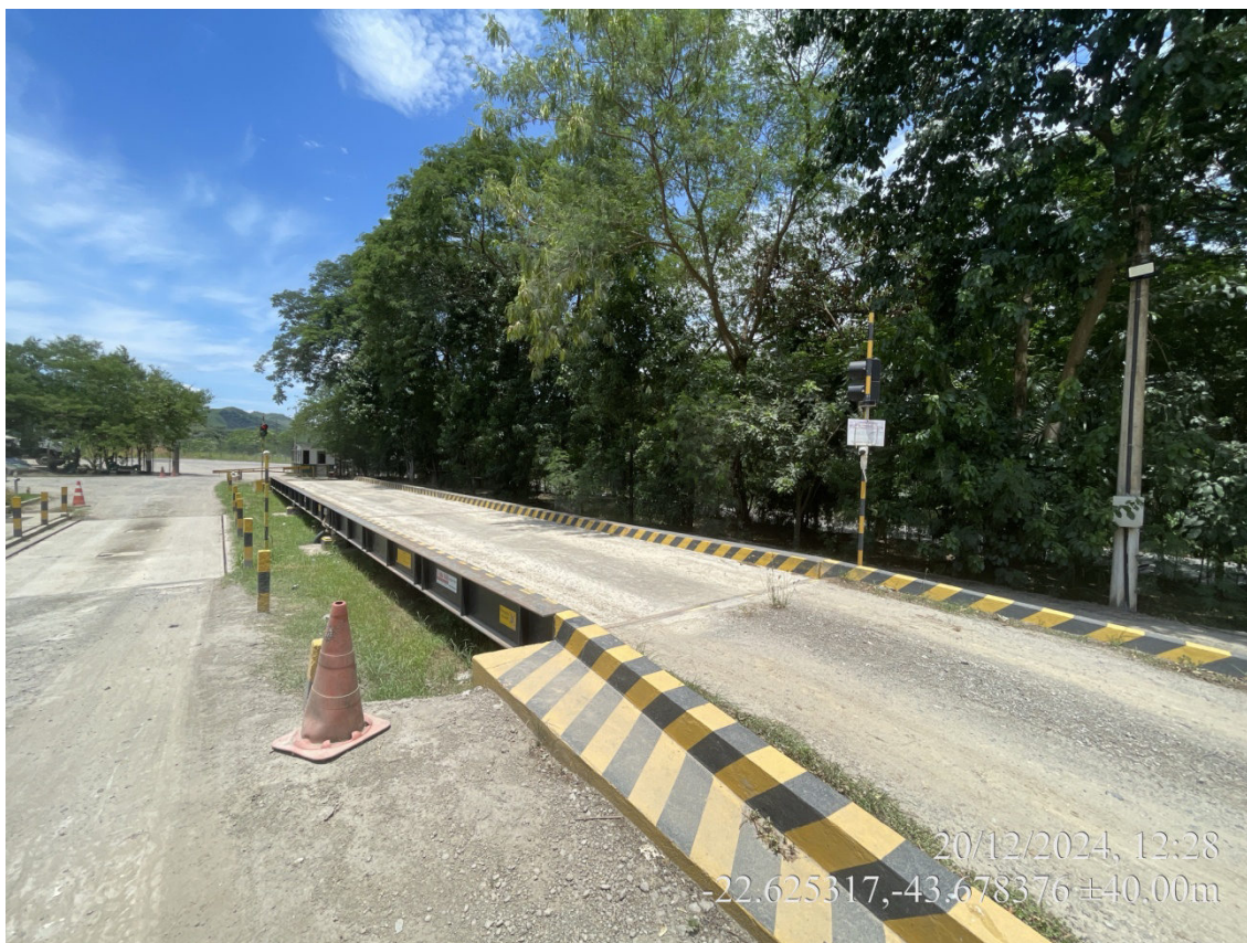
Figura 2: Vista das balanças de pesagem
