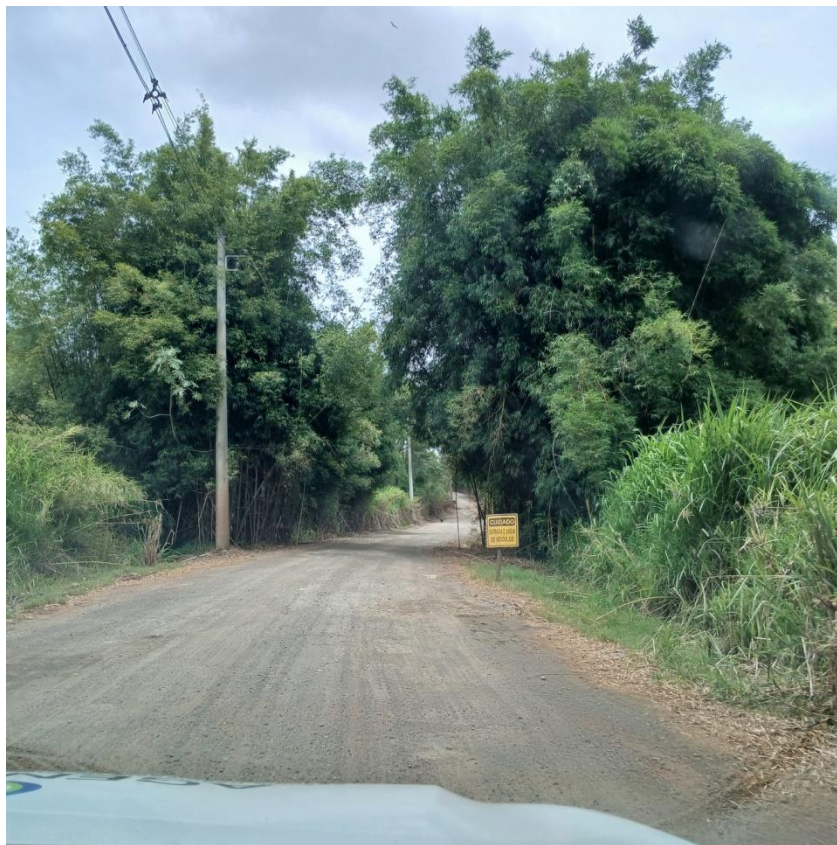
Figura 3: Estrada de acesso ao CTDR - Sinalização ao longo da estrada de acesso ao CTDR em bom estado e visível
