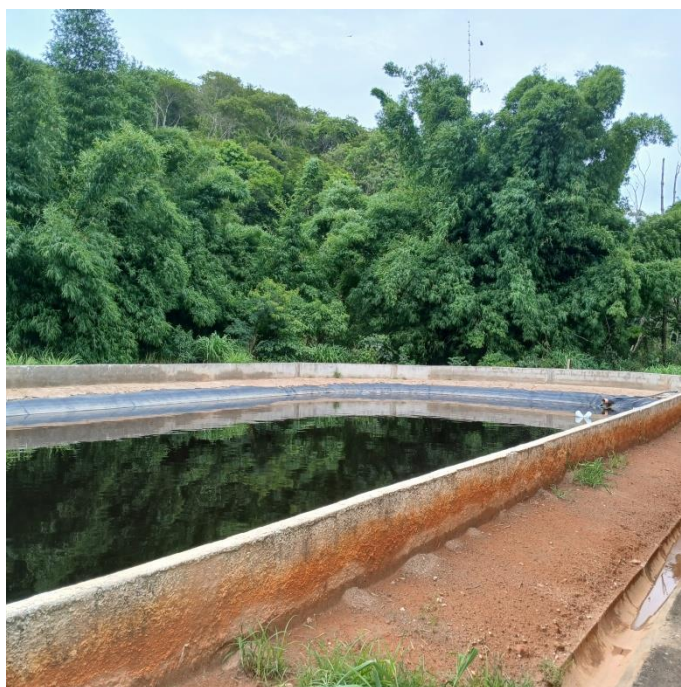
Figura 15: Lagoa de armazenamento de chorume
