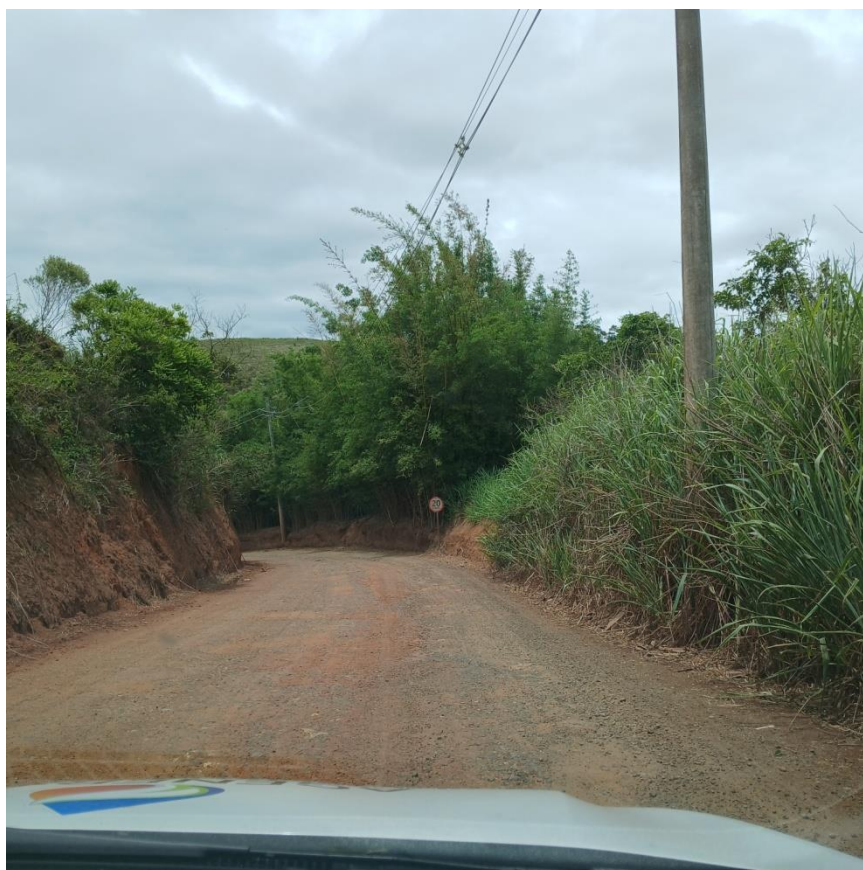
Figura 2: Estrada de acesso ao CTDR - Sinalização ao longo da estrada de acesso ao CTDR em bom estado e visível
