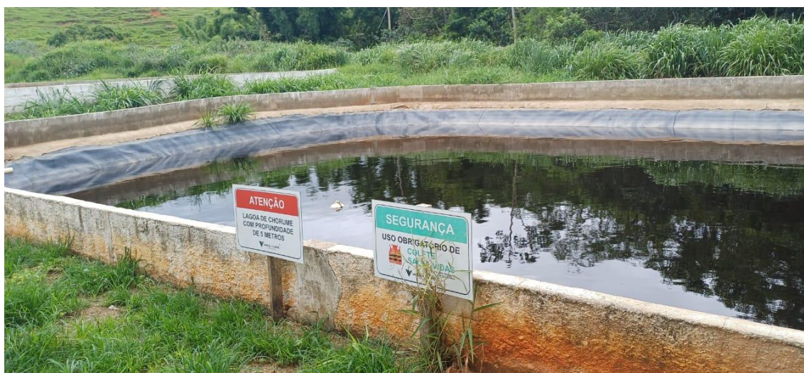
Figura 16: Lagoa de armazenamento de chorume
