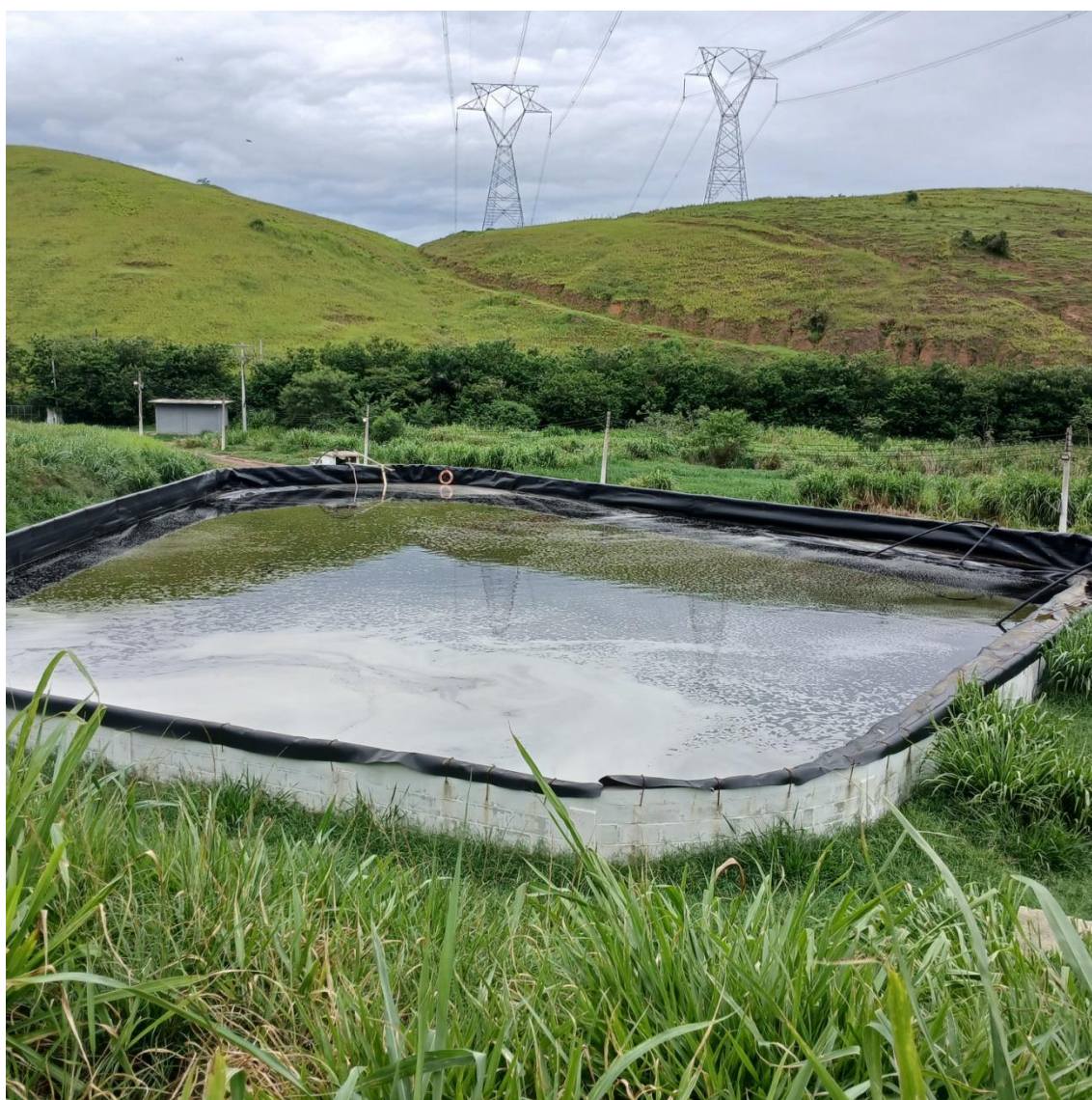
Figura 12: Lagoa primária de recebimento de chorume
