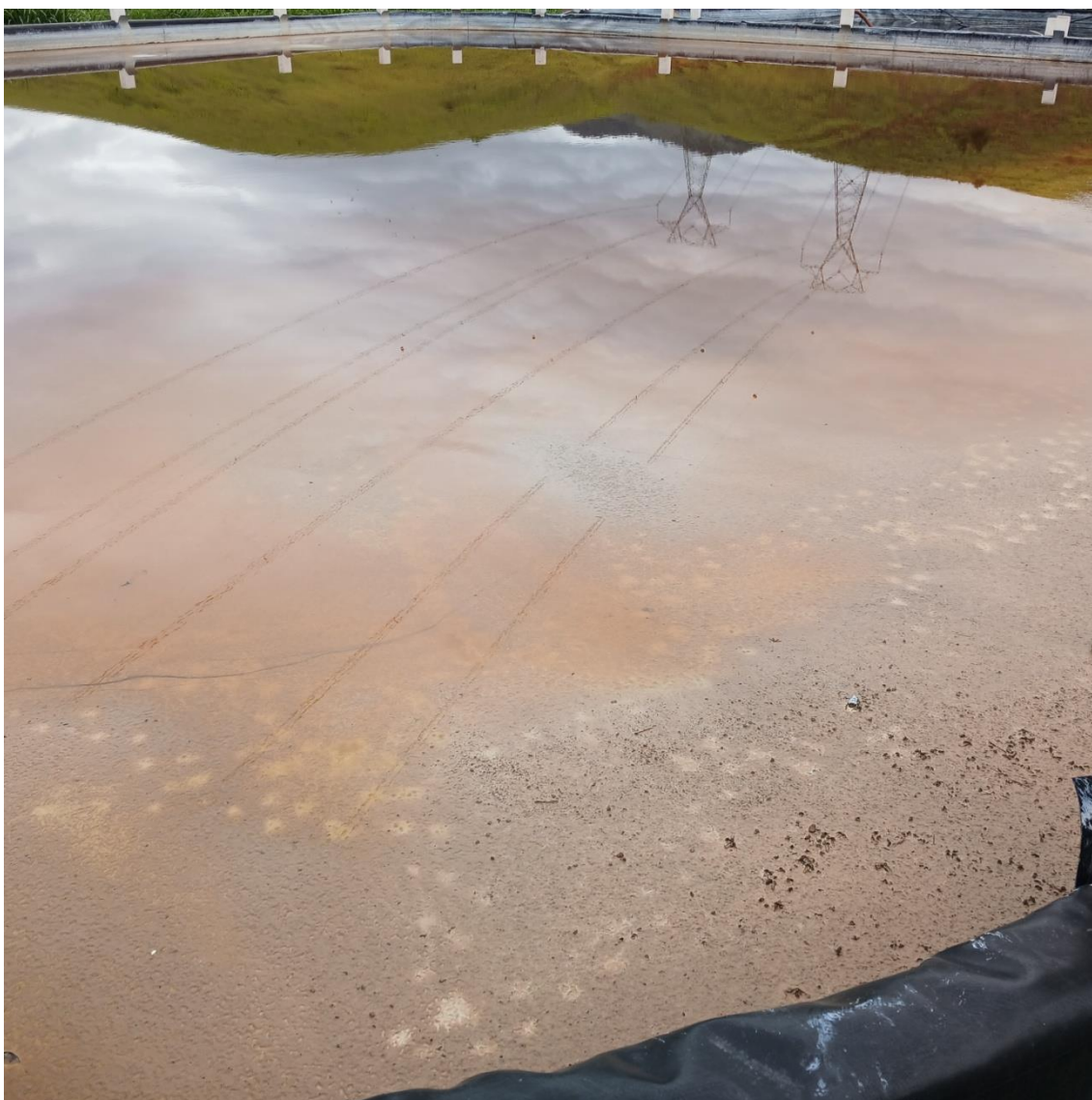
Figura 13: Lagoa secundária de recebimento de chorume
