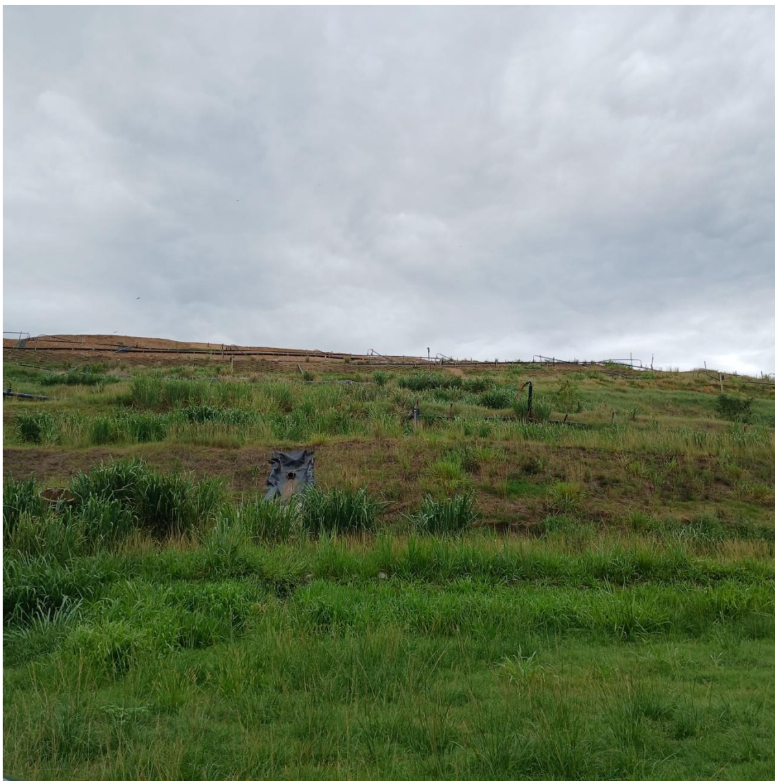
Figura 11: Cobertura vegetal do maciço e dutos de captação de gás
