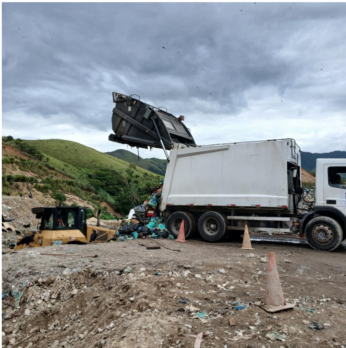
Figura 6: Frente de trabalho ( Caminhão Descarregando)
