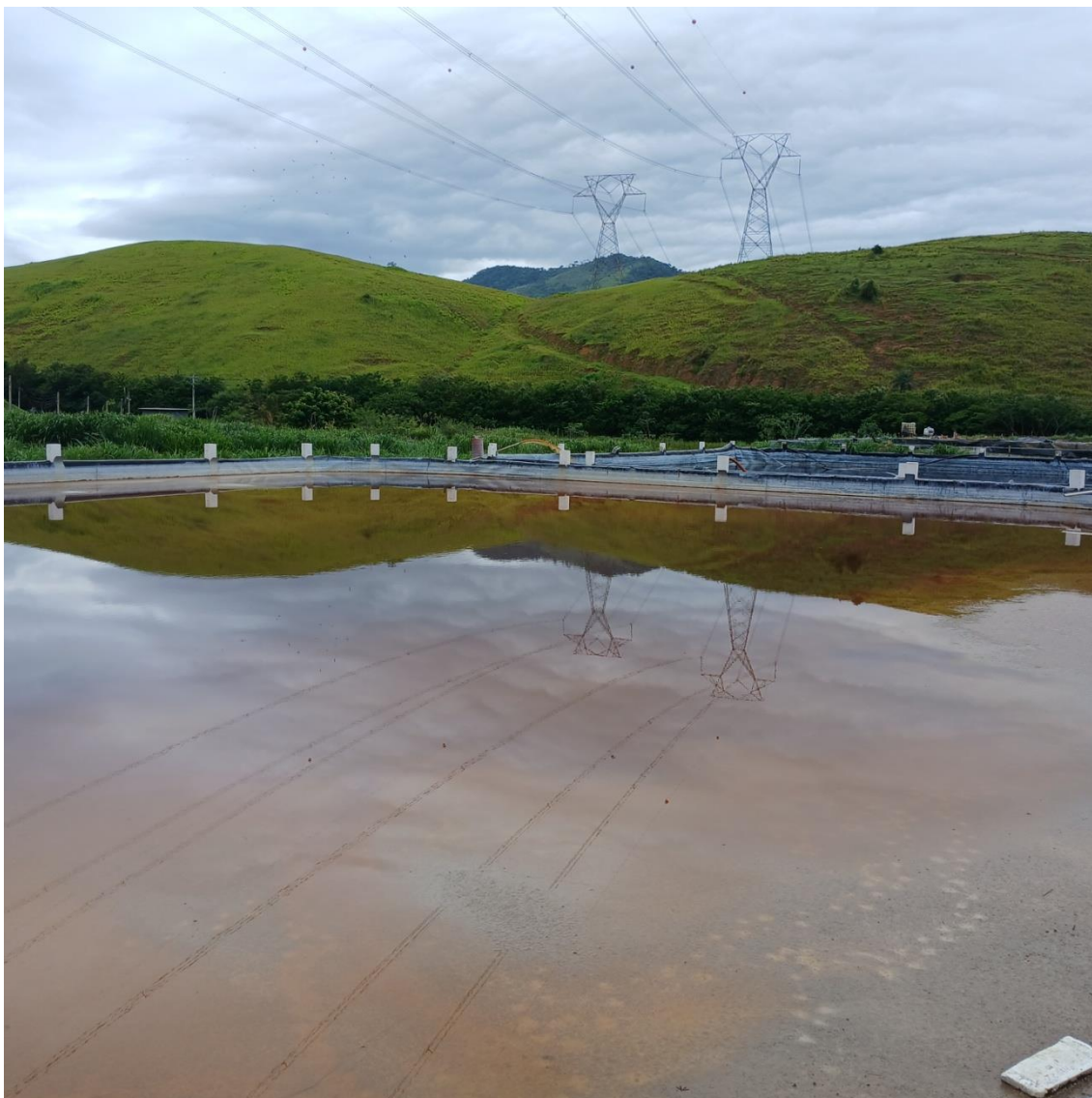
Figura 14: Lagoa secundária de recebimento de chorume
