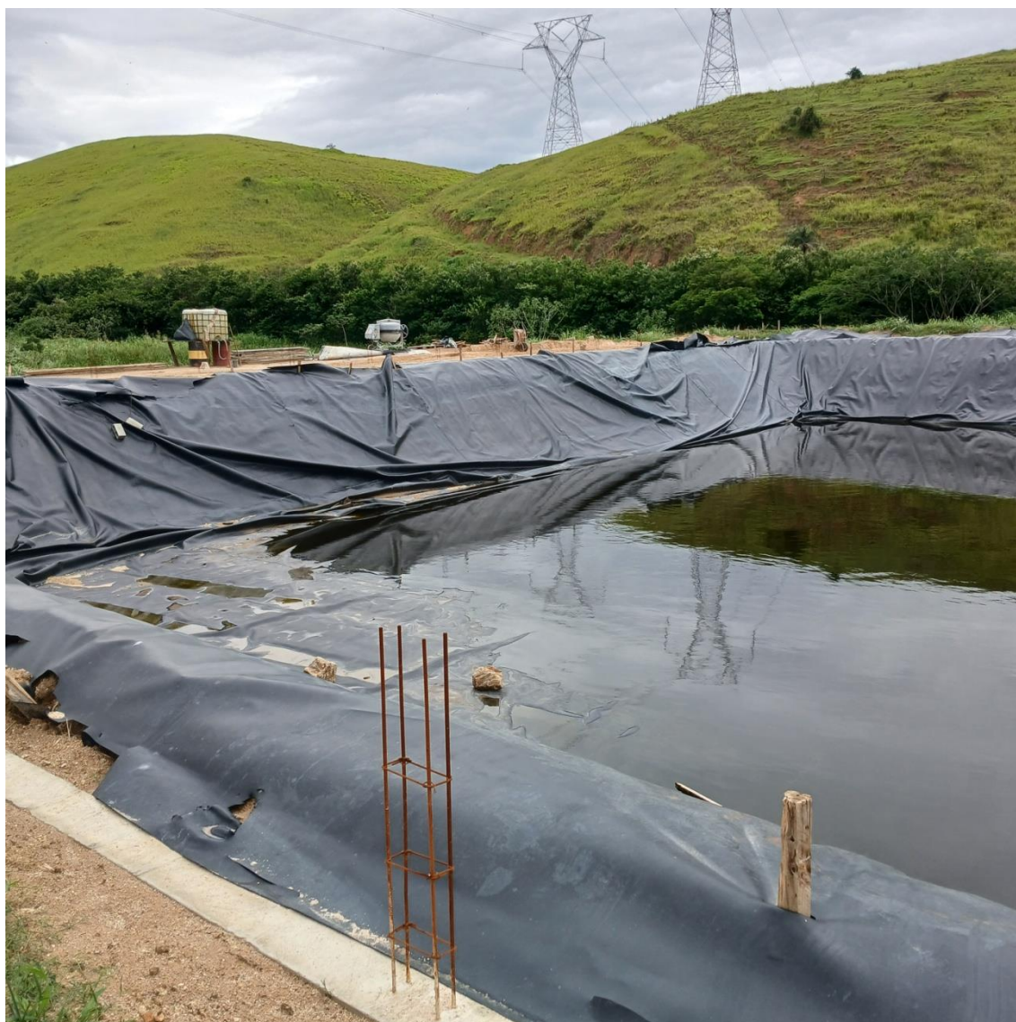
Figura 18: Área de expansão com novas lagoas de recebimento de chorume
