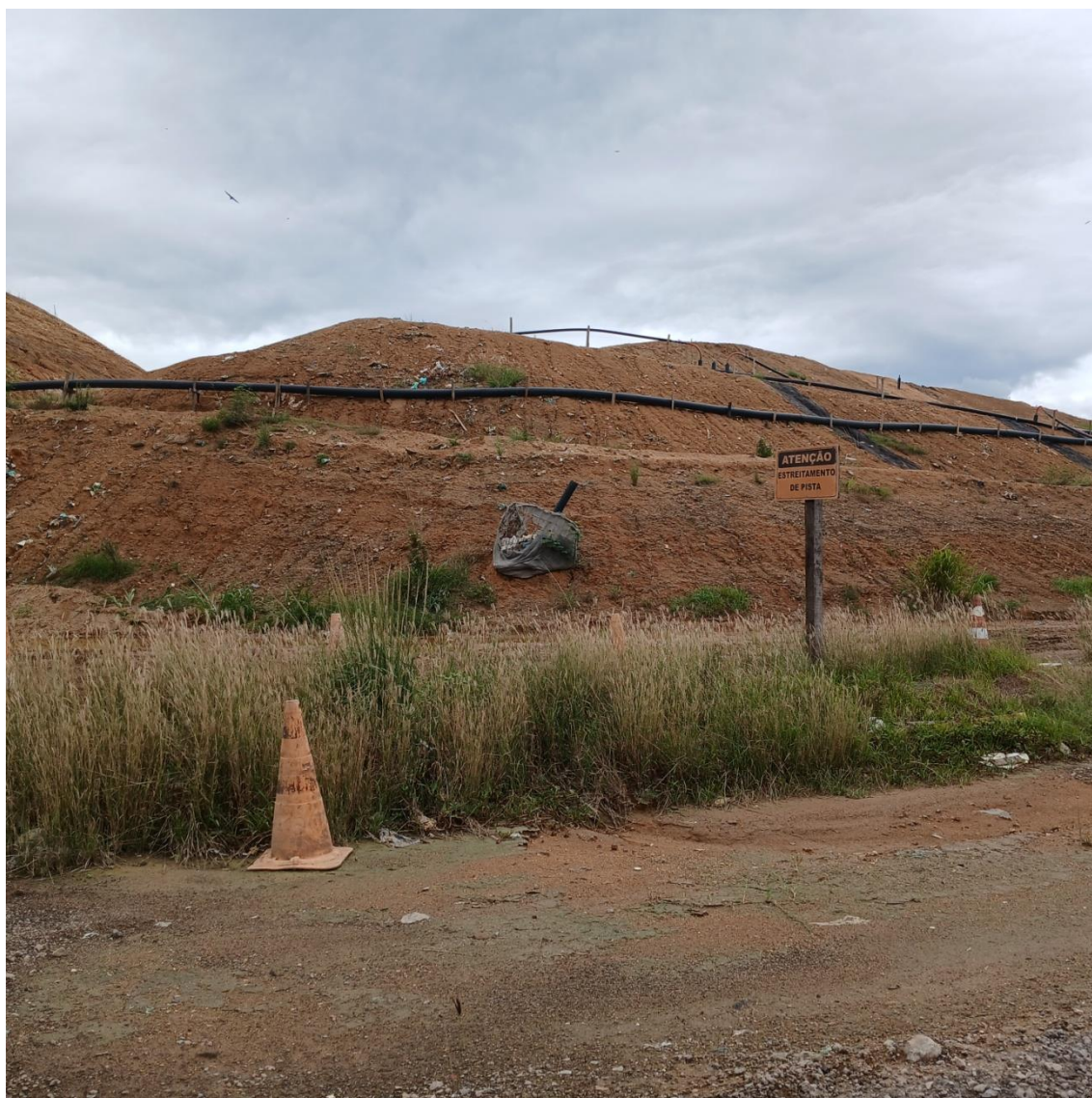
Figura 9: Dutos de captação de gás
