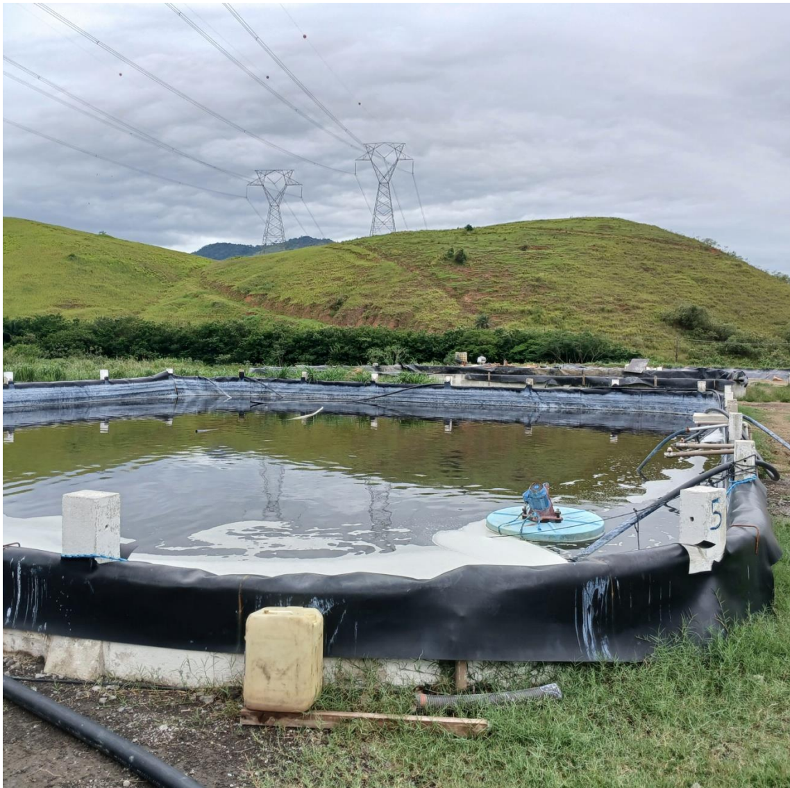
Figura 15: Lagoa secundária de recebimento de chorume com aeradores
