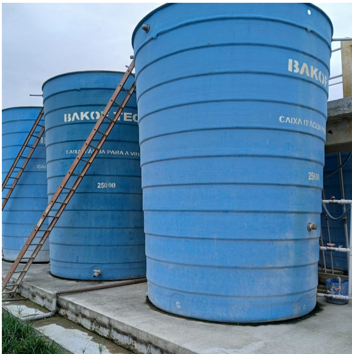
Figura 20: Tanques da Estação de tratamento
