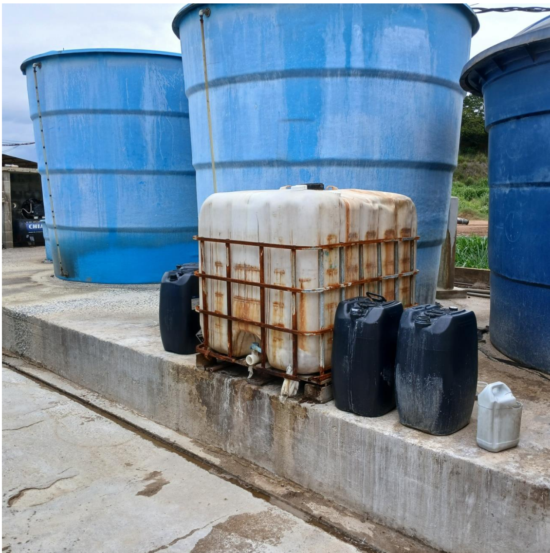
Figura 22: Tanque de armazenamento de produtos químicos para tratamento do chorume.
