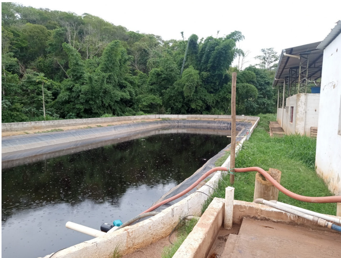
Figura 14: Lagoa de armazenamento de chorume
