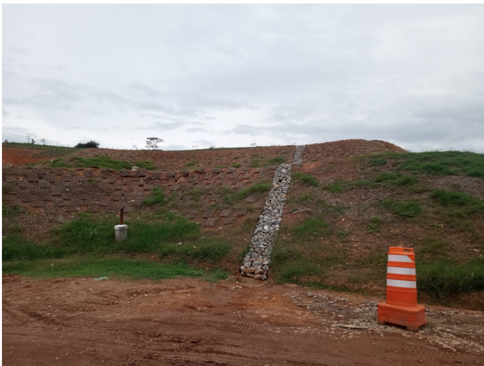
Figura 9: Sistema de drenagem e cobertura vegetal do talude
