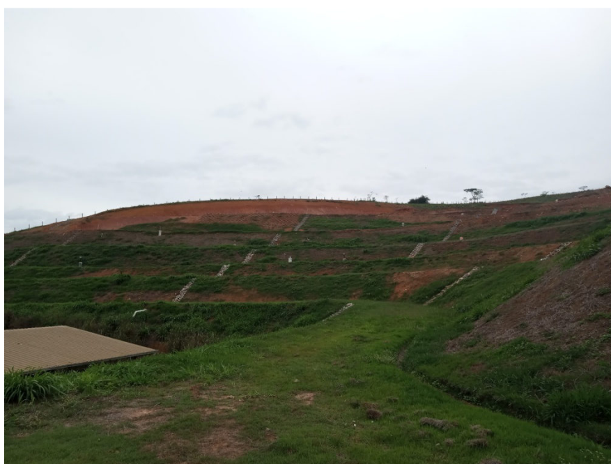
Figura 12: Cobertura vegetal do talude
