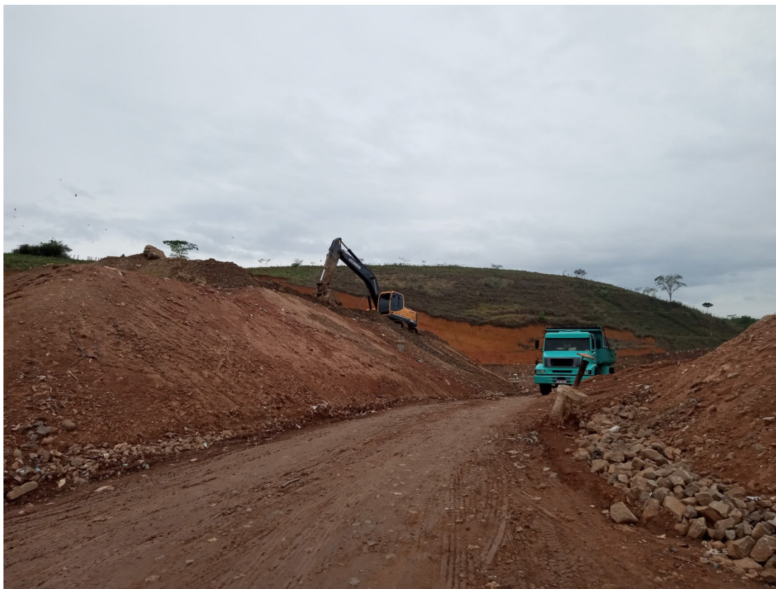
Figura 4: Acesso a Frente de trabalho
