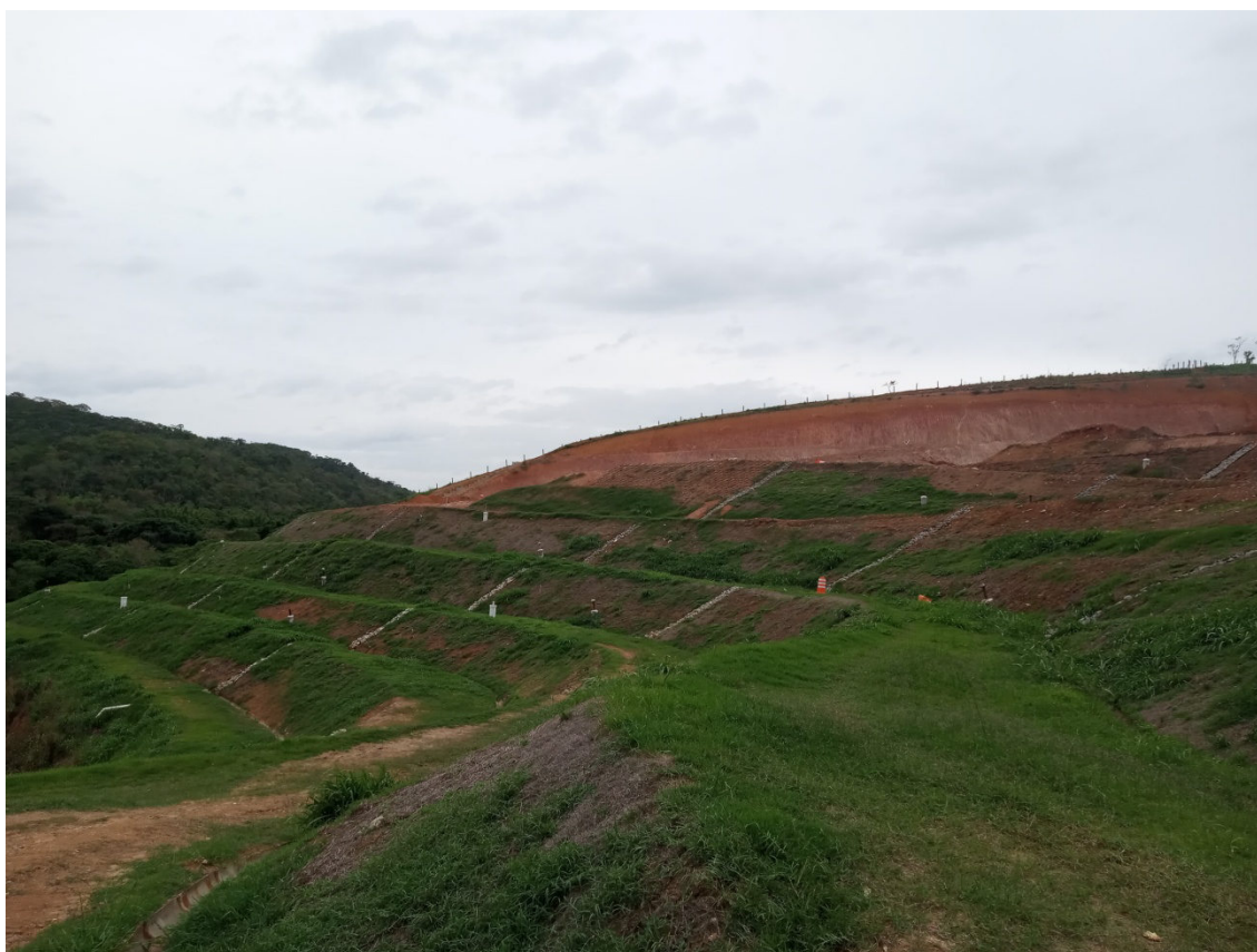
Figura 11: Cobertura vegetal do talude
