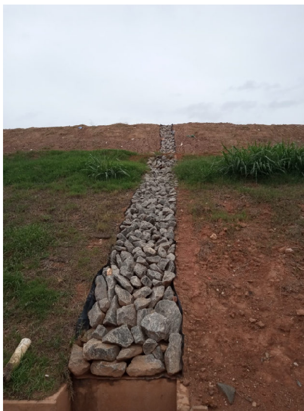
Figura 8: Detalhe do sistema de drenagem do talude
