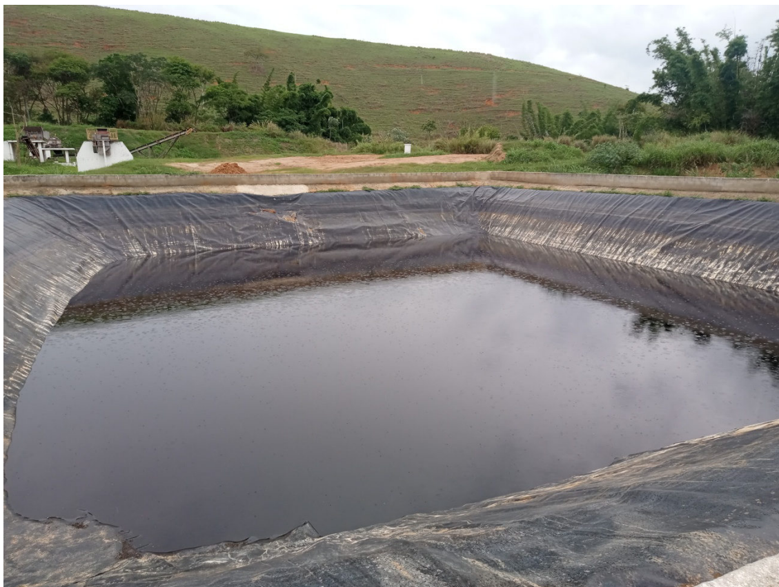
Figura 13: Lagoa de armazenamento de chorume
