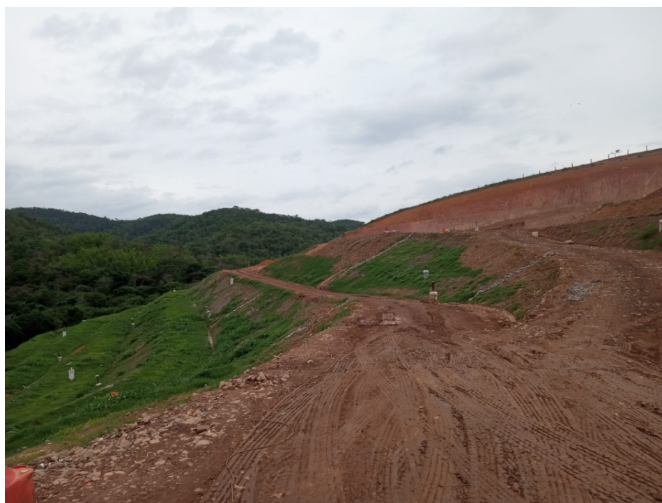
Figura 10: Cobertura vegetal do talude
