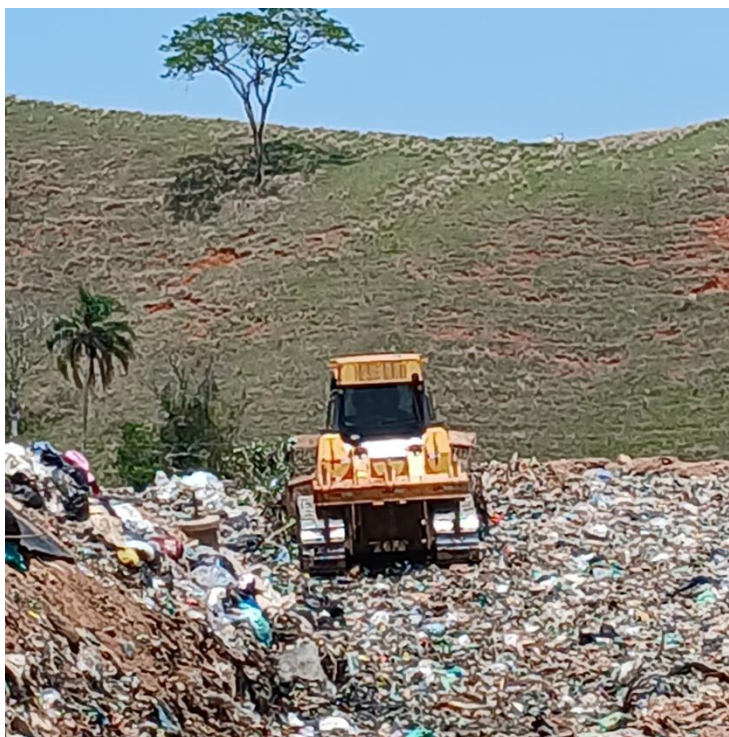
Figura 10: Expansão da célula B – Frente de trabalho
