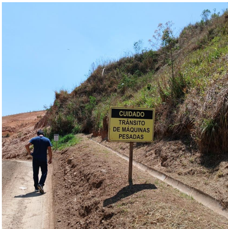
Figura 6 : Estrada de Acesso à frente de trabalho
