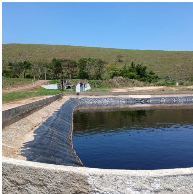
Figura 16: Lagoa de armazenamento de chorume
