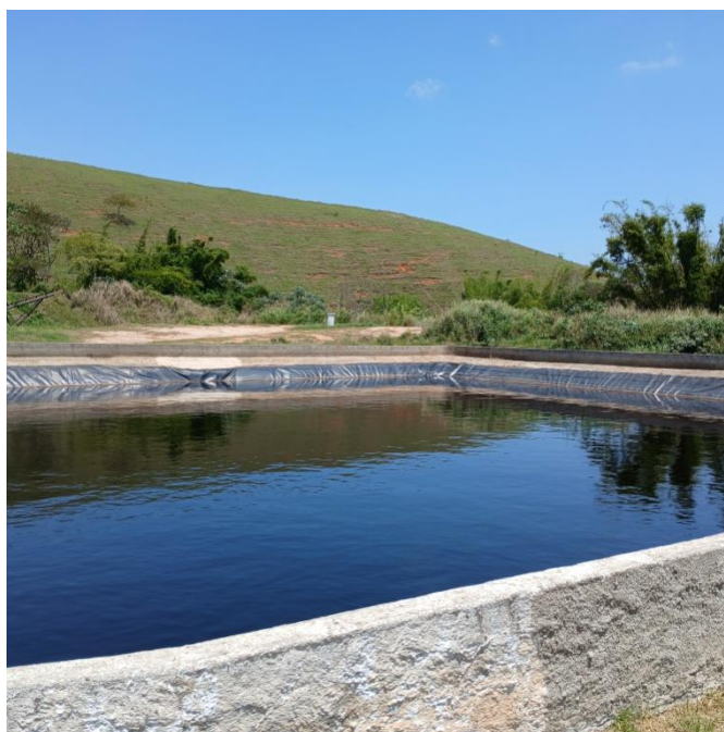
Figura 15: Lagoa de armazenamento de chorume
