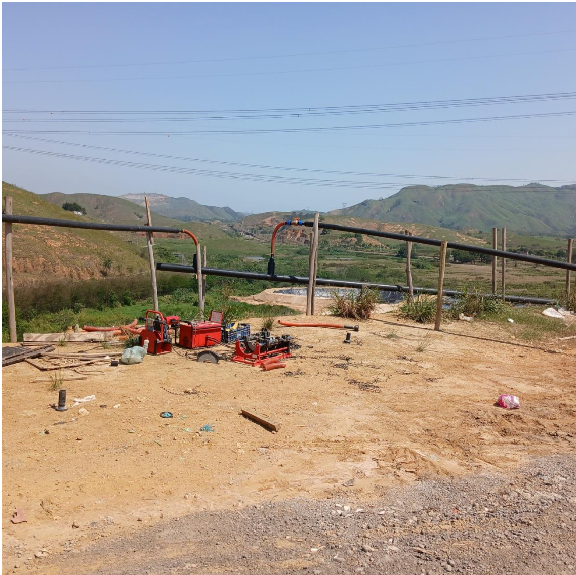
Figura 14: Manutenção e ampliação dos dutos de captação de gás
