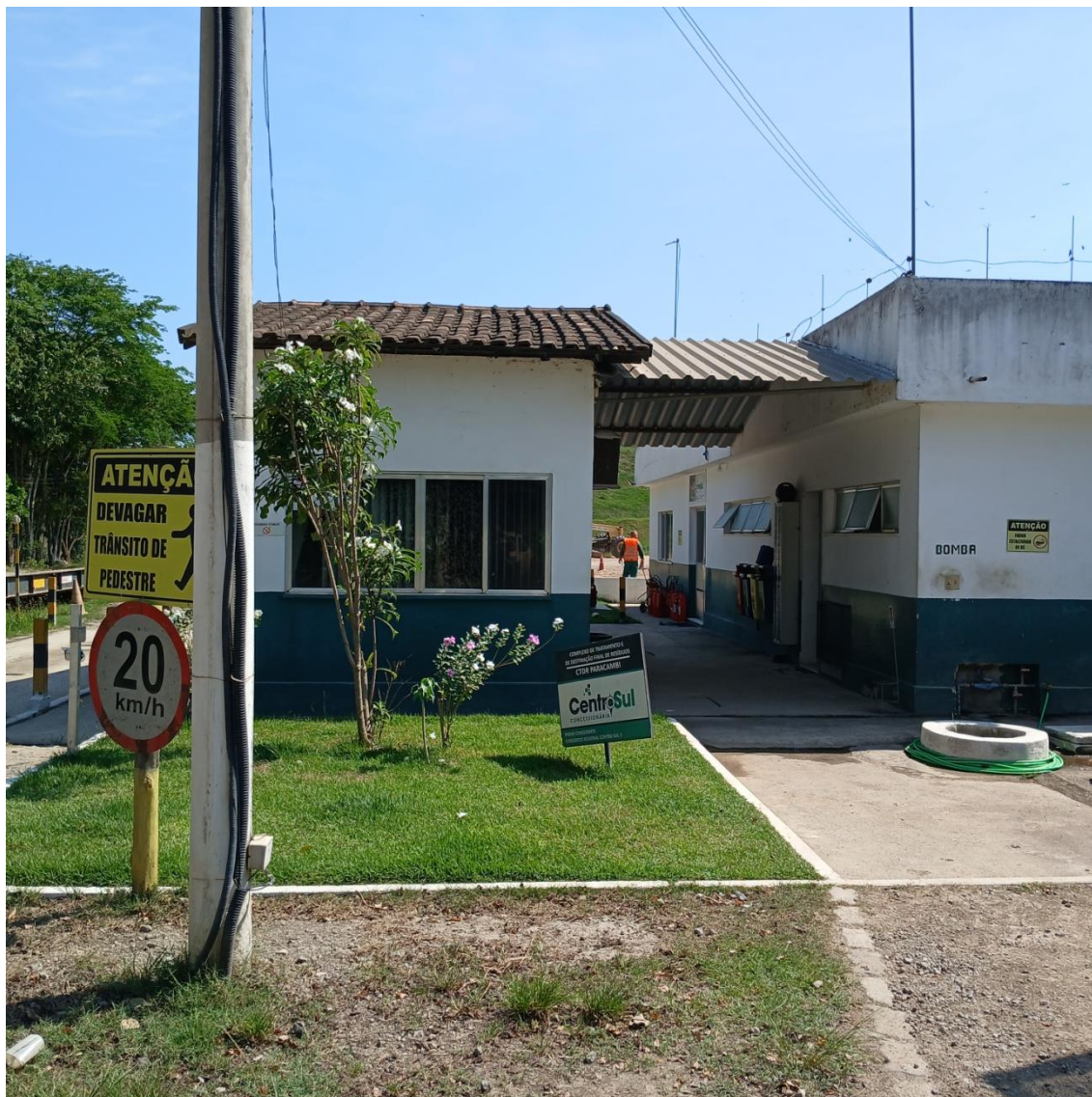
Figura 3: Sala de comando de pesagem
