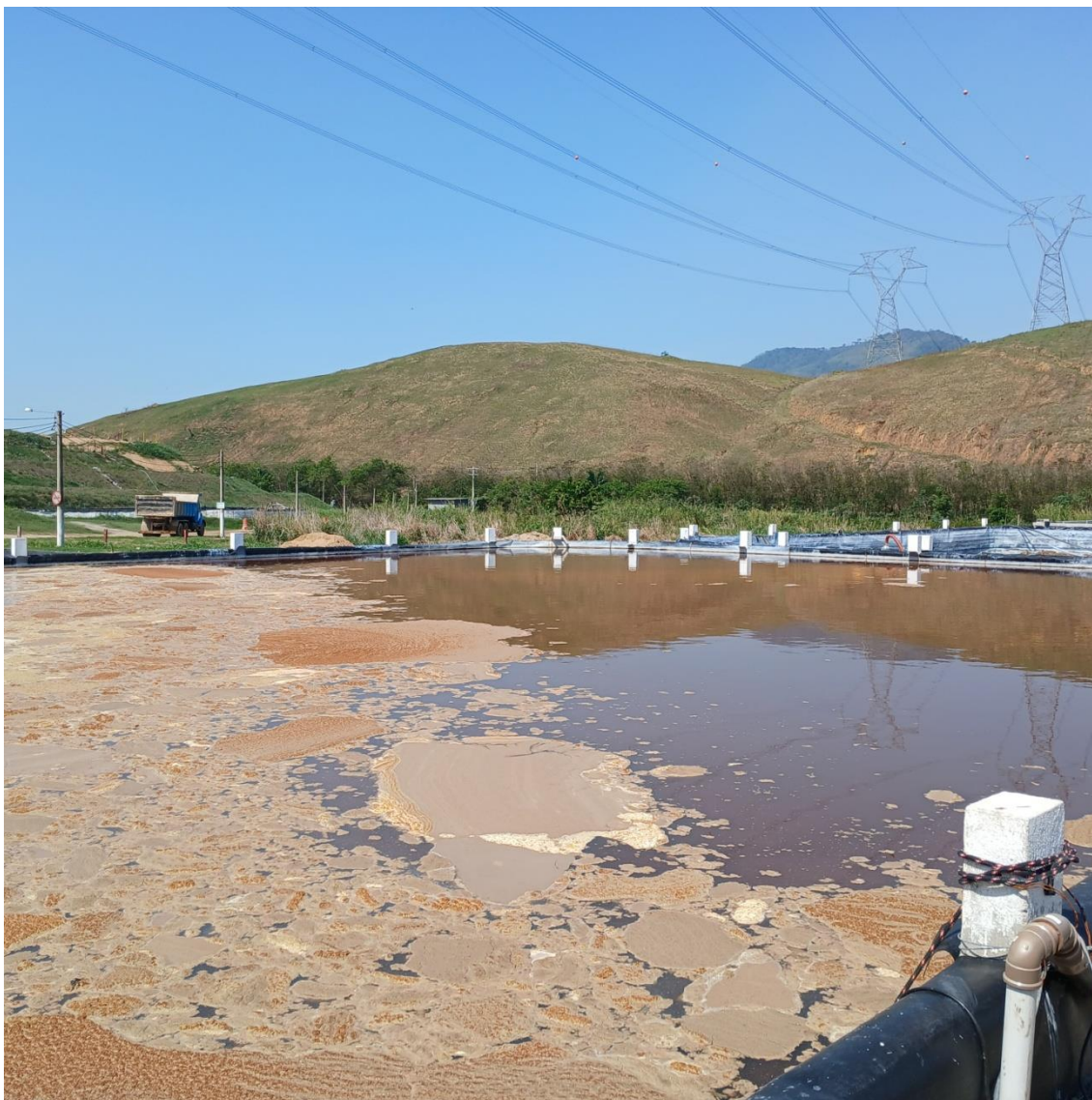
Figura 19: Lagoa secundária de recebimento de chorume
