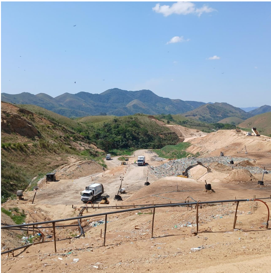
Figura 11: Frente de trabalho , no detalhe as tubulações de captação de gás.
