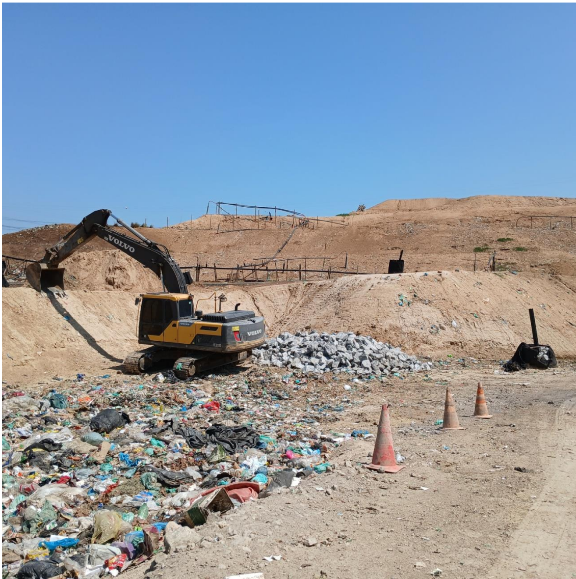
Figura 9: Frente de Trabalho – Ao fundo dutos de captação de gás.
