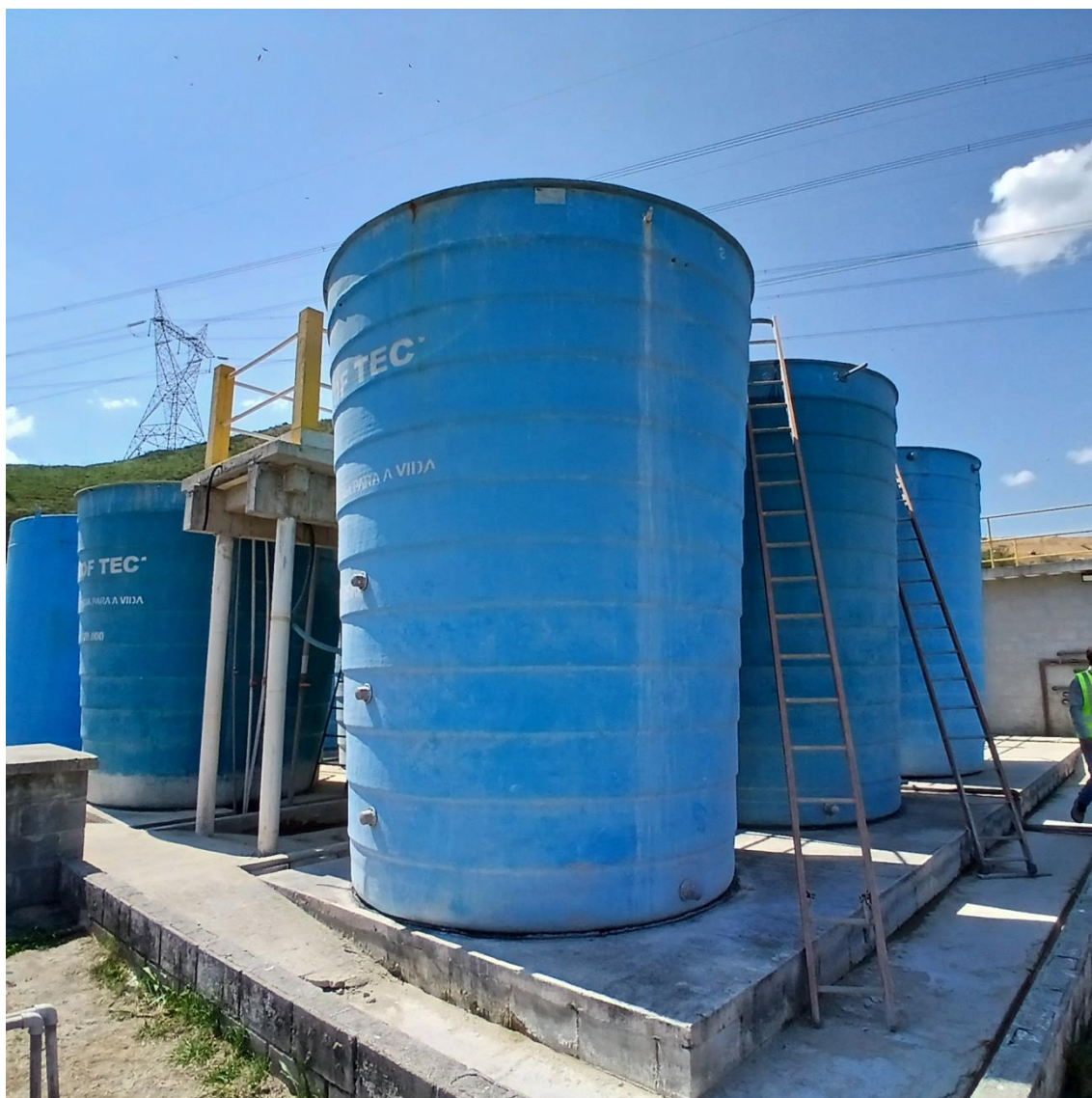
Figura 25: Tanques da Estação de tratamento
