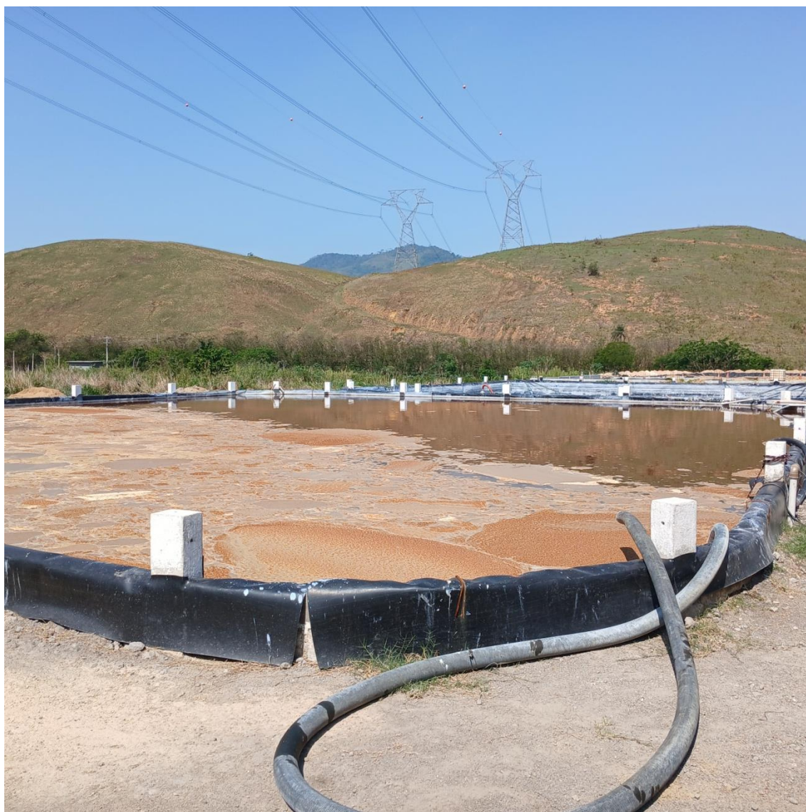
Figura 18: Lagoa secundária de recebimento de chorume
