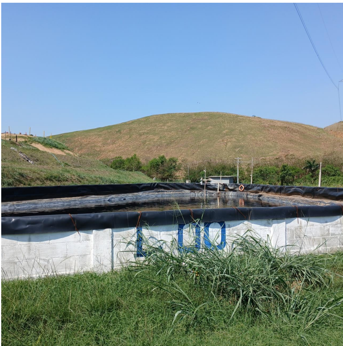
Figura 17: Lagoa primária de recebimento de chorume
