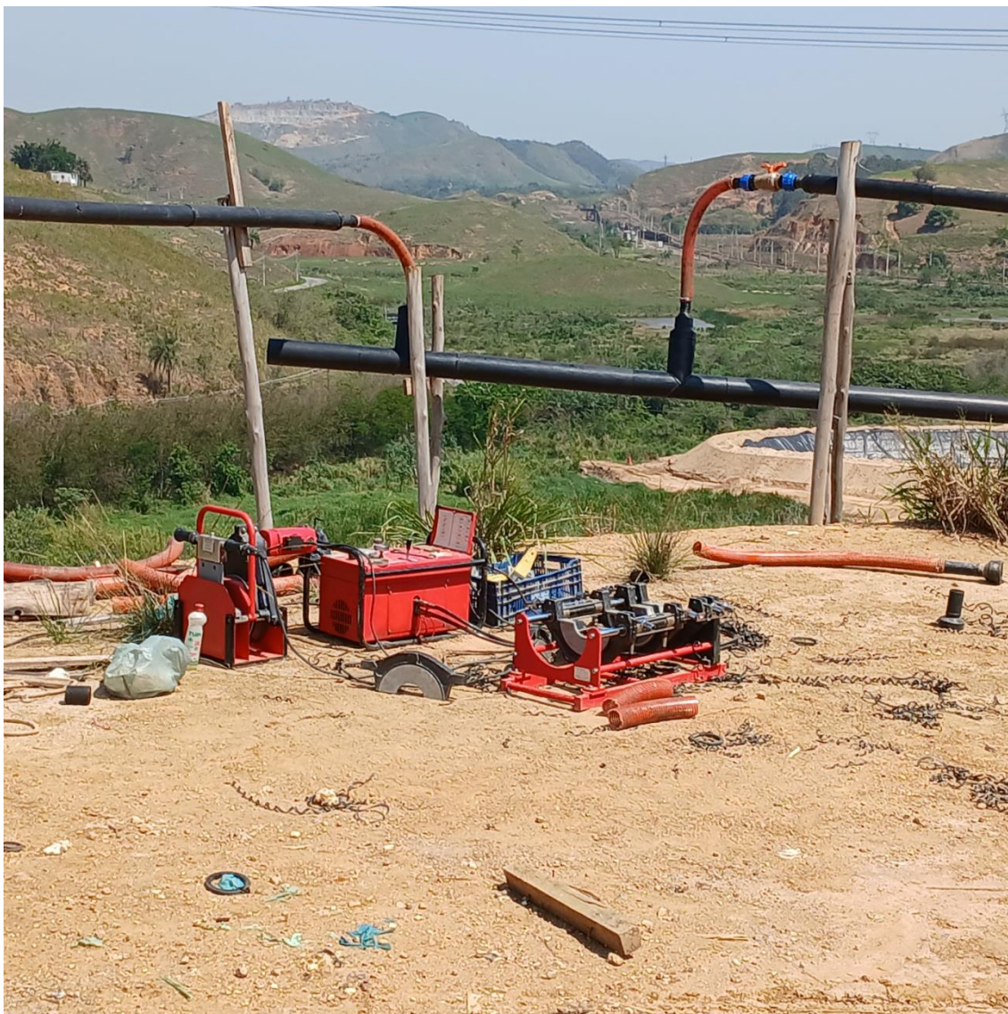
Figura 13: Manutenção e ampliação dos dutos de captação de gás
