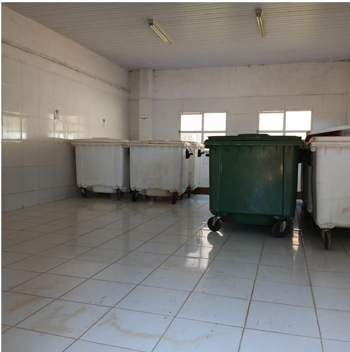
Figura 21: Abrigo temporário de RSS. Onde os resíduos são estocados até serem coletados pela empresa contratada para realizar a autoclavagem
