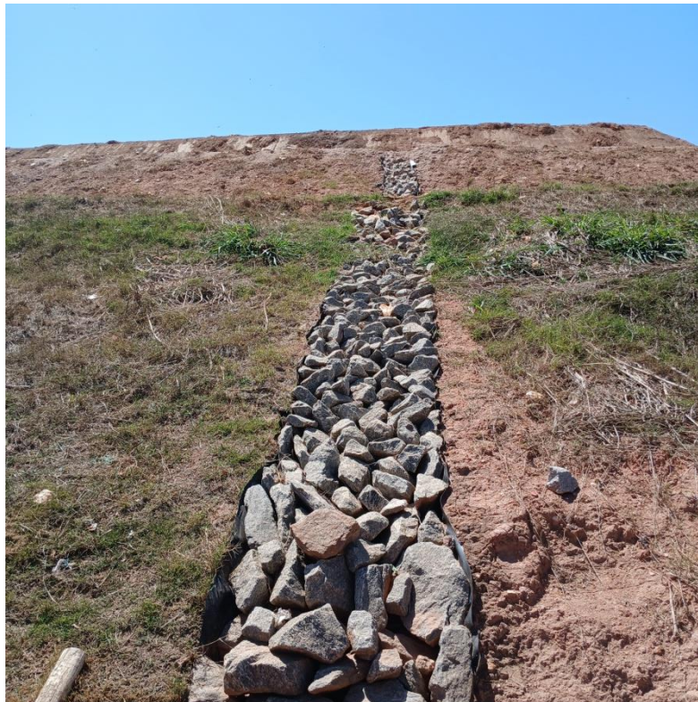
Figura 13: Sistema de drenagem
