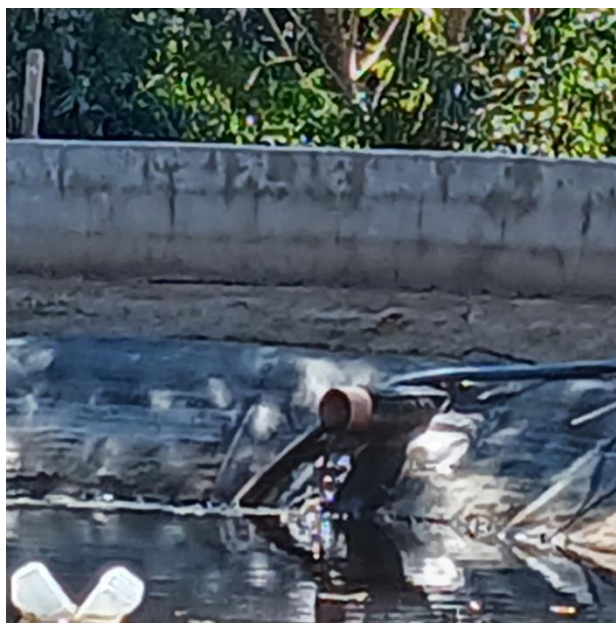
Figura 18: Lagoa de armazenamento de chorume
