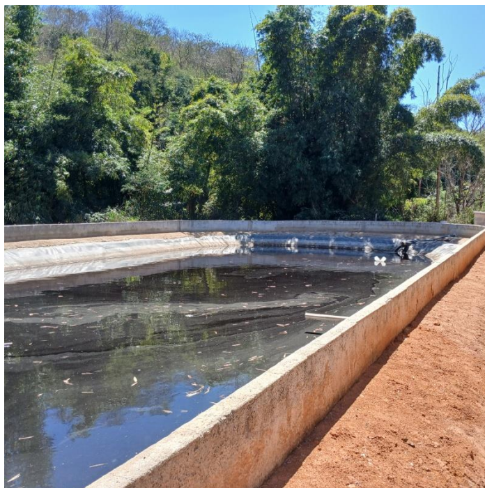
Figura 17: Lagoa de armazenamento de chorume
