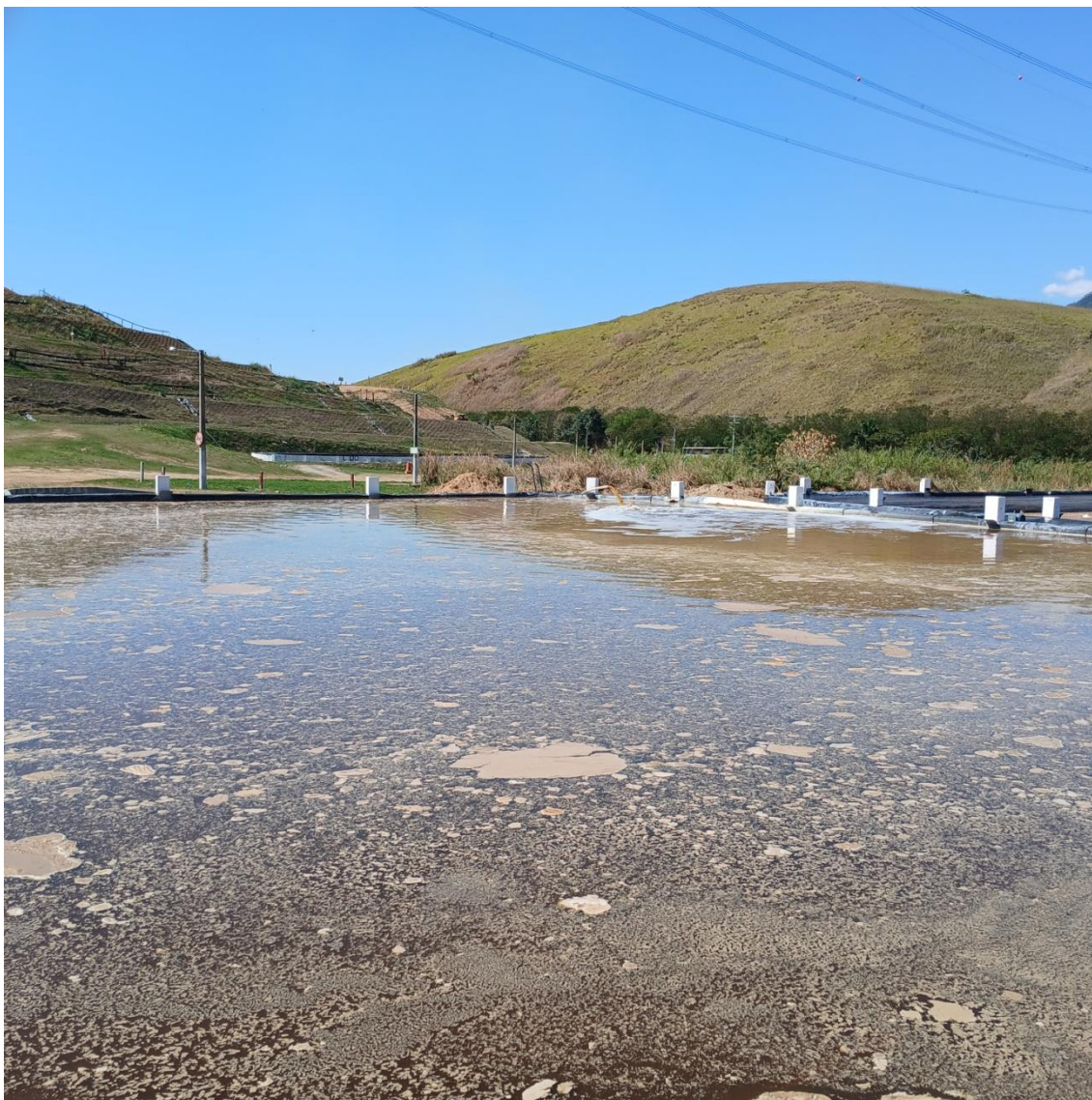
Figura 11: Lagoa secundária de recebimento de chorume
