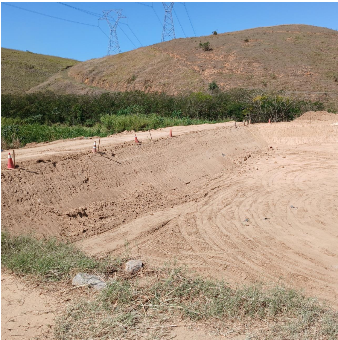
Figura 20: Novas lagoas de recebimento de chorume sendo preparadas
