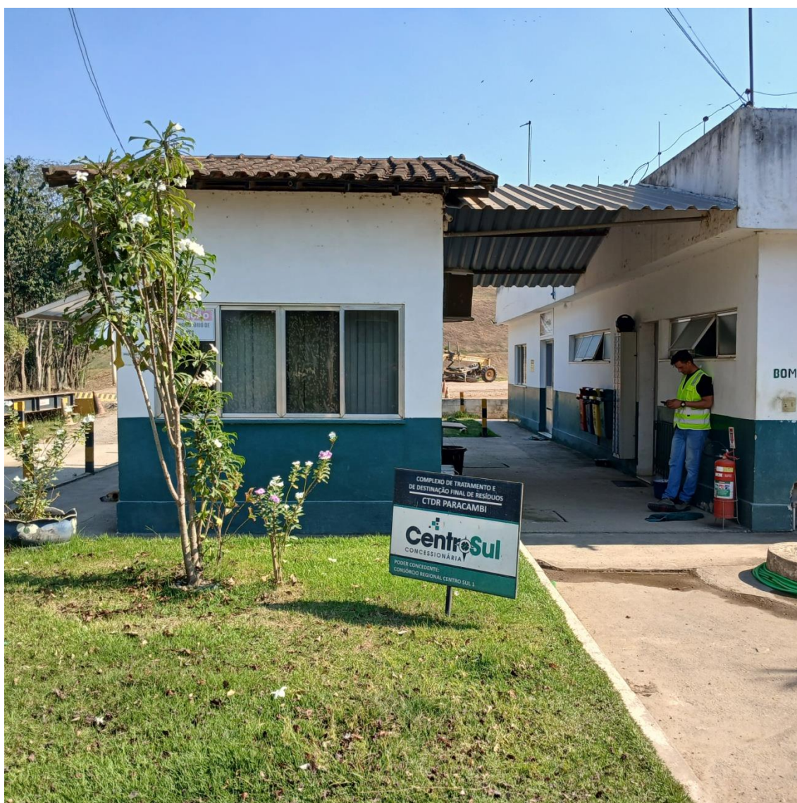
Figura 2: Sala de comando de pesagem
