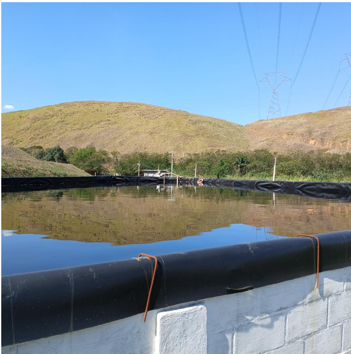
Figura 10: Lagoa principal de recebimento de chorume
