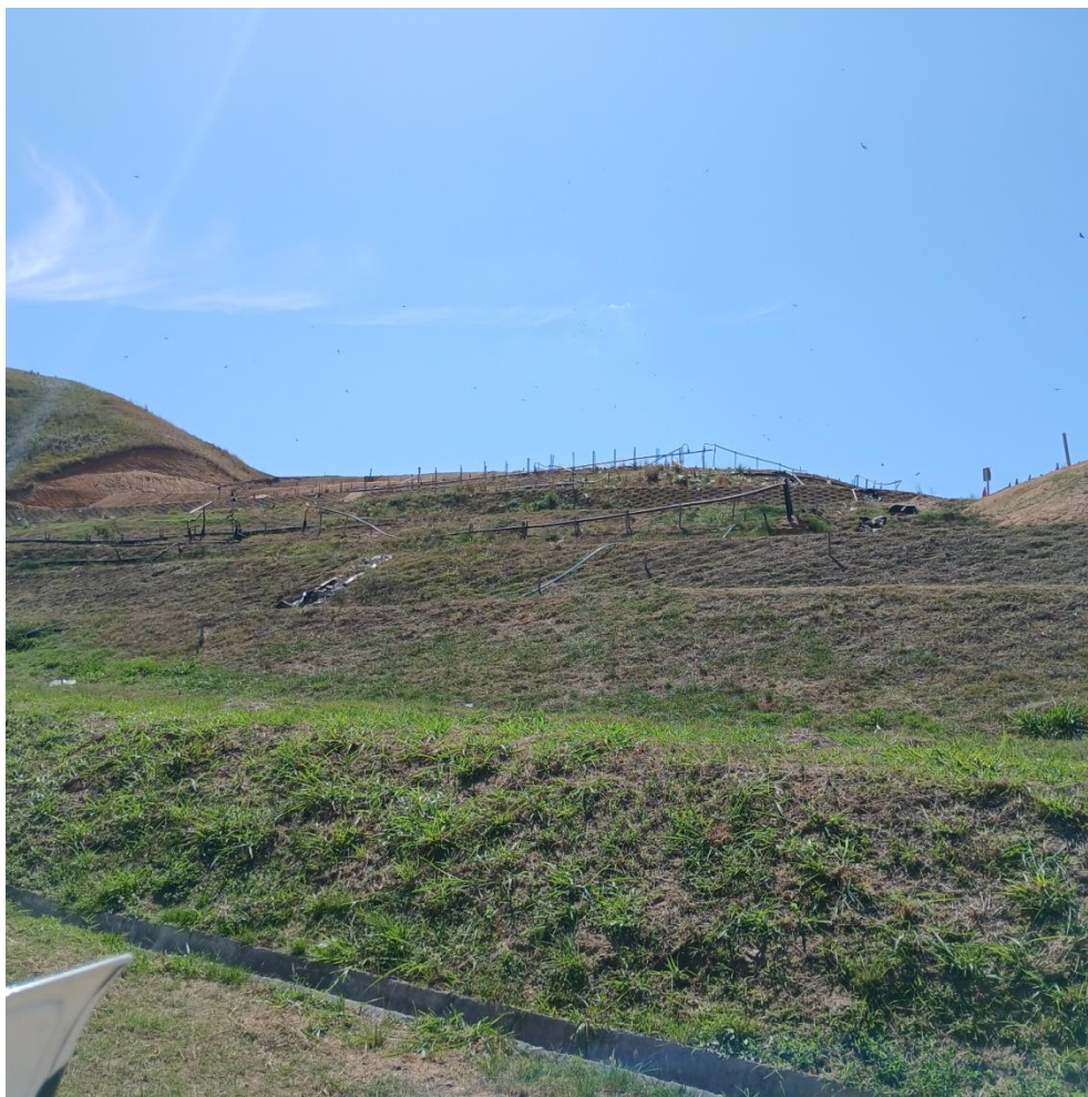
Figura 8: Dutos de captação de gás e cobertura vegetal do maciço
