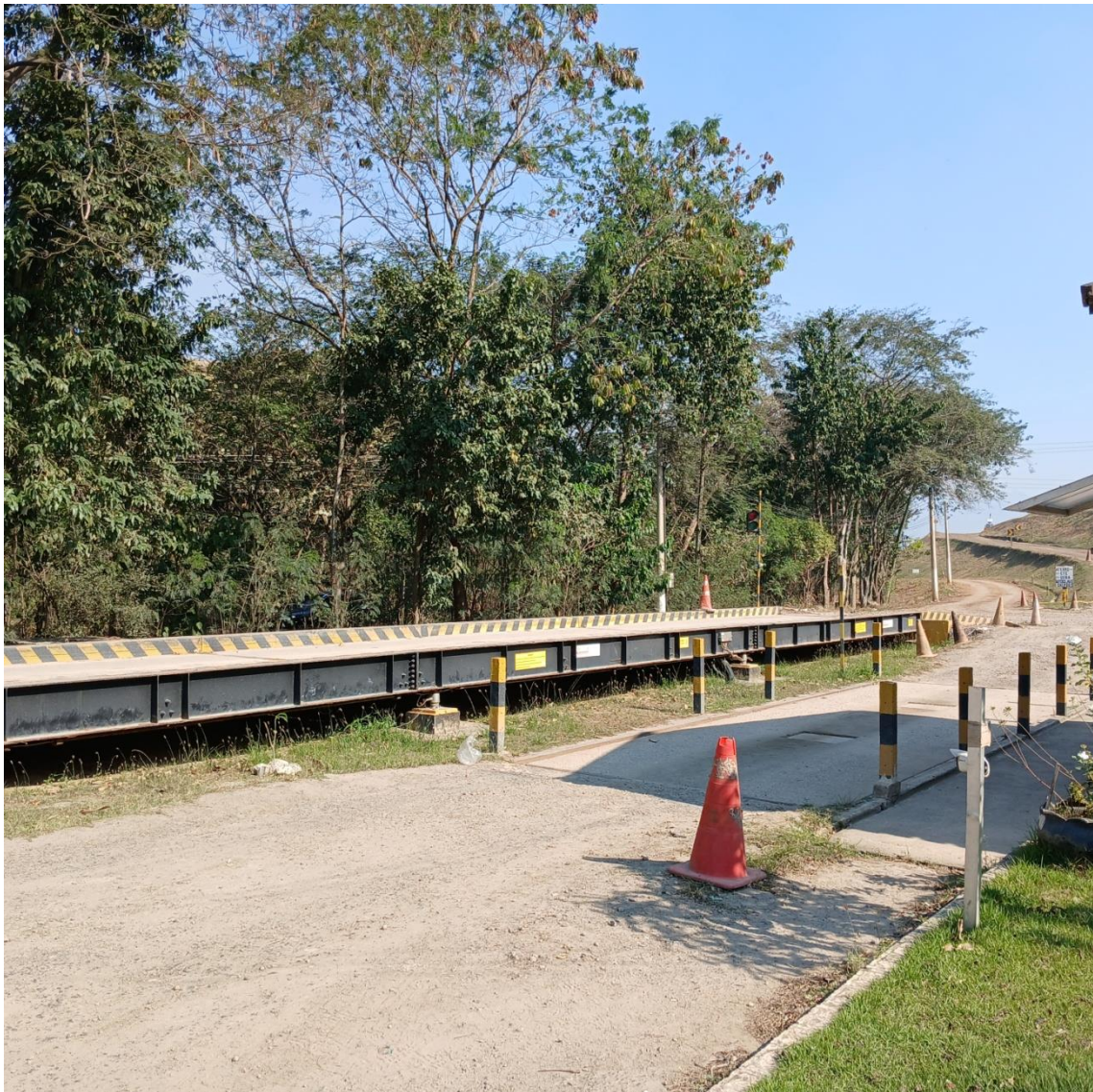
Figura 3: Vista das Balanças de pesagem
