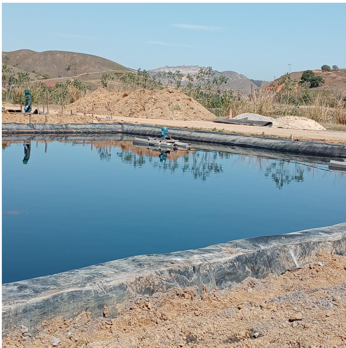
Figura 12: Lagoa secundária de recebimento de chorume
