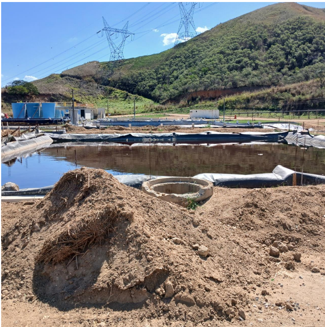
Figura 21: Novas lagoas de recebimento de chorume sendo preparadas
