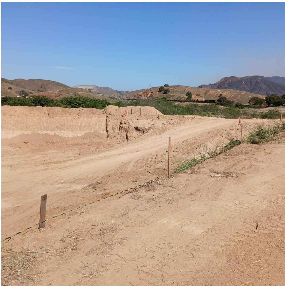
Figura 19: Novas lagoas de recebimento de chorume sendo preparadas
