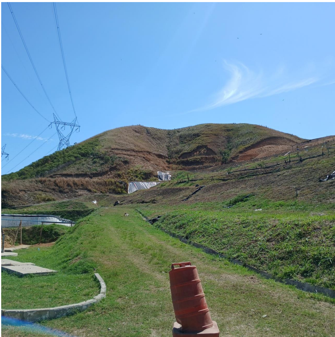
Figura 9: Dutos de captação de gás e cobertura vegetal do maciço
