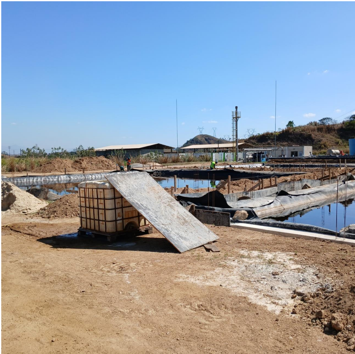
Figura 22: Novas lagoas de recebimento de chorume sendo preparadas
