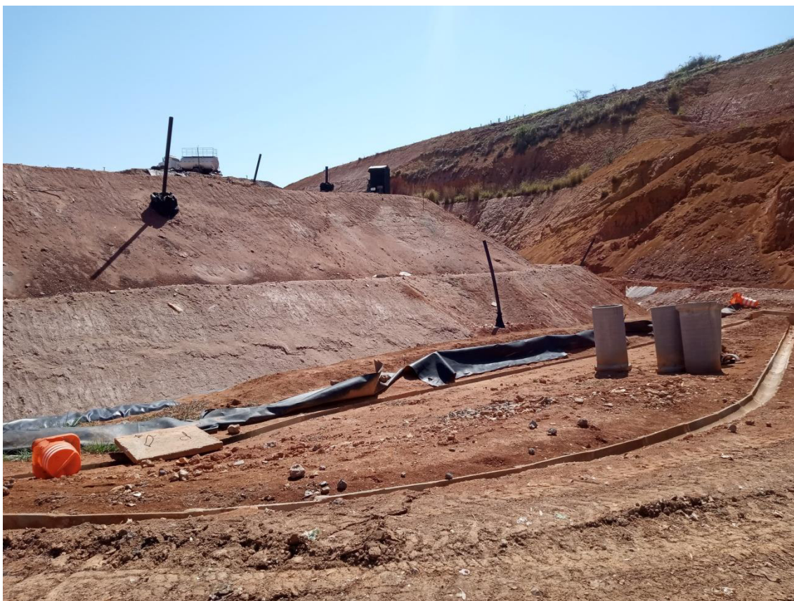
Figura 3: Preparação da nova célula e ao fundo a frente de trabalho
