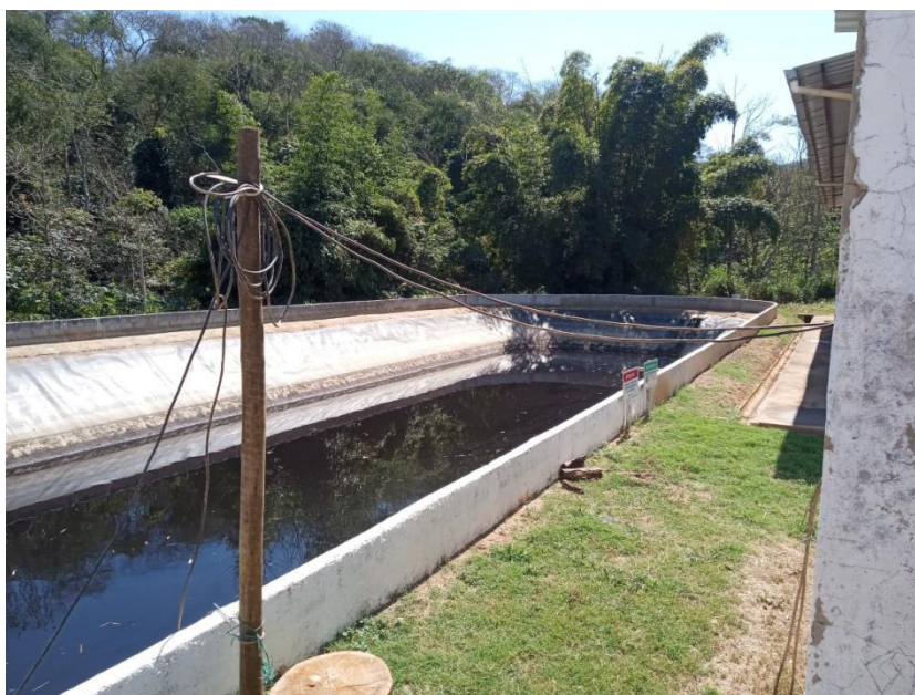
Figura 11: Lagoa de recebimento e armazenagem de chorume
