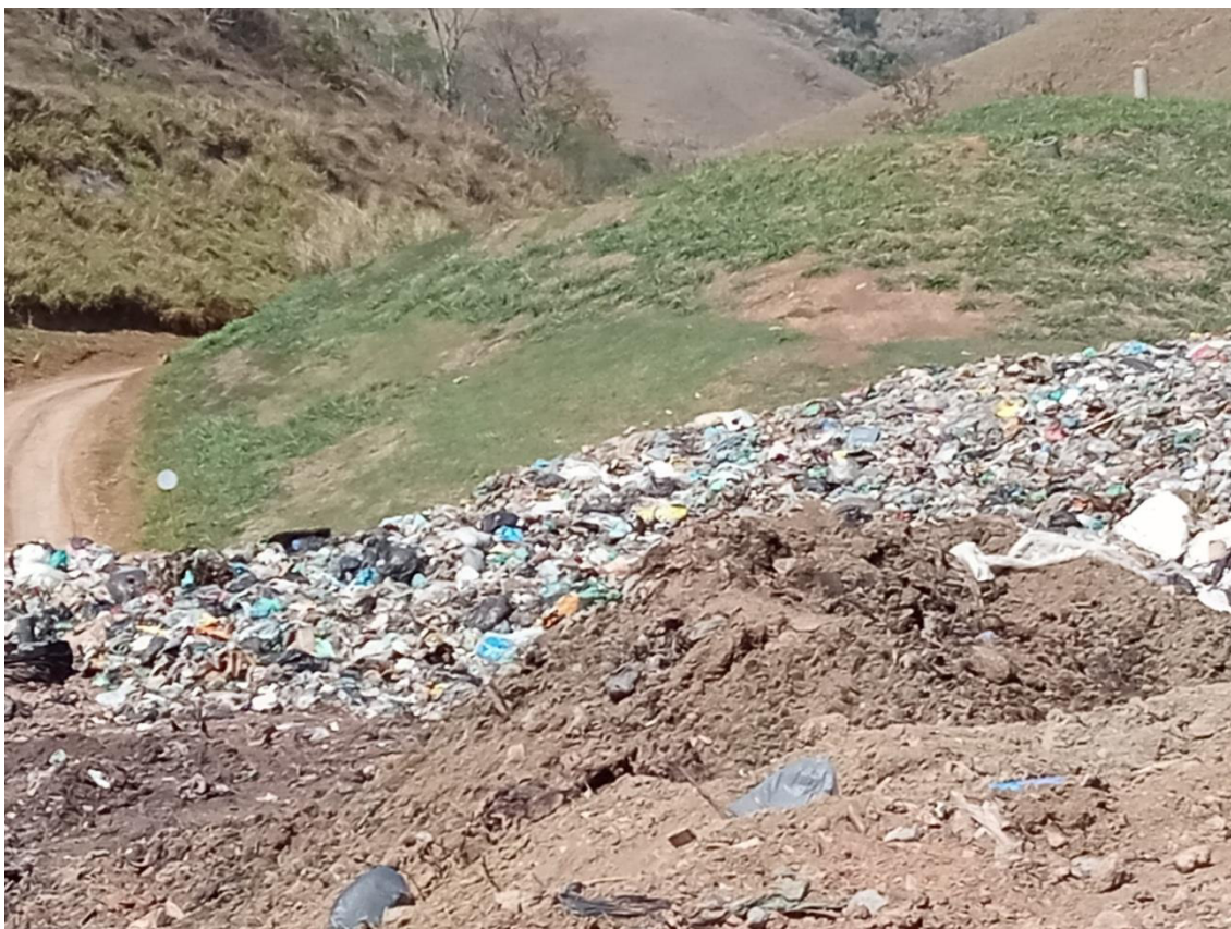
Figura 7: Frente de trabalho (No detalhe , o resíduo sendo coberto com o sedimento )
