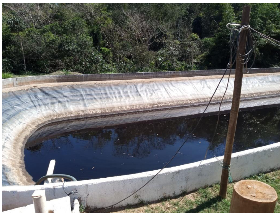
Figura 12: Lagoa de recebimento e armazenagem de chorume
