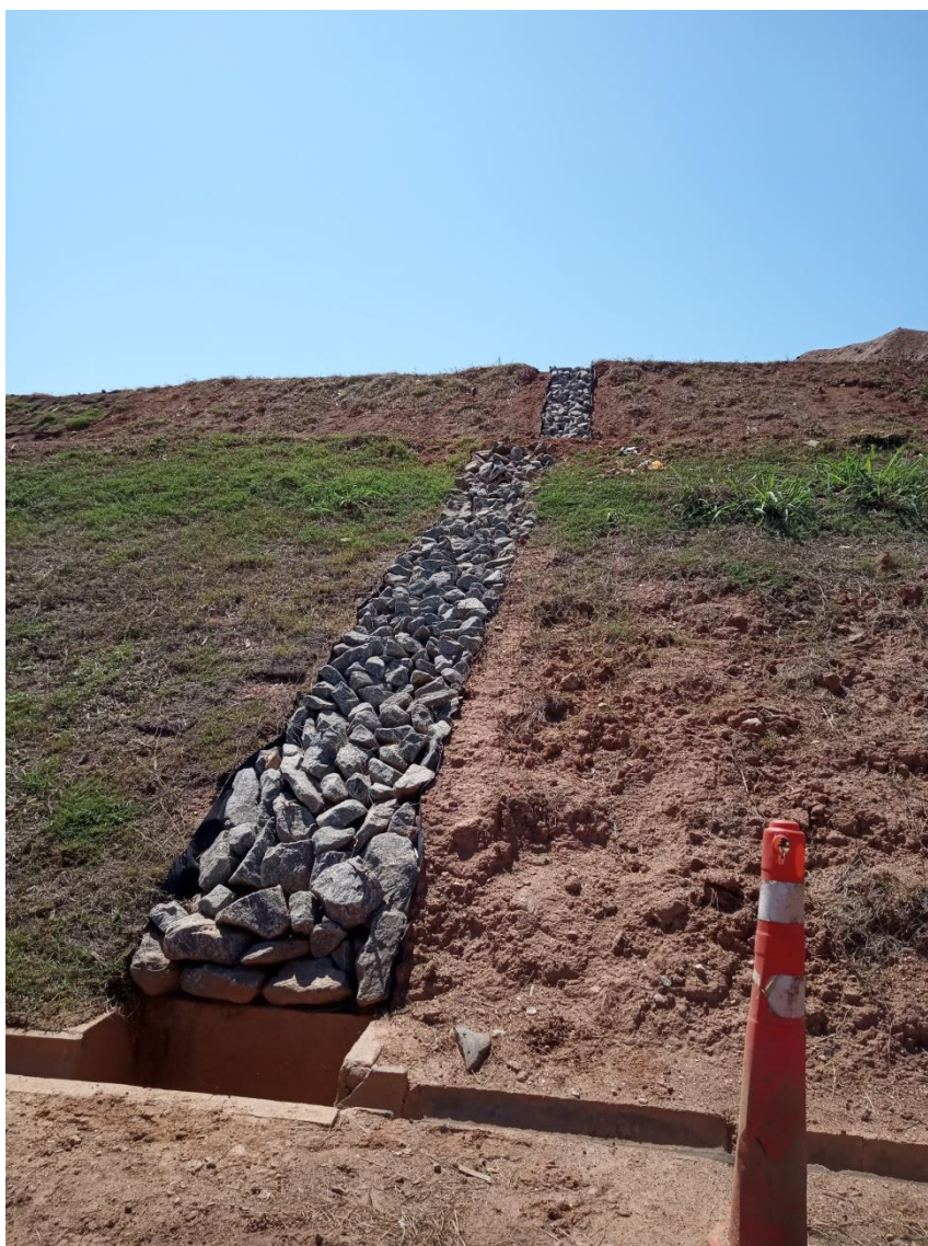
Figura 8: Detalhe do sistema de drenagem do talude
