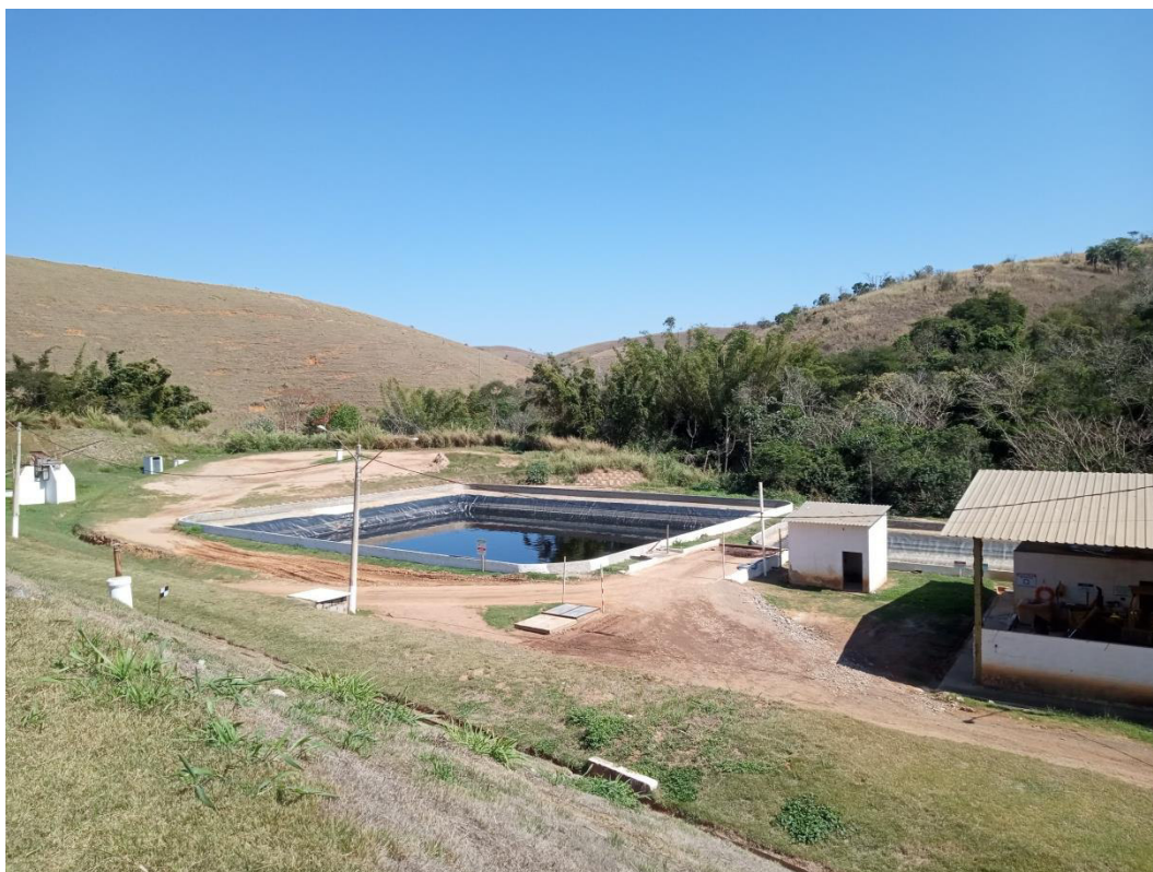
Figura 10: Vista das lagoas de acumulação de chorume
