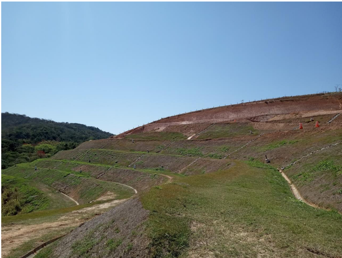
Figura 9: Cobertura vegetal do talude
