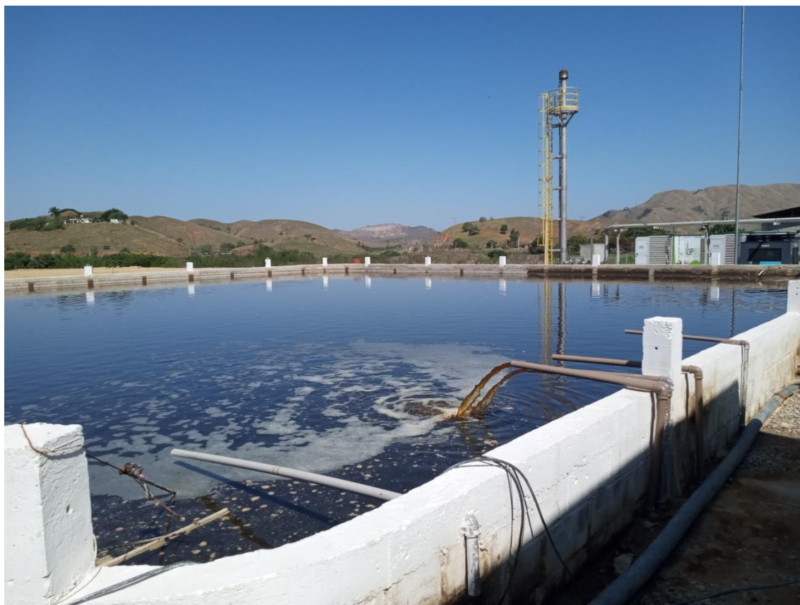
Figura12: Lagoa de recebimento de chorume
