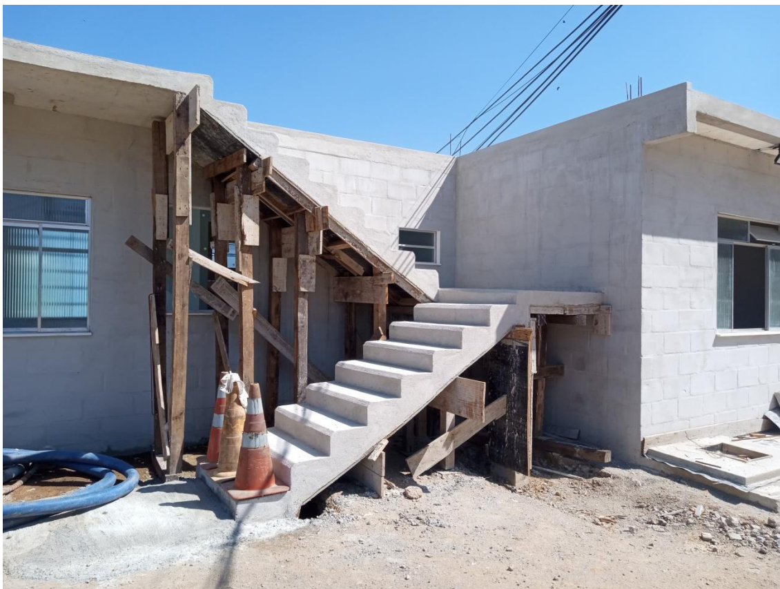
Figura 14: Construção do abrigo de processamento de osmose reversa e laboratório de análise do lixiviado em fase de acabamento .
