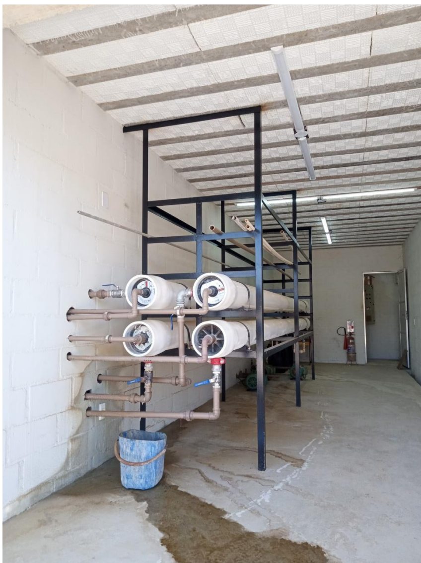
Figura 15: Novo local construído em alvenaria para a instalação e abrigo do equipamento de osmose reversa. Equipamento em operação.
