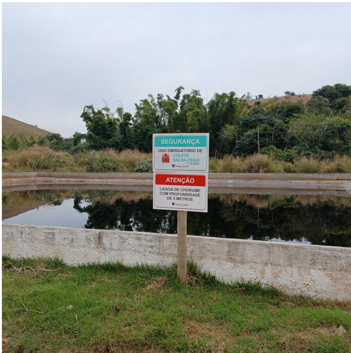
Figura 22: Lagoa de armazenamento de chorume (Sinalização)
