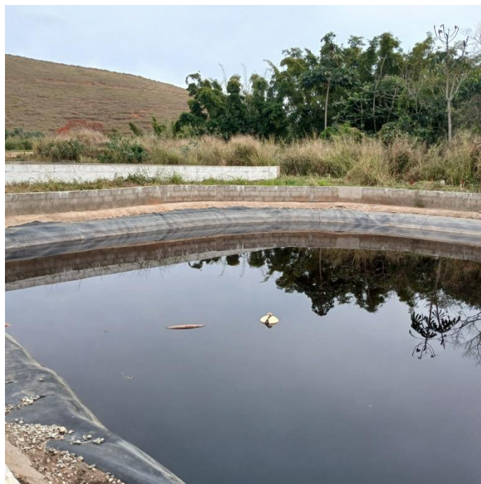
Figura 20: Lagoa de armazenamento de chorume
