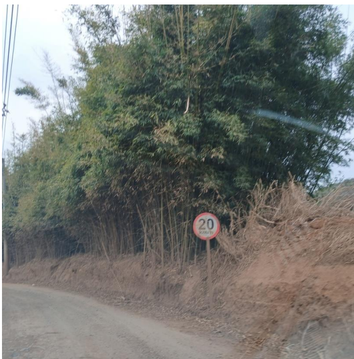
Figura 3: Sinalização ao longo da estrada de acesso ao CTDR em bom estado e visível
