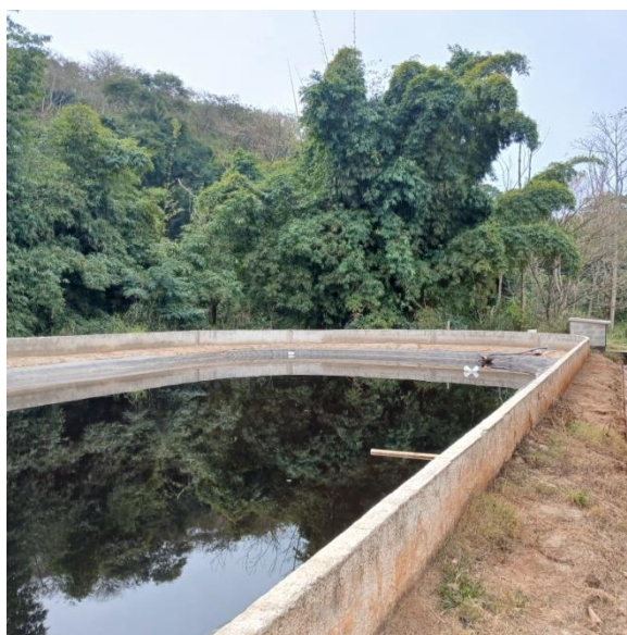
Figura 19: Lagoa de armazenamento de chorume
