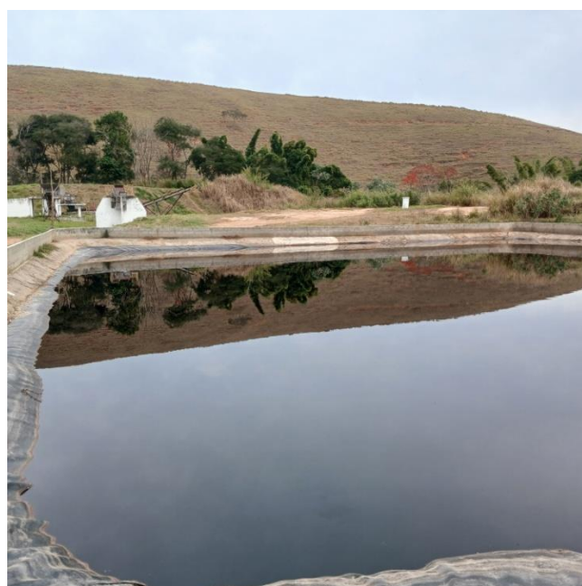
Figura 21: Lagoa de armazenamento de chorume
