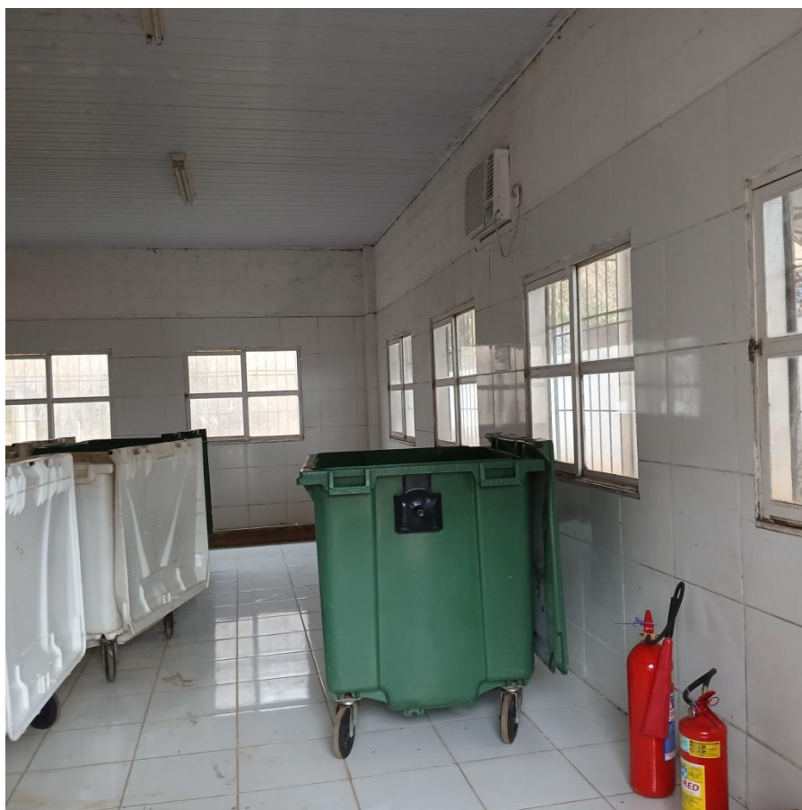
Figura 24: Abrigo temporário de RSS. Onde os resíduos são estocados até serem coletados pela empresa contratada para realizar a autoclavagem
