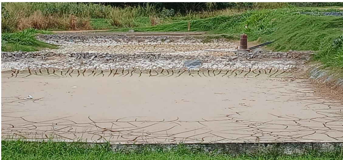
Figura 22: Leito de secagem do lodo
