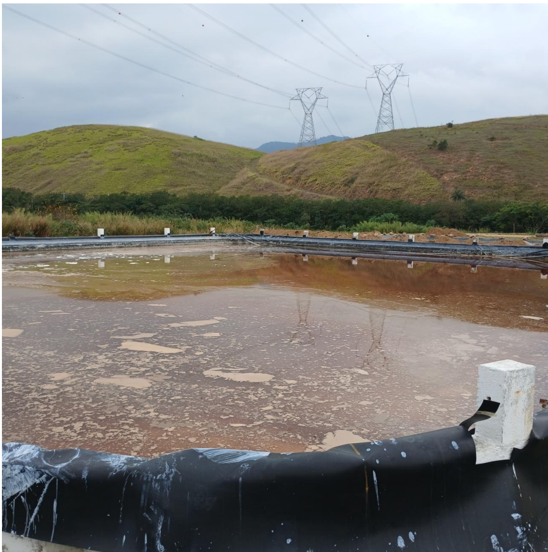
Figura 16: Lagoa secundária de recebimento de chorume
