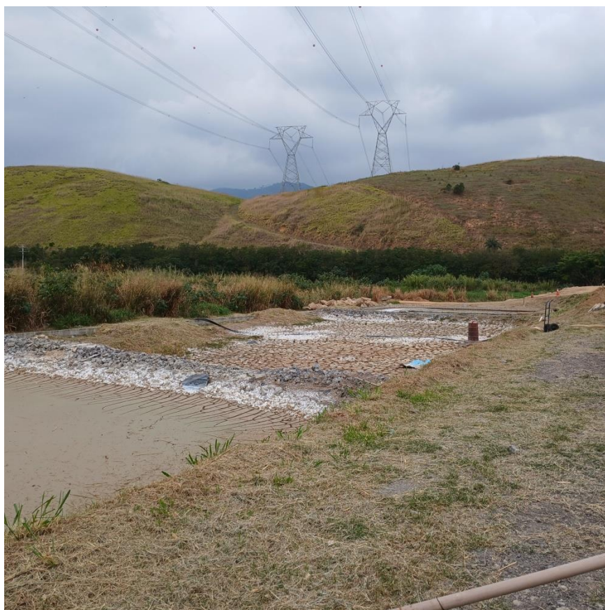
Figura 23: Leito de secagem do lodo
