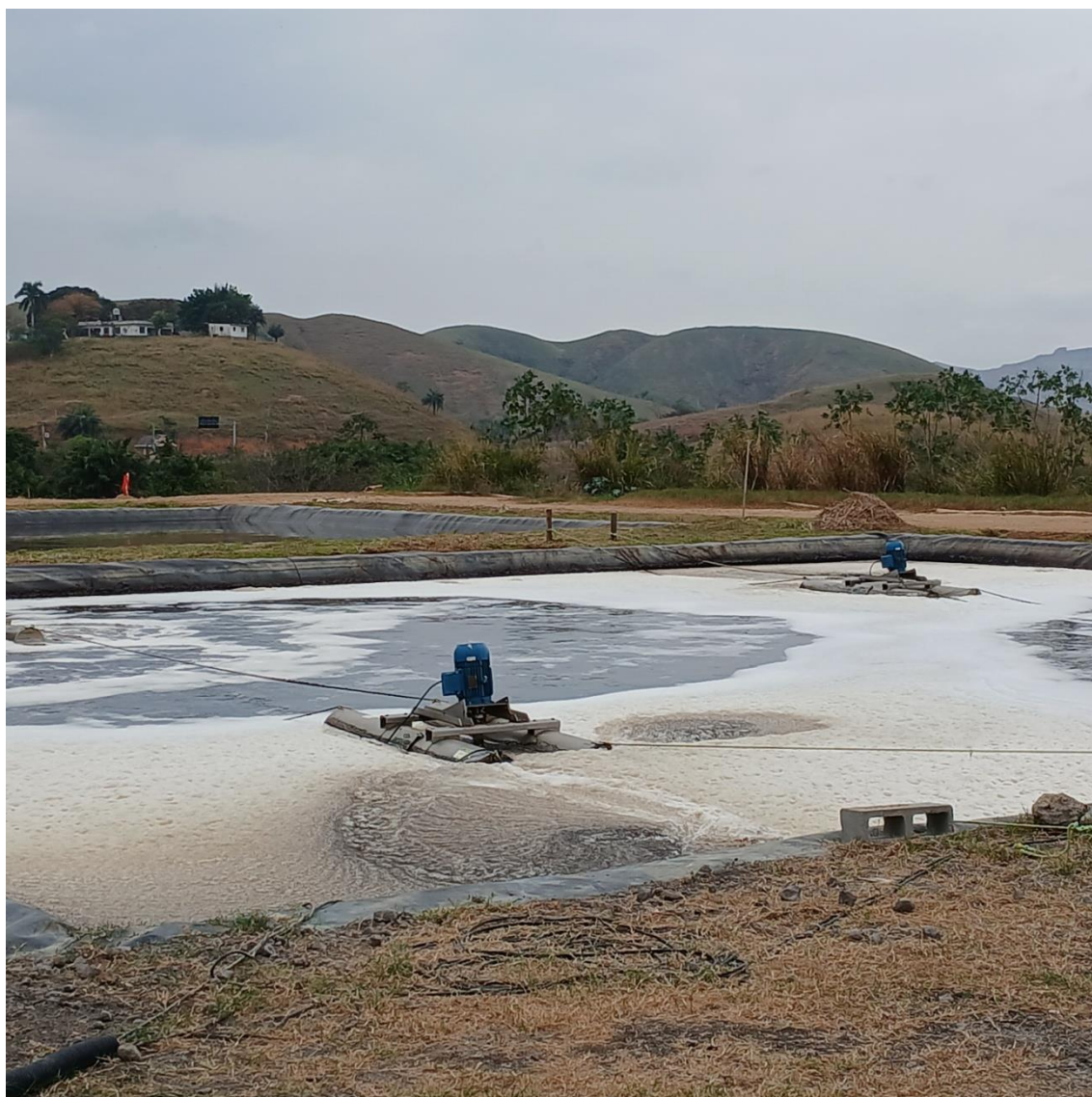
Figura 18: Lagoa secundária de recebimento de chorume com 4 aeradores
