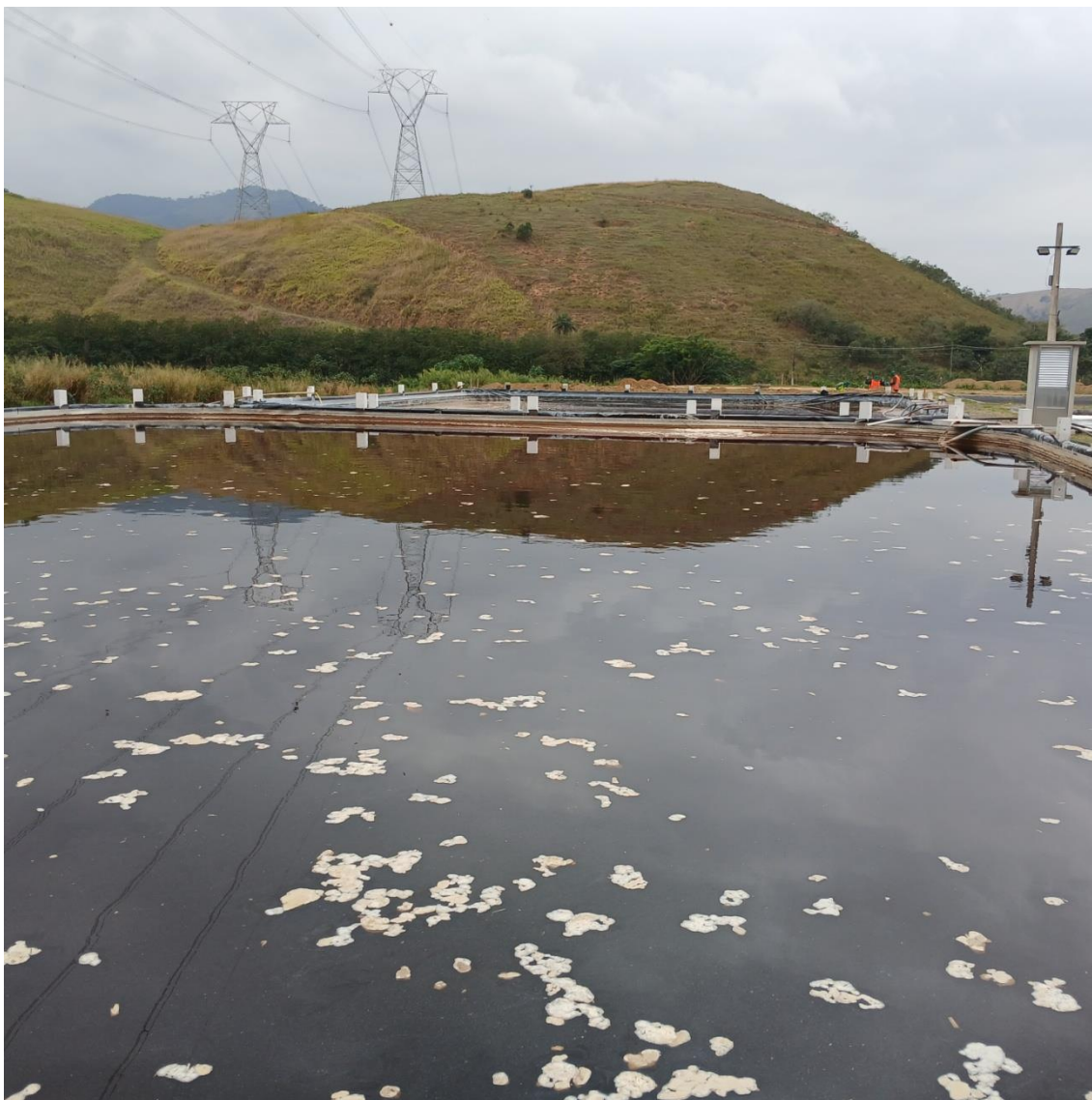
Figura 15: Lagoa secundária de recebimento de chorume
