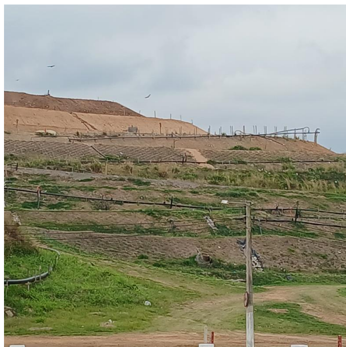
Figura 13: Dutos de captação de gás e cobertura vegetal do maciço
