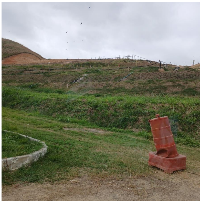
Figura 12: Dutos de captação de gás e cobertura vegetal do maciço.
