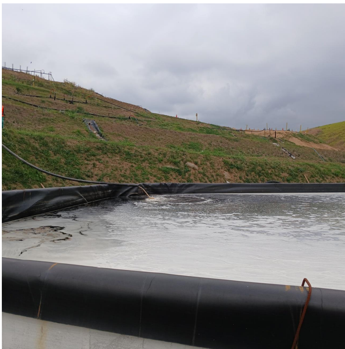
Figura 14: Lagoa principal de recebimento de chorume
