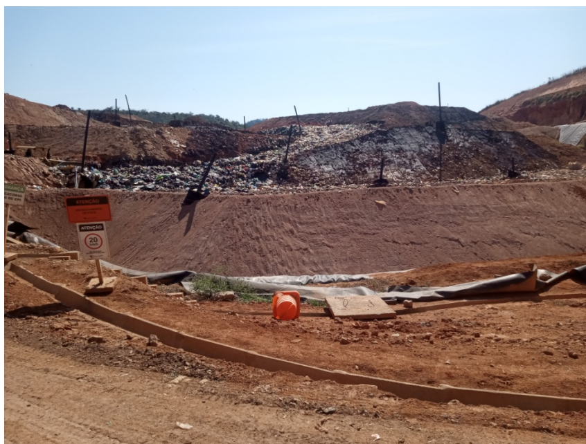
Figura 5: Preparação da nova célula e ao fundo a frente de trabalho
