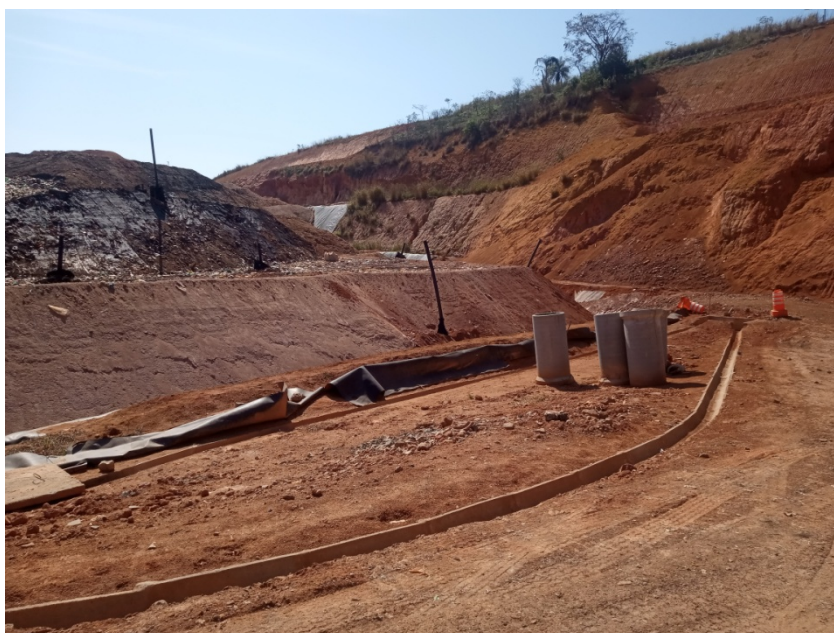
Figura 6: Preparação da nova célula . Detalhe da Geomembrana
