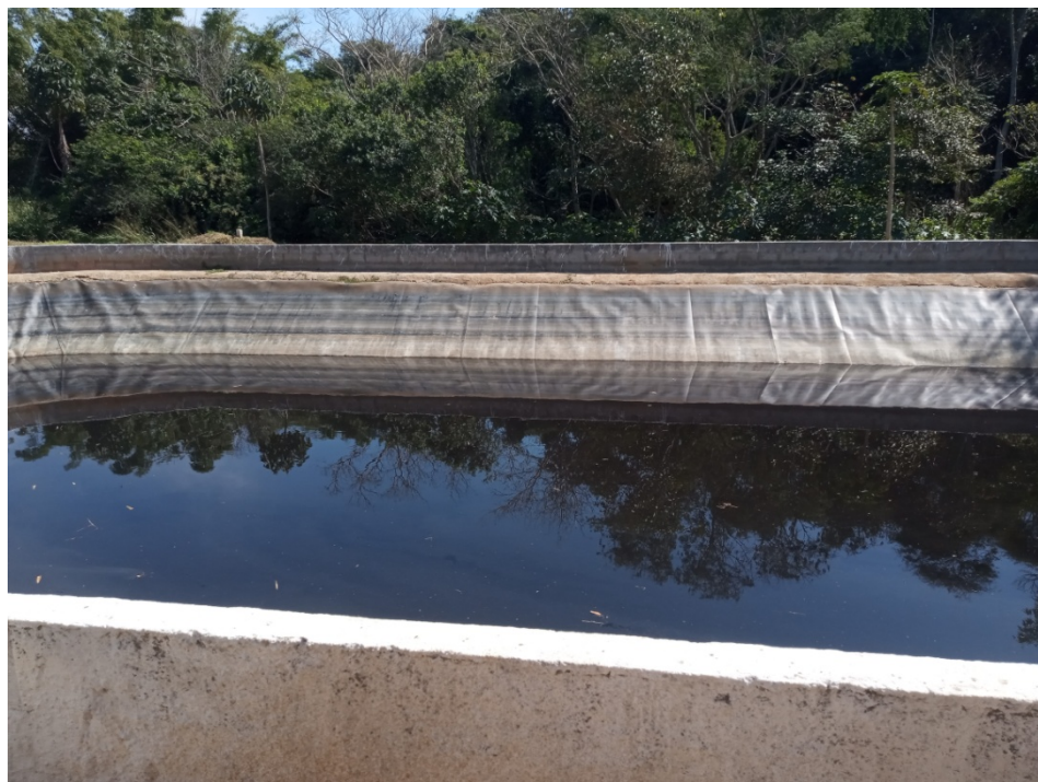
Figura16: Lagoa de recebimento e armazenagem de chorume
