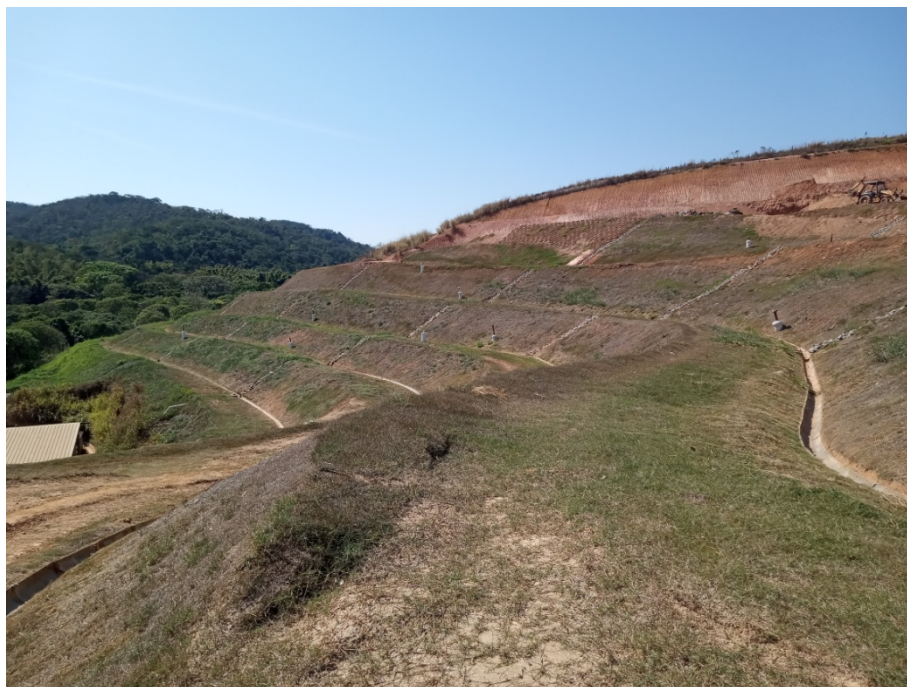
Figura13: Cobertura vegetal do talude
