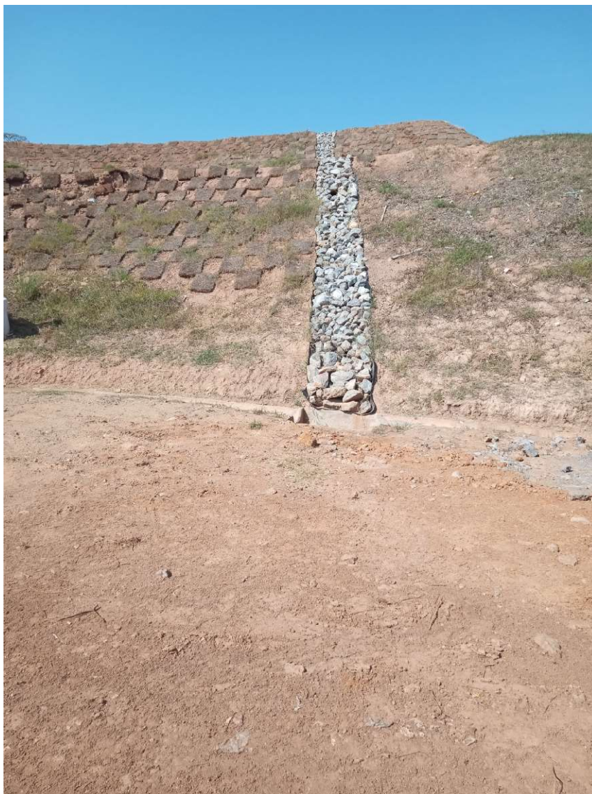
Figura 12: Cobertura vegetal do talude e drenagem
