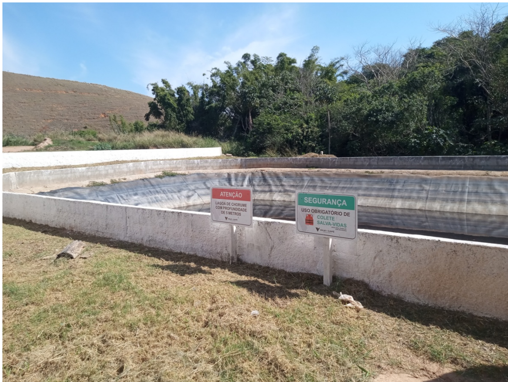
Figura 15: Lagoa de recebimento e armazenagem de chorume
