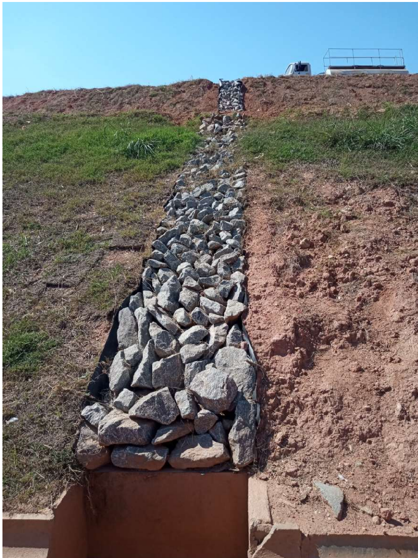
Figura 11: Detalhe do sistema de drenagem do talude
