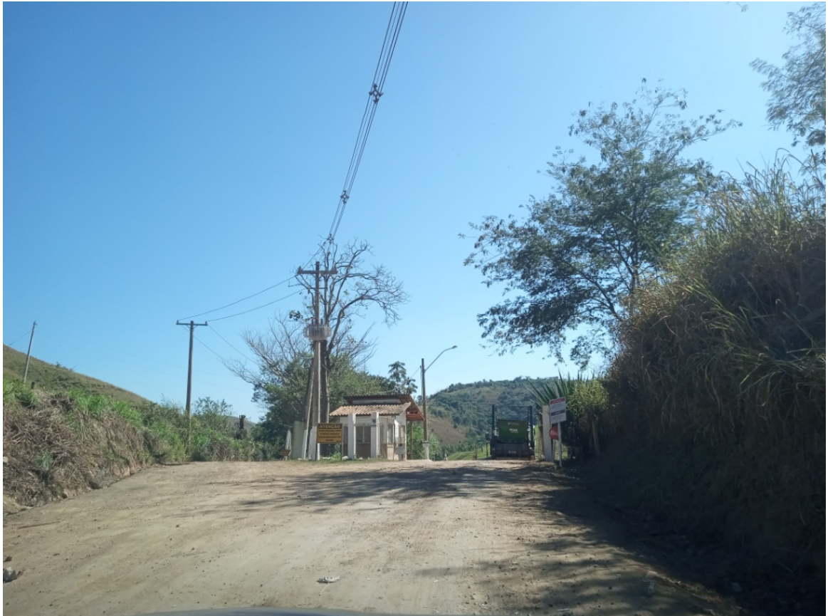
Figura 3: Vista do acesso ao CTDR
