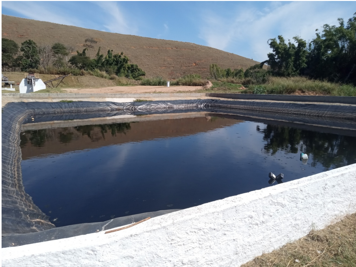
Figura17: Lagoa de recebimento e armazenagem de chorume
