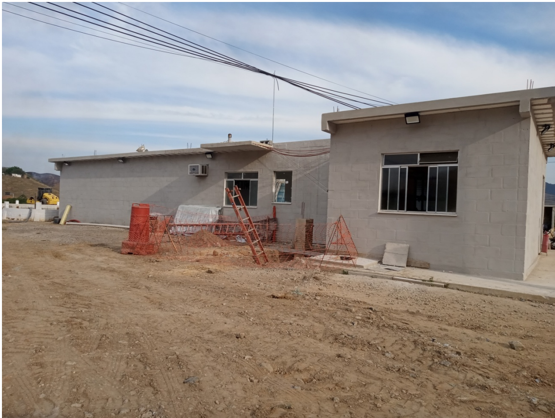
Figura 12: Construção do abrigo de processamento de osmose reversa e laboratório de análise do lixiviado em fase de acabamento .
