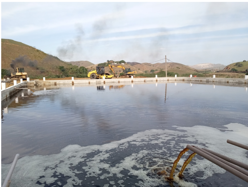
Figura 10: No detalhe, o fluxo de chorume . E ao fundo , obras de construção de novas lagoas de chorume
