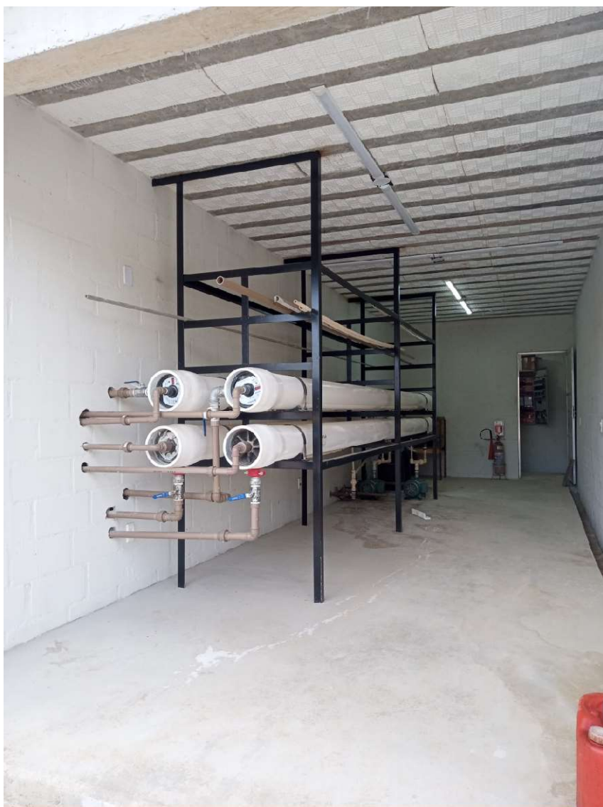
Figura 13: Novo local construído em alvenaria para a instalação e abrigo do equipamento de osmose reversa. Equipamento em operação.
