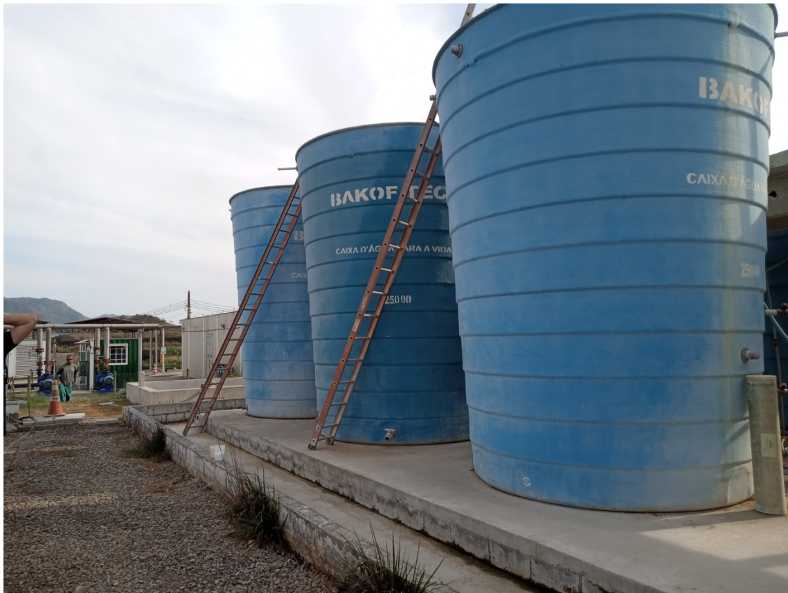
Figura 15 : Tanques da estação de tratamento
