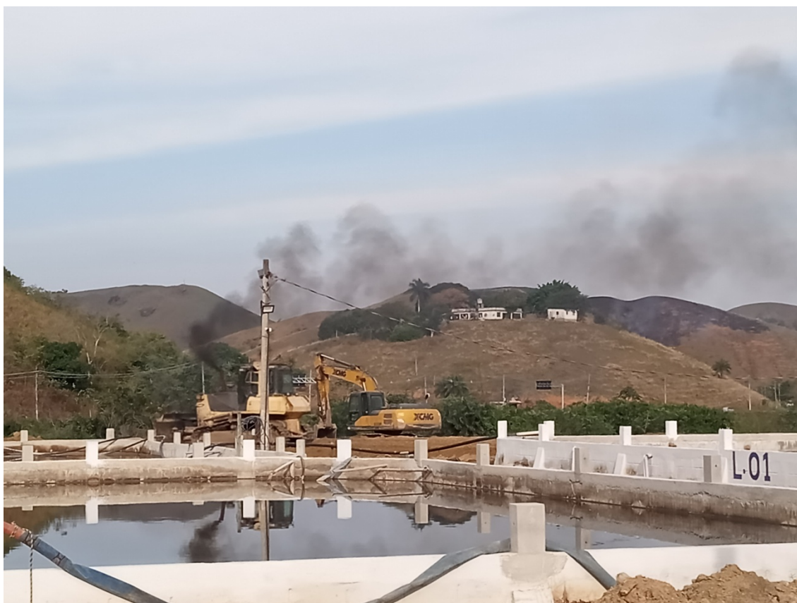
Figura 11: Construção das novas lagoas de recebimento de chorume
