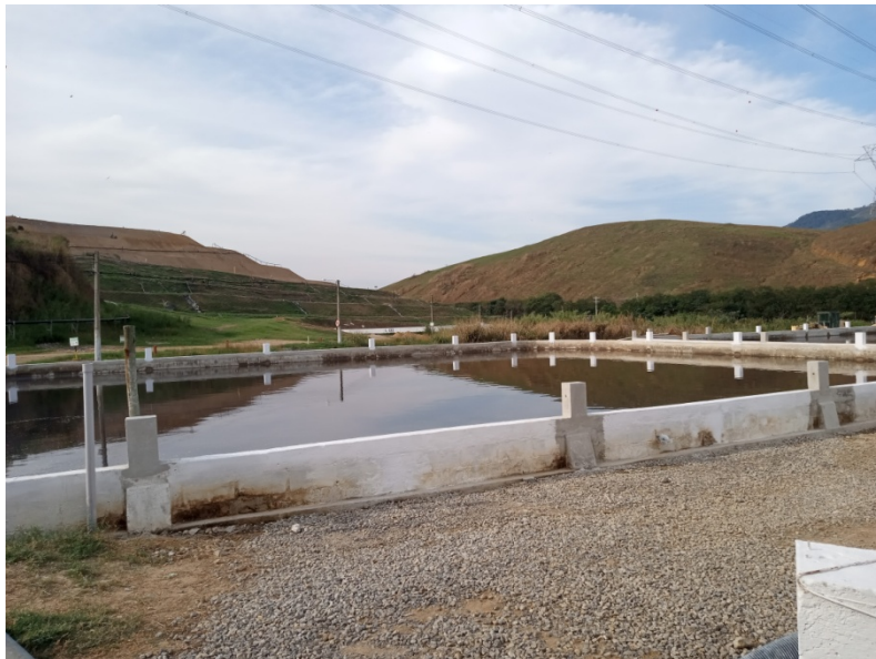
Figura 9: Lagoa de recebimento de chorume
