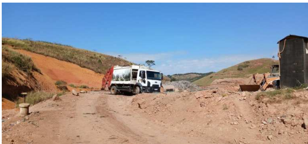
Figura 9: Acesso à frente de trabalho
