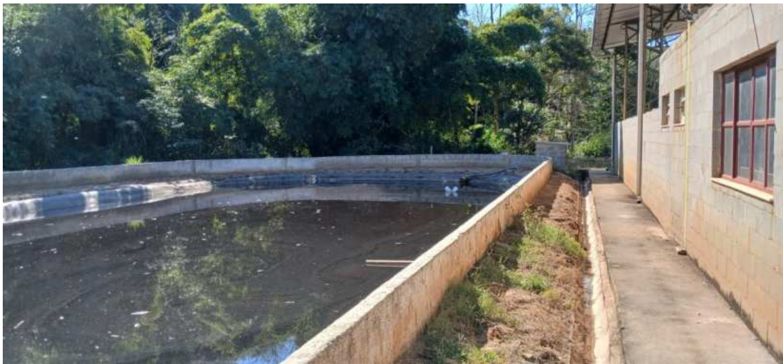
Figura 20: Lagoa de armazenamento de chorume
