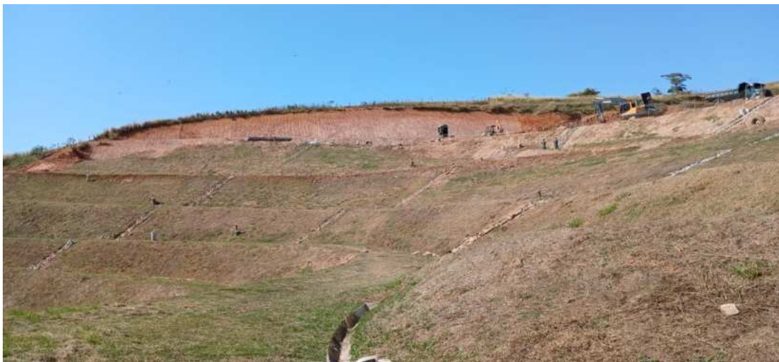
Figura 18: Maciço com recomposição vegetal
