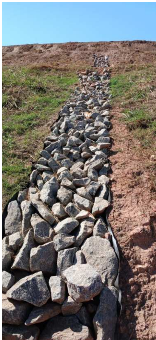
Figura 17: Sistema de drenagem
