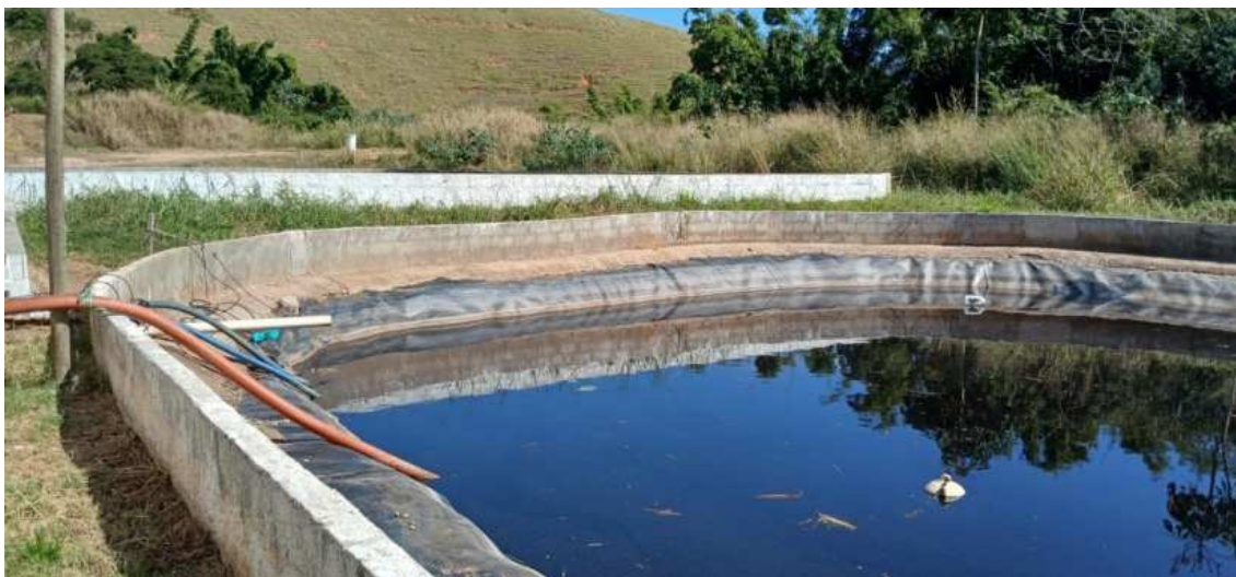
Figura 21: Lagoa de armazenamento de chorume
