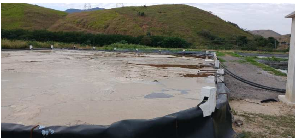
Figura 13: Lagoa secundária de recebimento de chorume
