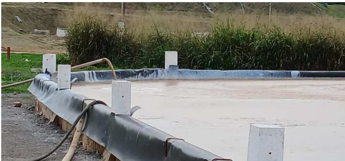
Figura 14: Lagoa secundária de recebimento de chorume, no detalhe , o fluxo de saída de chorume
