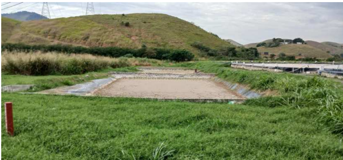
Figura 23: Leito de secagem do lodo
