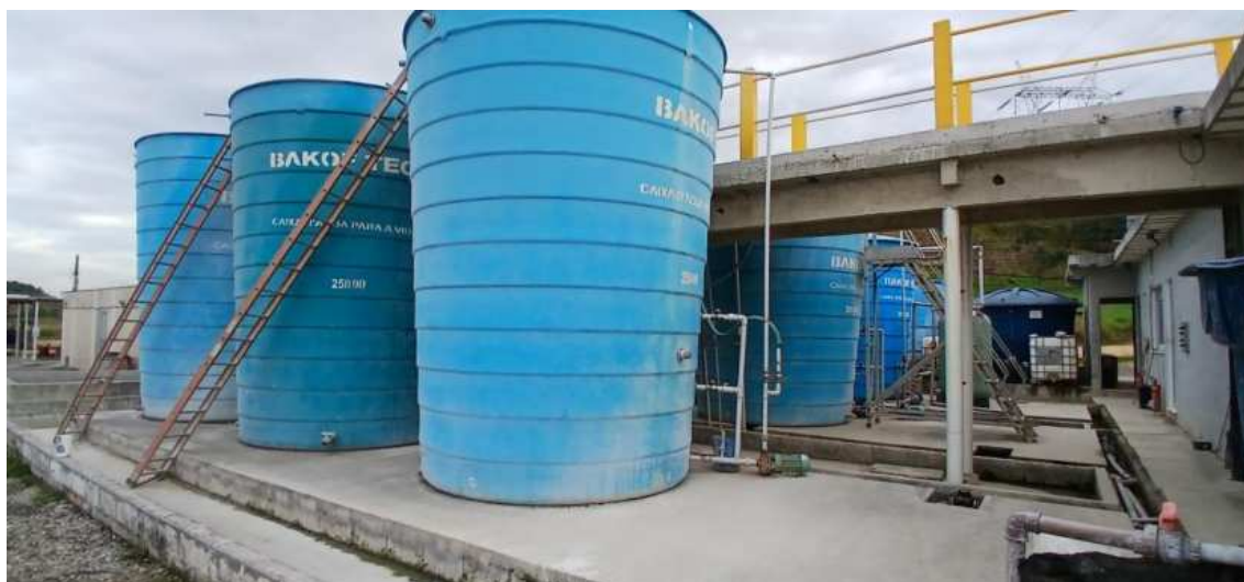
Figura 20: Tanques da Estação de tratamento
