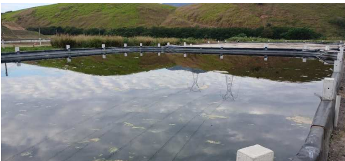
Figura 11: Lagoa secundária de recebimento de chorume
