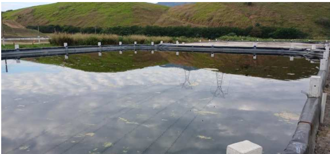
Figura 12: Lagoa secundária de recebimento de chorume
