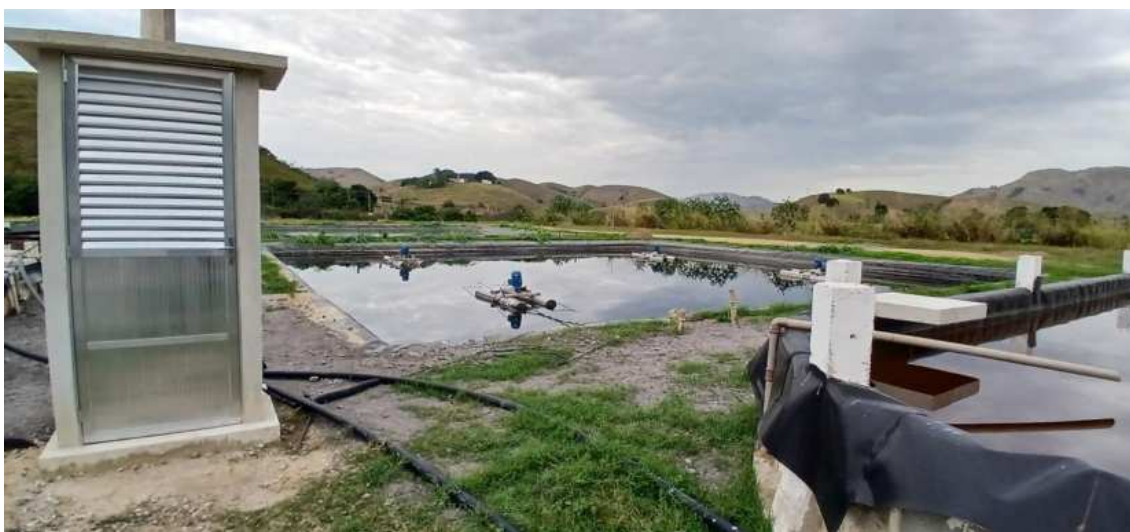
Figura 15: Lagoa secundária de recebimento de chorume com 4 aeradores
