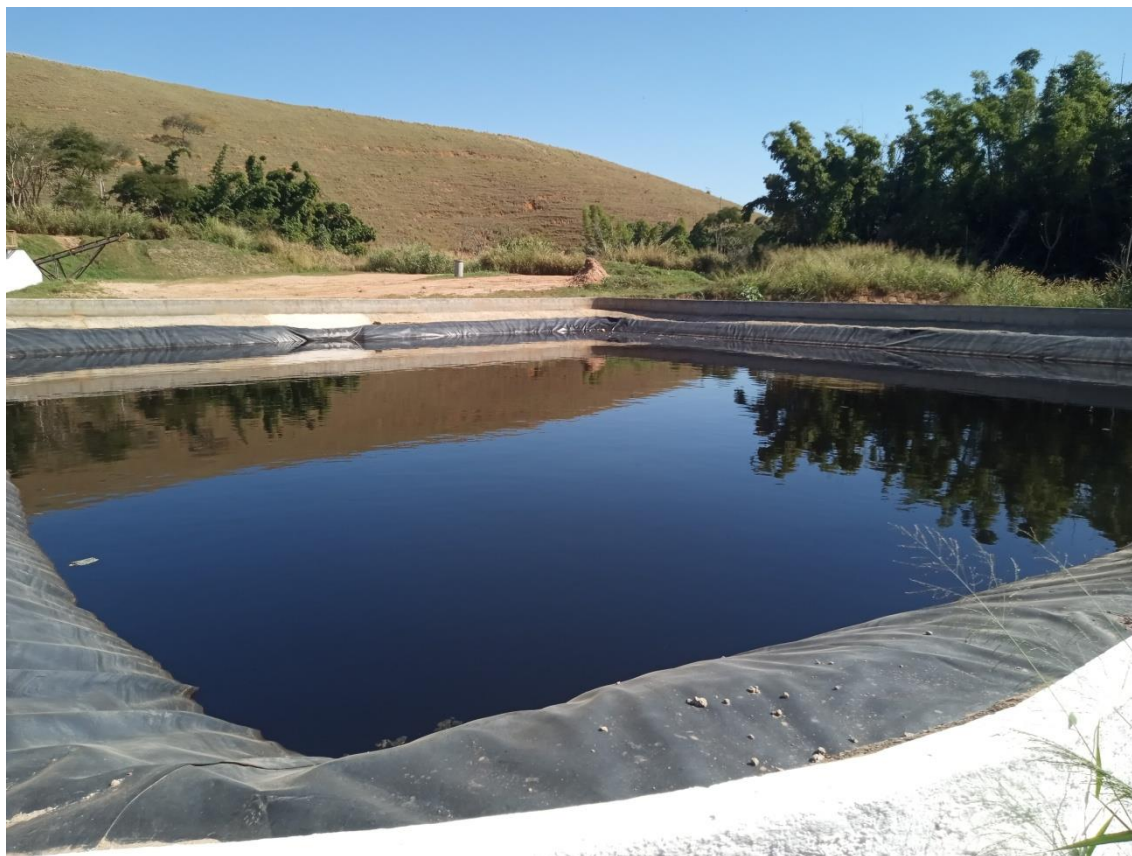
Figura 15: Lagoa de recebimento e armazenagem de chorume
