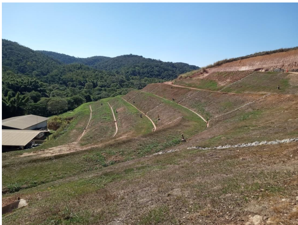
Figura13: Cobertura vegetal do talude
