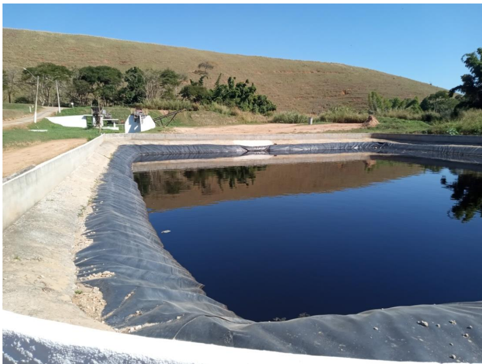
Figura16: Lagoa de recebimento e armazenagem de chorume
