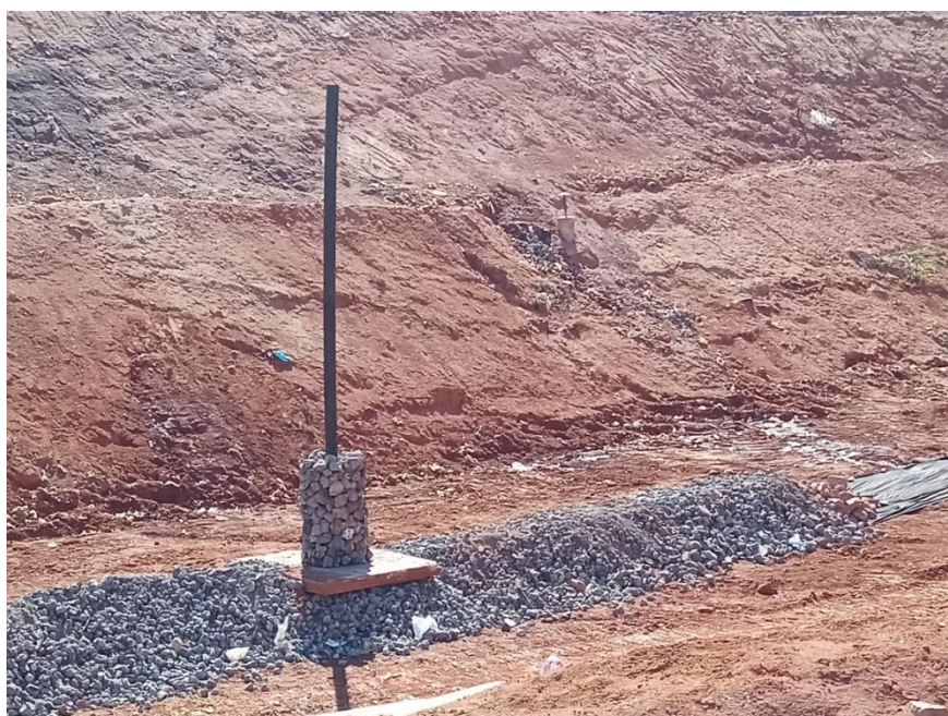
Figura 6: Em detalhe, a drenagem
