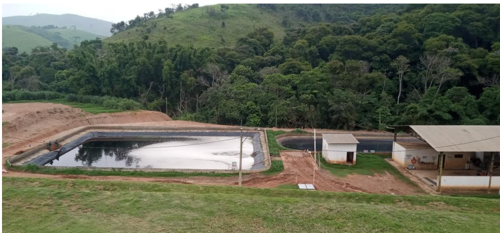
Figura 14: Vista das lagoas de acumulação de chorume
