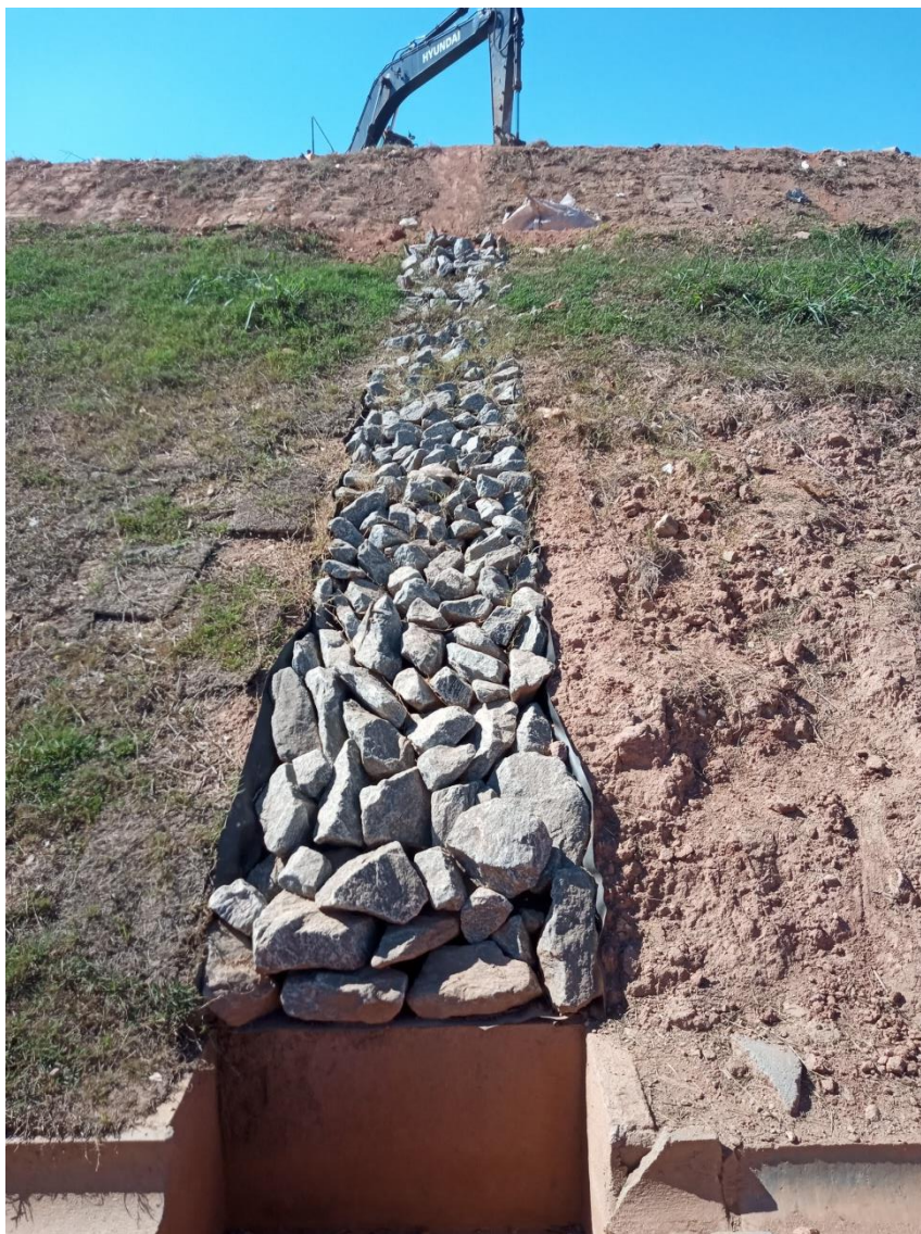
Figura 11: Detalhe do sistema de drenagem do talude
