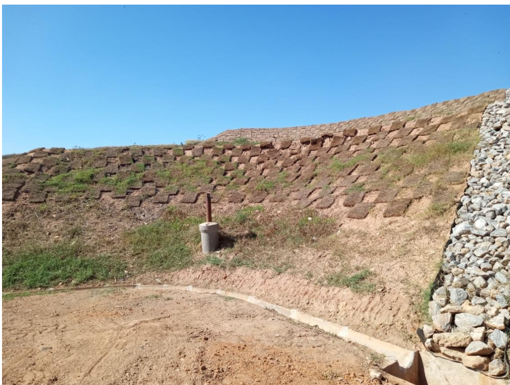
Figura 12: Cobertura vegetal do talude
